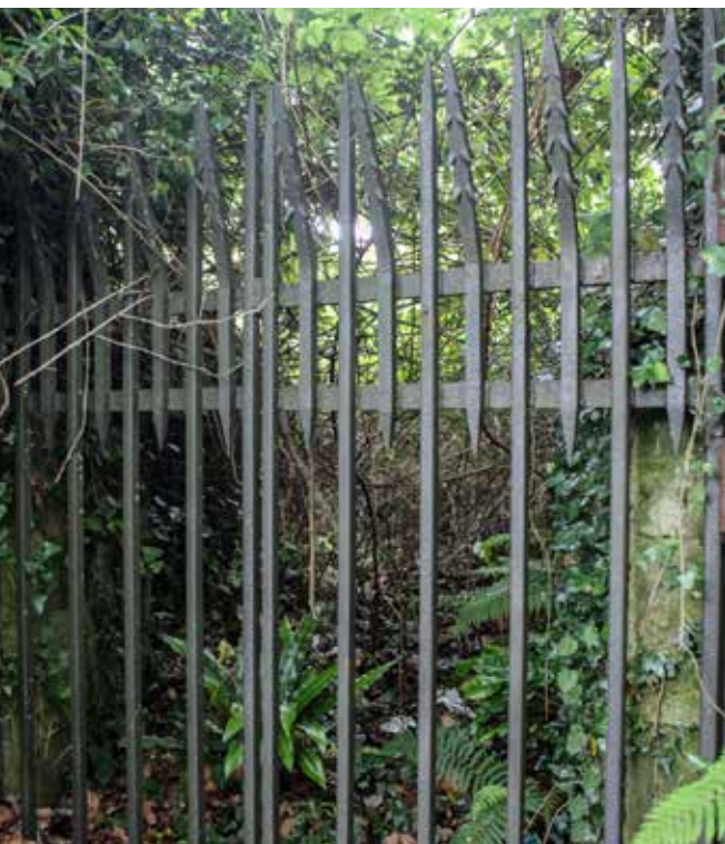
Verja defensiva de escarpa original en proximidad de la caponera SW, fotografiada hacia el año 1900 por Juan Roca. (© Patrimonio Nacional, Real Biblioteca). Coloreada. A Zócalo de mampostería revestido de arenisca. B Caballete formado por sillares calizos en los que se insertan postes y barrotos de la verja. Actualmente sustituido por hormigón. C Postes. D Refuerzos traseros metálicos de la verja. E Elementos salientes antiescalada.
