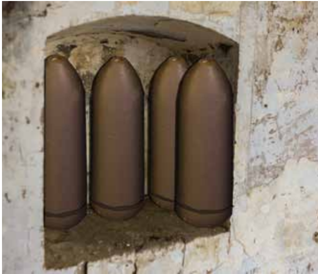
Repuesto de mano en el frente oriental de la Obra de la Derecha. Está incorporado en el revestimiento del parapeto y posiblemente dispusieron de una pertecilla de cierre.
