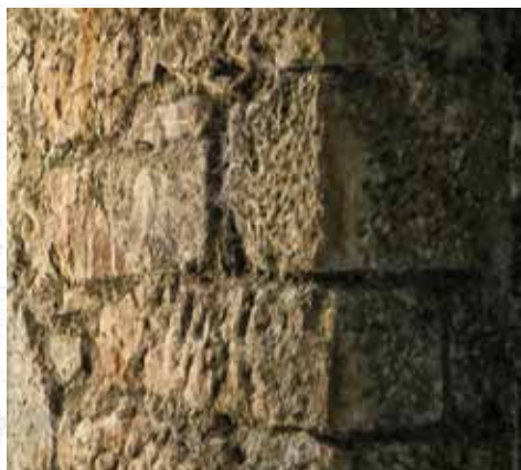
Grandes sillarejos desbastados forman las mamposterías del Fuerte, entendidas en este contexto como obras de fábrica en general (pabellón de oficiales de Infantería).
