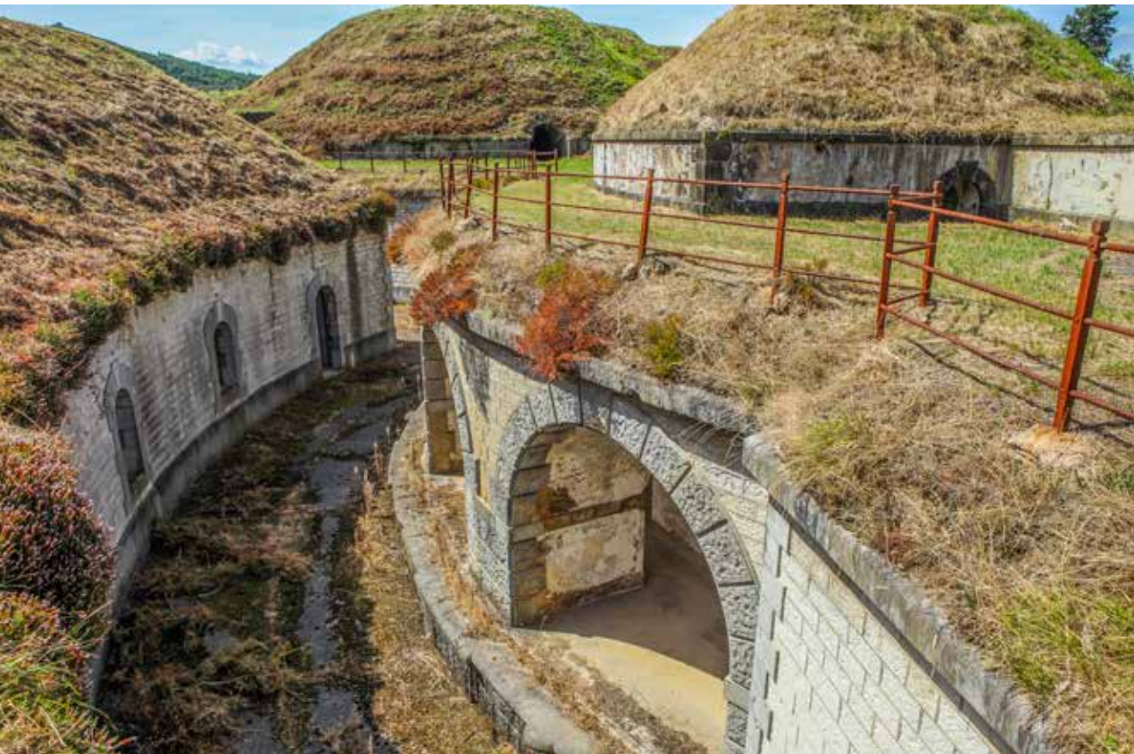
Patio de artillería. visto desde la planta de terraplenes. A la izquierda, el cuartel.
