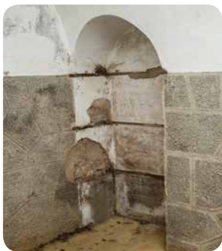
Armario en la caponera del Sureste. Se conservan vestigios de la fijación de tres estantes. Posiblemente no dispuso de puertas.
