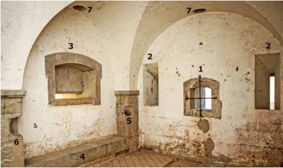
Interior de la semicaponera oeste. 1: Cañonera. 2: Aspilleras. 3: Matacán. 4: Banqueta. 5 y 6: Lanzaproyectiles. 7: Ventiladores.
