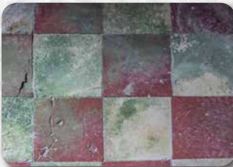
Baldosa sde la cocina del pabellón del gobernador, conservada parcialmente.
