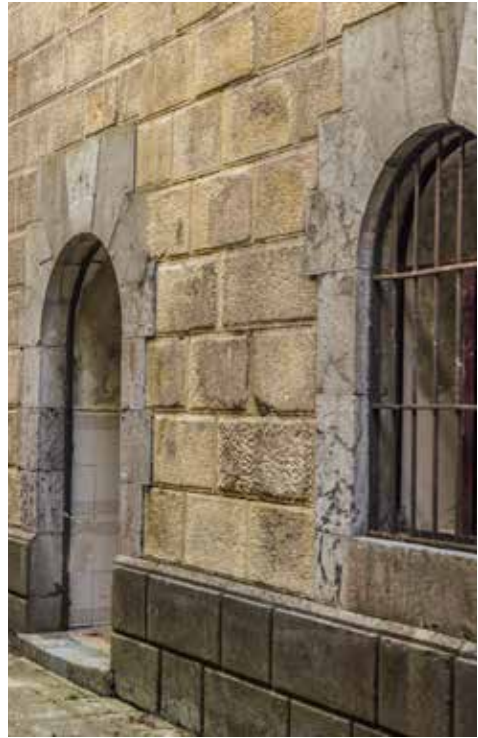
Ventana y acceso a las letrinas de tropa (1) en el patio de infantería.
