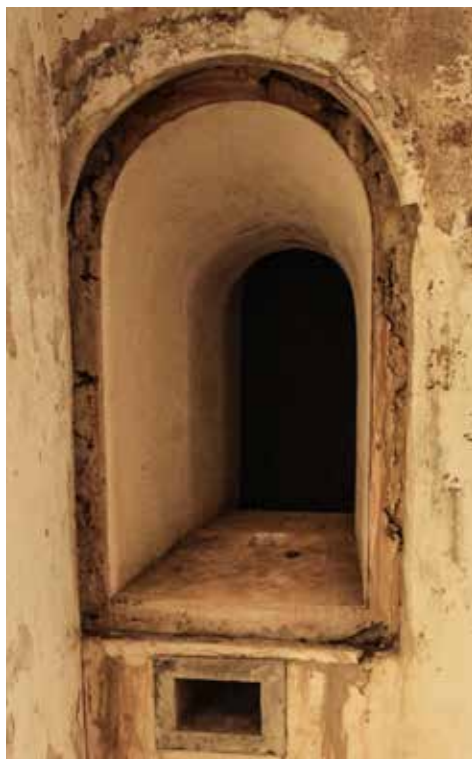
Ventana de luces de un depósito de distribución de munición de la Obra del Centro. El orificio inferior sirve para airear el interior del nicho. Falta la puerta de cierre.
