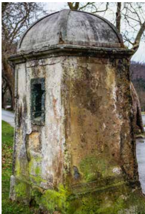
El lado de la garita opuesto a la entrada no posee mirilla.
