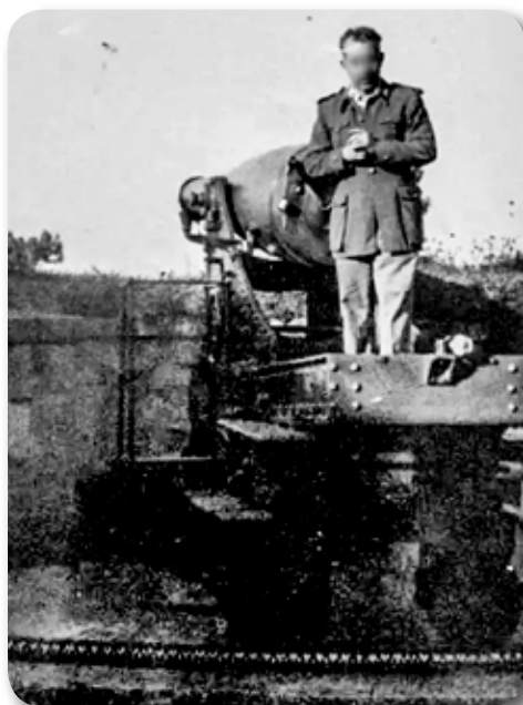
Cañón de H E “Ordóñez” de 15 cm sobre marco alto, en la Obra de la Derecha.
