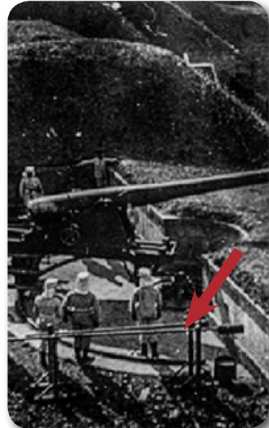
Caballetes para soporte del juego de armas de un Cañón HE "Ordóñez" de 15 cm en la obra de la Derecha del Fuerte.
