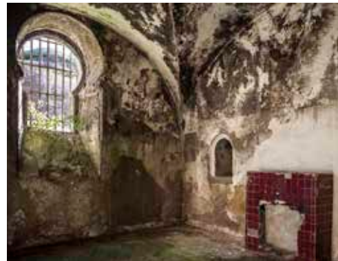
Comedor y sala de estar (5) de los oficiales de Infantería. Se aprecia la chimenea, alicatada con azulejos de color granate y a su izquierda la ventanilla de comunicación con la cocina, situada en la estancia contigua. A la izquierda una de las ventanas de aspecto árabe que caracterizan al patio de armas del Fuerte.
