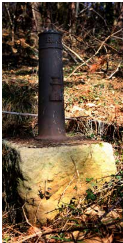
Uno de los mojones en su entorno natural, a 210 m del Fuerte. Conjunto de la base de piedra arenisca toscamente tallada y el hito de hierro fundido.
