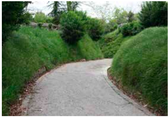
En pendiente, con curva cerrada a la derecha y en trinchera.
