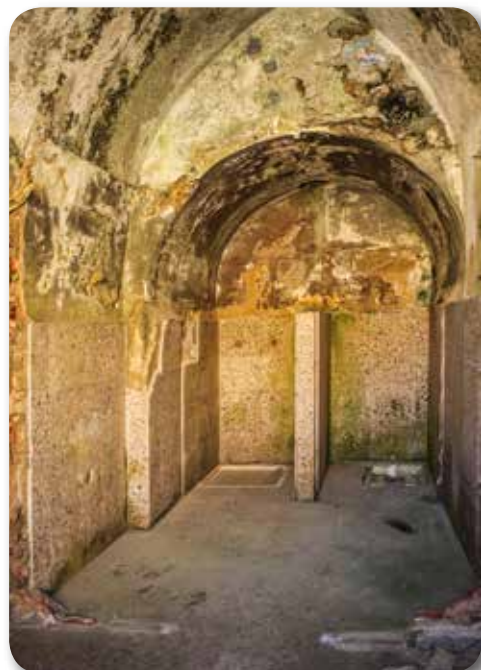
Vestíbulo y WC del Pabellón del Gobernador. Estado actual reformado en los años 60, incorporando ducha y wc turco para el pequeño destacamento de custodia..
