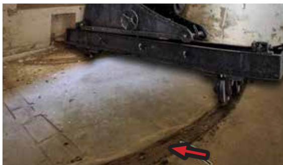
Montaje fotográfico de carrilera con un CHE "Ordóñez" de 15 cm en marco bajo en la batería acasamatada.
