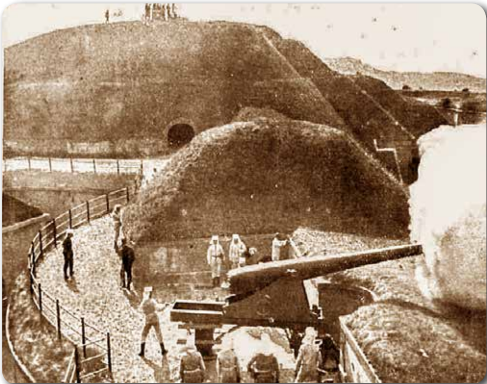
Fotografía de principios del siglo XX de un cañón Ordóñez de 15 cm sobre marco alto en el asentamiento oriental del frente norte de la Obra de la Derecha. Es una batería a barbata en la que los servidores están a cubierto por el parapeto y es la boca de fuego la que sobrepasa la altura del mismo mediante un montaje de marco alto.
