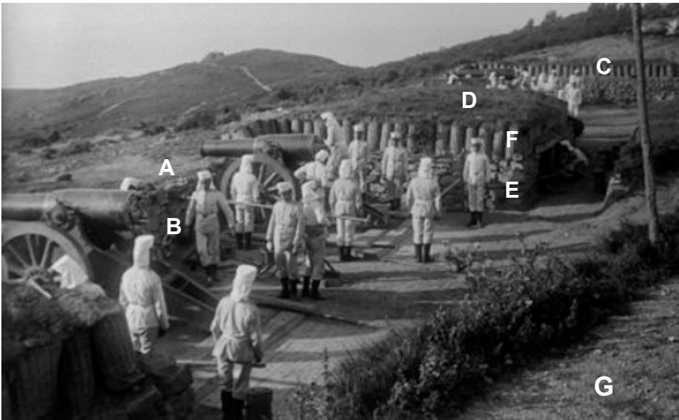
Batería de prácticas situada en proximidad de la entrada del fuerte de Guadalupe. El camino que se observa en el ángulo derecho (G) está muy cercano al acceso al Fuerte. La batería está artillada en este momento por obuses de bronce de 21 cm "Plasencia" sobre montaje Lerdo-Milán, material que también artillaba el Fuerte, aunque era normal que las propias unidades en prácticas utilizaran sus piezas. (Creative Commons. Aurelio de Colmenares, Archivo del Conde de Polentinos. IPCE, Ministerio de Educación, Cultura y Deporte").
