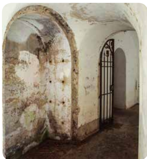
Armario situado entre la casamata oriental de la batería de fuegos curvos de la Obra de la Derecha y su repuesto de munición.
