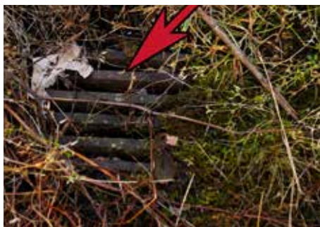
Sumidero en el patio de artillería (Obra de la Derecha).
