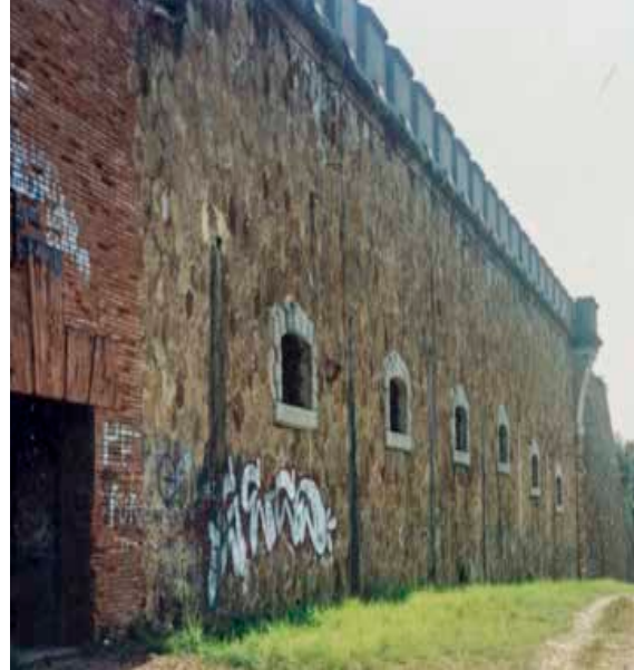
2 Fuerte de San Juliá de Ramis. Acceso y cuartel de gola del único fuerte del Campo Atrinchado de Gerona.
