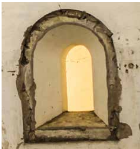
Ventana de iluminación o nicho de luces del repuesto de la batería de fuegos curvos de la Obra de la Derecha. Vista interior.
