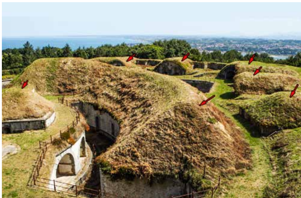
Principales blindajes superiores de tierra que cubren dependencias abovedadas de la Obra de la Derecha. En primer plano, el cuartel de artillería con su protección de tierra de sección triangular. El resto de los blindajes señalados con flechas corresponden a los traveses.
