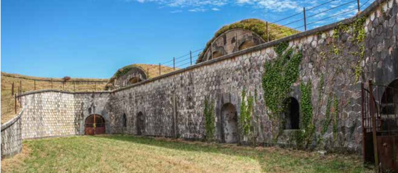
Patio oriental de la Obra de la Derecha visto desde su extremo norte. Se aprecia, a la izquierda, la rampa de acceso a los terraplenes de la Obra. Fot. inferior: vista desde el sur.
