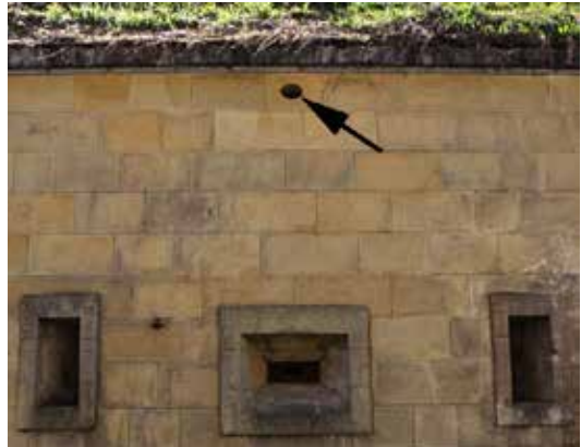
Galería de escarpa: en la parte superior del muro de máscara, con salida bajo el cordón de la escarpa.
