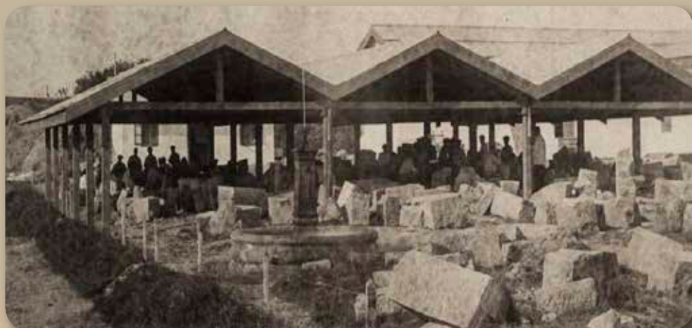
El campamento de obra estuvo situado en el entorno de la batería del Calvario. En el centro de la fotografía, el cobertizo del taller de cantería (13). En primer plano, la fuente Fot: J. Roca. © Patrimonio Nacional, Real Biblioteca.
