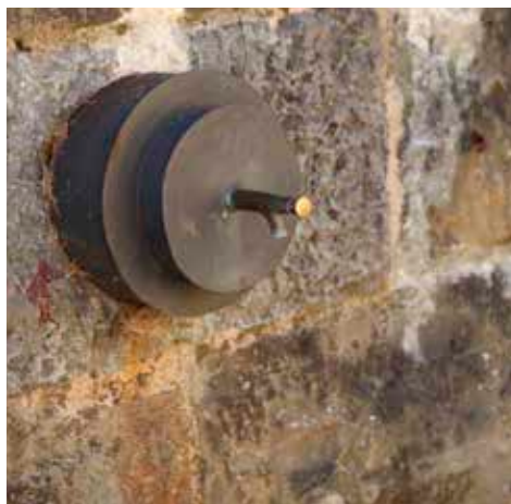
Grifo del depósito de reserva en la contraescarpa, cerca del cuerpo de guardia.
