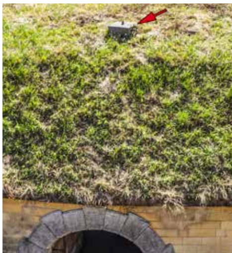
Situación del sillar de sujeción del pararrayos sobre el través central de la Obra del Centro.
