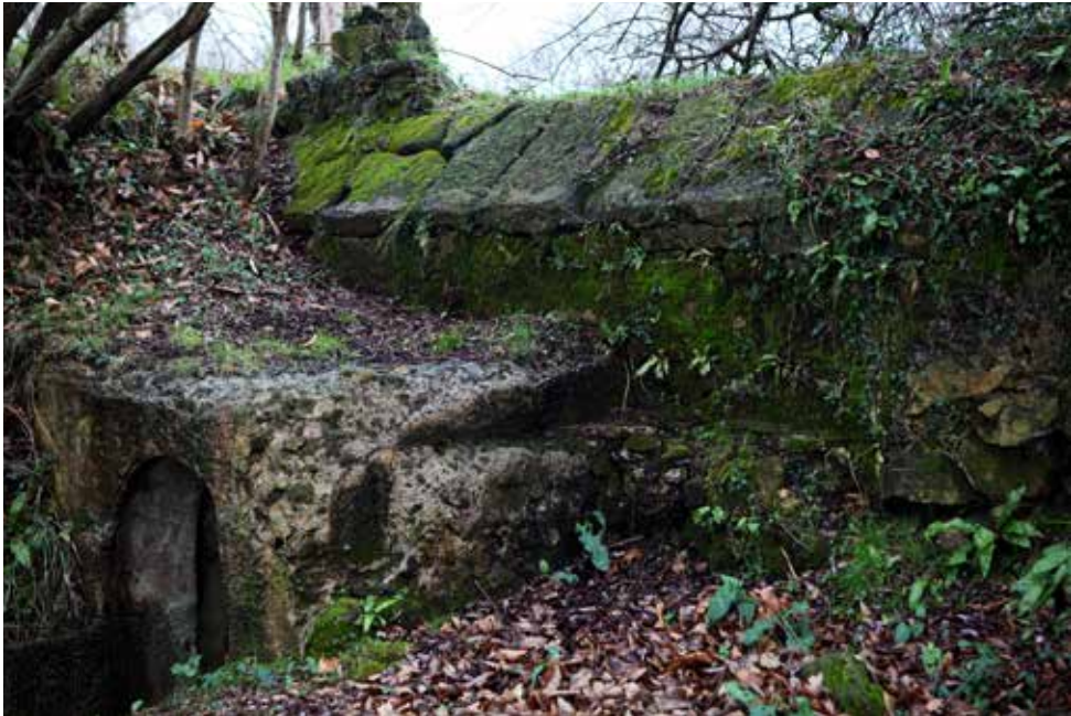
Revestimiento interior del parapeto y acceso al repuesto.
