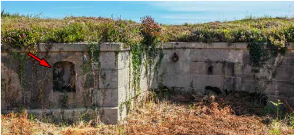
Repuesto de mano en el frente oriental de la Obra de la Derecha. Está incorporado en el revestimiento del parapeto y posiblemente dispusieron de una pertecilla de cierre.
