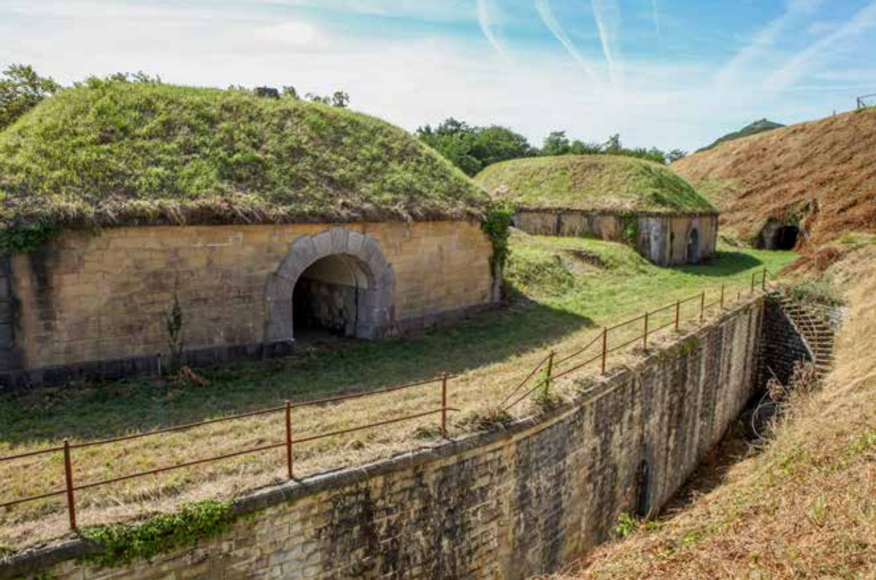
Obra del centro: patio de la obra, terraplén de servicio y traveses.
