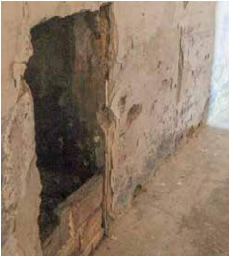
Espacio para la instalación de una estufa empotrada en la pared del pasillo de acceso a los pabellones de oficiales de infantería. En la parte superior dispone de un tubo de salida para humos.
