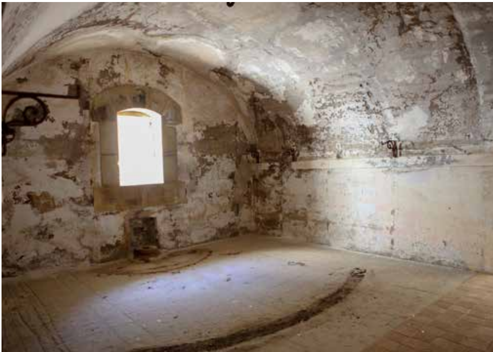
Basacarril (2) bajo una de las cañoneras del frente sur de la batería acasamatada de la Obra de la Izquierda, enfrentada a una cañonera túnel (actualmente cerrada).
