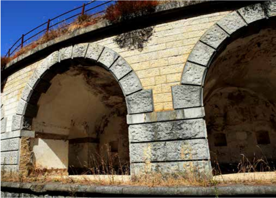
Bóvedas cónicas de la batería de fuegos curvos de la Obra de la Derecha.
