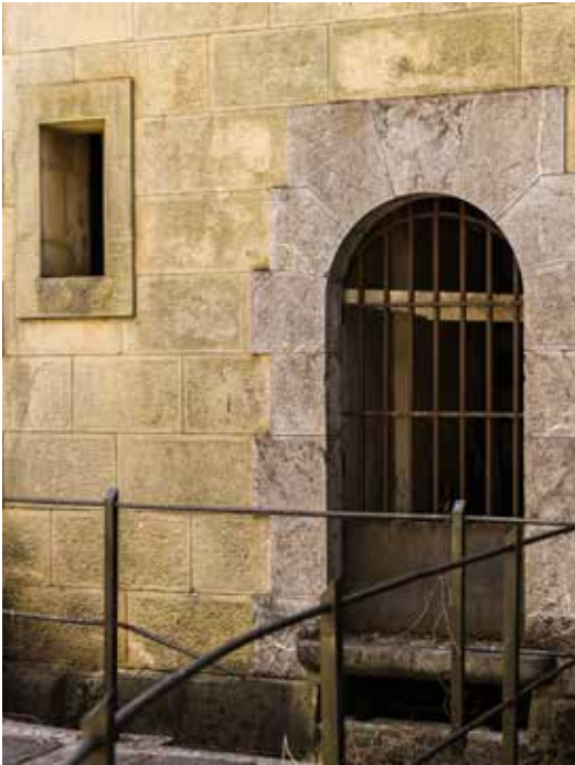
Puerta de guerra de la semicapenera SW (3). Disponía de puente móvil sobre el fosete del que perduran actualmente algunos vestigios..
