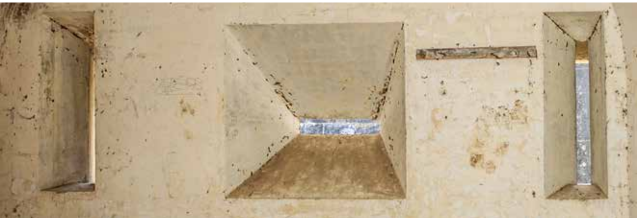
Aspilleras verticales y horizontal vistas desde el interior de una semicaponera.
