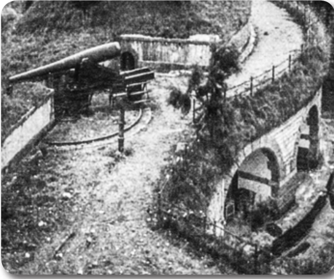
Frente norte de la Obra de la Derecha, en el que se aprecia uno de los dos cañones HE "Ordóñez" de 15 cm sobre marco alto, hacia el año 1940. Se trata de la misma pieza de la imagen inferior.
