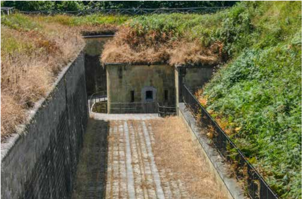
Caponera sureste (3) flanqueando un sector del foso mediante una cañonera y dos aspilleras. Se aprecia que la cota de la caponera es claramente inferior a la de la contraescarpa para de esa manera dificultar por desenfilada el impacto de proyectiles enemigos. A la izquierda de la fotografía se observa la contraescarpa y a la derecha el zócalo de mampostería revestido de sillar de arenisca y sobre él la verja de escarpa.
