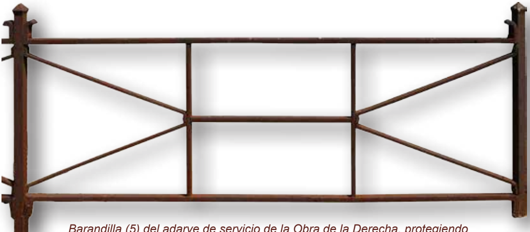
Barandilla (5) del adarve de servicio de la Obra de la Derecha, protegiendo la caída hacia el patio oriental. Además de 4 tramos completos como el de la fotografía, se conservan parte de los postes del resto.
