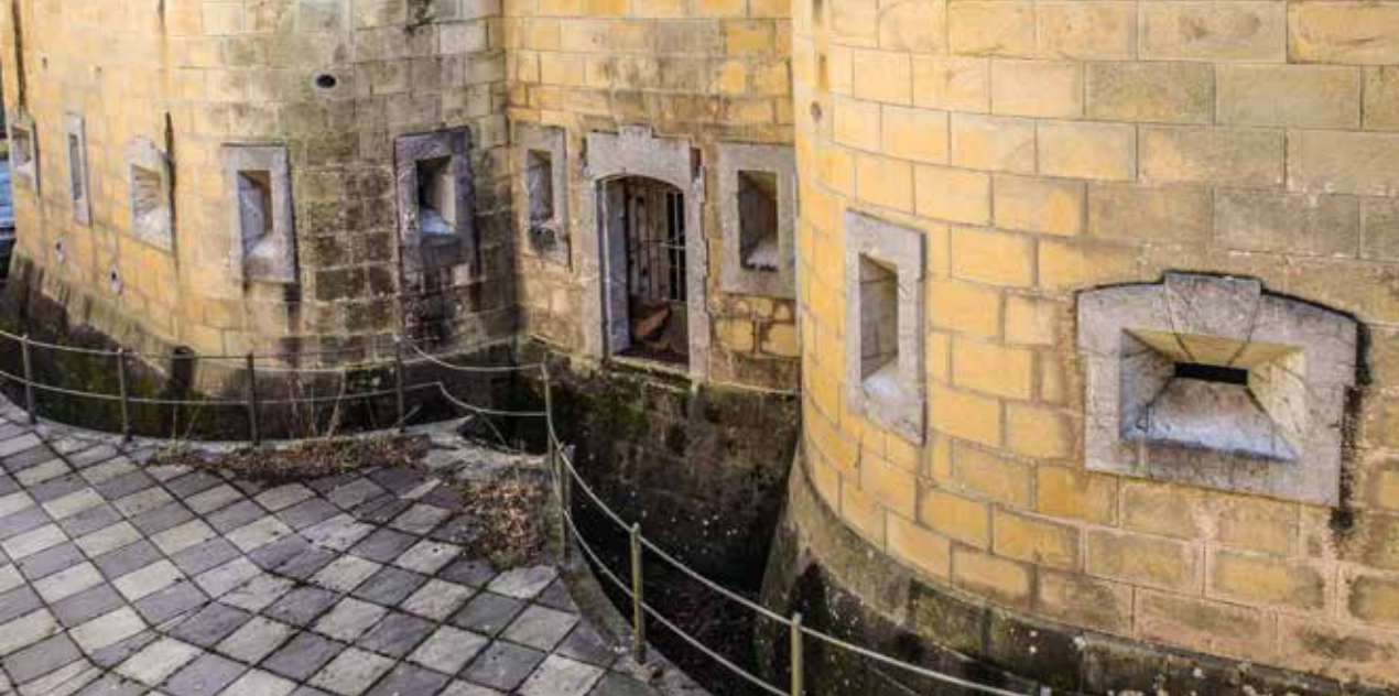
Aspilleras verticales y horizontales vistas exteriormente en la caponera de gola.
