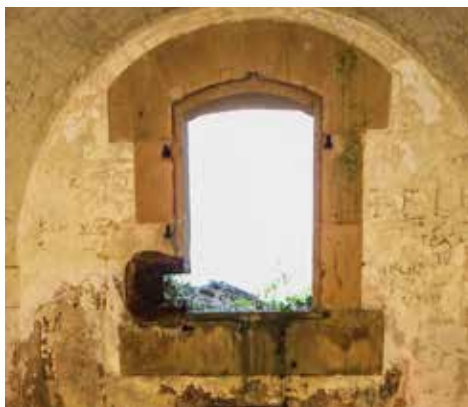
Batería acasamatada. Interior de una de las 5 cañoneras septentrionales abiertas (A).
