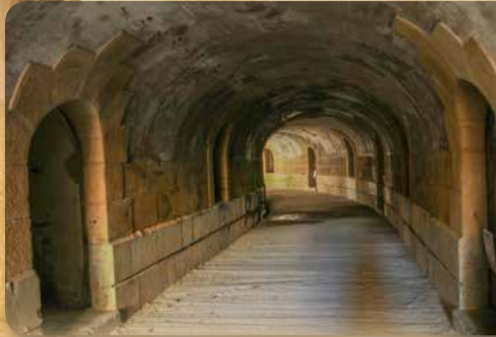
Poterna entre el patio principal y el patio de infantería (2).
