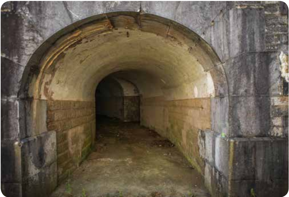
Obra de la Derecha. Poterna entre el patio de artillería y el patio oriental (7). Se aprecia el ramal a la Obra del Centro
