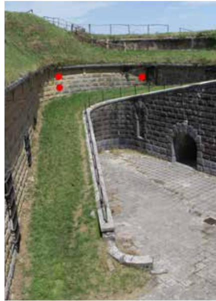
Argollones de arrastre en la rampa de la obra de la izquierda
