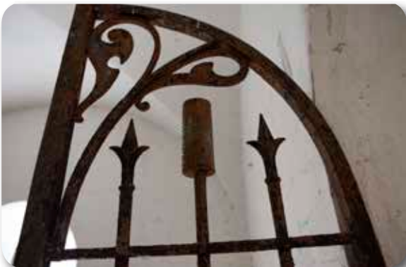
8 Acceso al repuesto munición de la batería de fuegos curvos de la Obra de la Derecha. Doble batiente.
