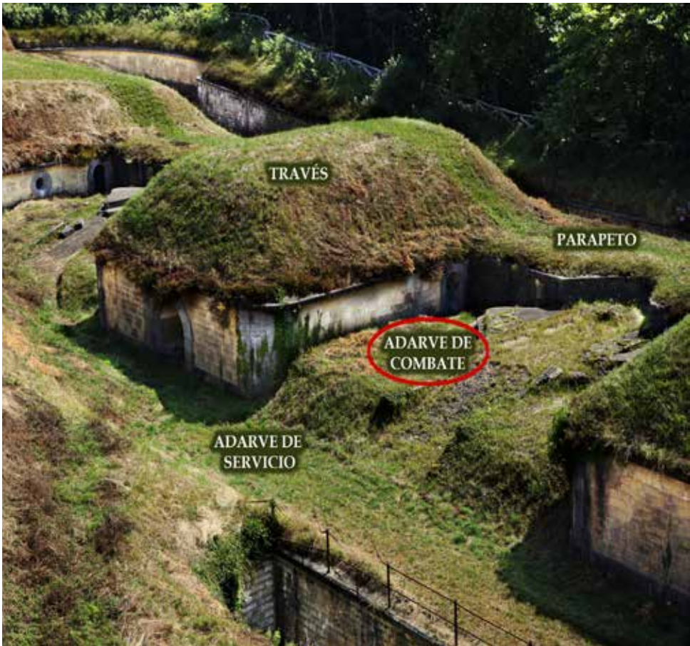
Obra del Centro. Se han señalado: el parapeto (cota 184,5 m), el adarve de combate (cota 182,7 m) y el adarve de servicio (cota 181,15 m). Las cotas se corresponden con las consignadas en el proyecto.
