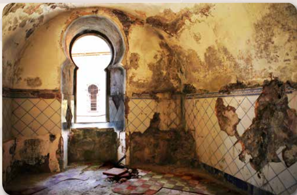
Alicatado de la cocina del gobernador en la Obra de la Izquierda.
