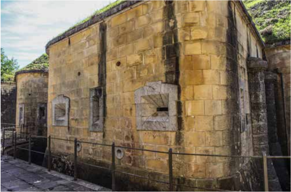
La caponera de gola defiende longitudinalmente el sector de foso de gola, es decir el correspondiente al frente marítimo del Fuerte. La barandilla es un añadido actual.
