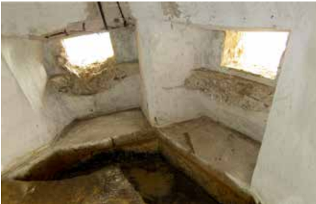
Centro de Resistencia 245 "Guadalupe". Interior de la obra 11, asentamiento para una ametralladora, situado 25 m al este de la "Sero-retxea" de Guadalupe y perfectamente visible desde la carretera. A pesar de tener dos aspilleras con sus correspondientes fosesets, sólo se le asigna una única arma.
