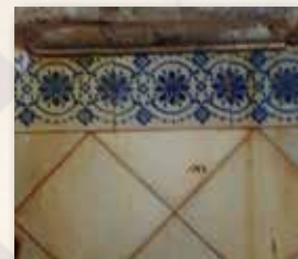
WC cuartel artillería.
