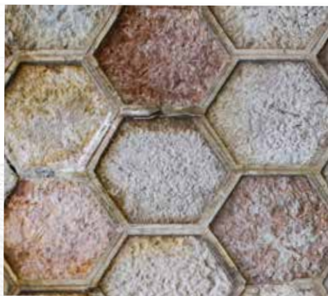
Mampostería concertada poligonal encintada en el patio oriental de la Obra de la Derecha.
