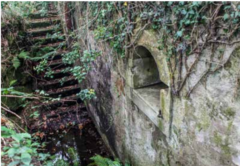
Exterior del depósito de distribución, cubierto por vegetación, a 1000 m del Fuerte. Se observa la escalera de acceso a los registros de la tubería de salida y el acceso al interior de uno de los dos depósitos que tiene en el interior.
