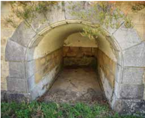
Abrigo (1) para artillería, Obra del Centro.
