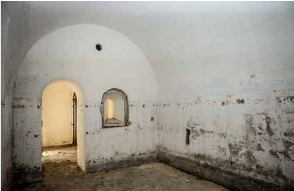
Repuesto Bat. fuegos curvos de la Obra de la derecha. Interior del depósito de pólvora (B), con su ventana de iluminación y el acceso al vestíbulo de la batería.
