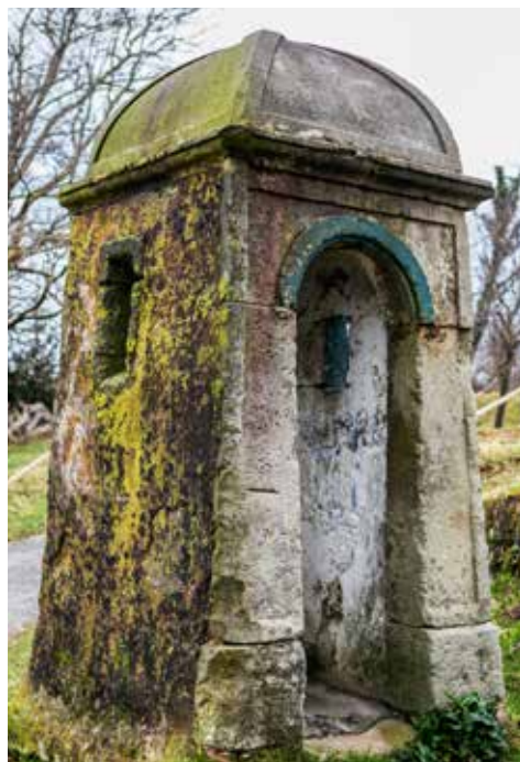
Lado de la garita en el que se abre el acceso. Se aprecian también las mirillas
