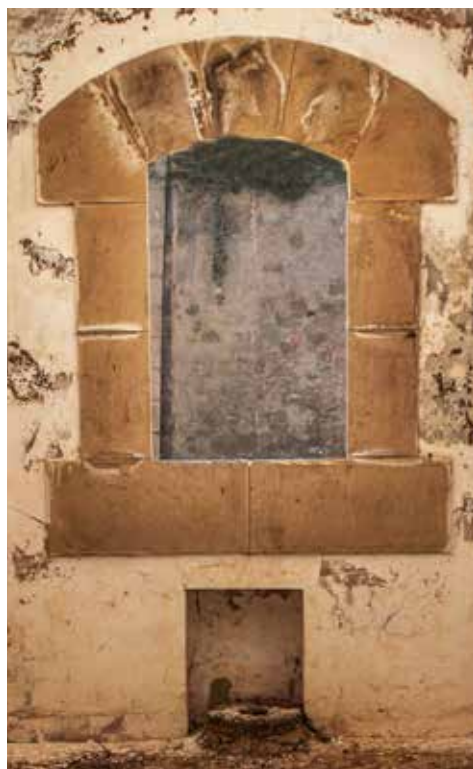
Batería acasamatada. Interior de la cañonera (B) orientada hacia el sur, frente a cañonera túnel, esta última cegada por un tabique. Bajo la cañonera se aprecia el hueco en el que sobresale el sector de basacarril, destinado a acoger al perno pinzote.
