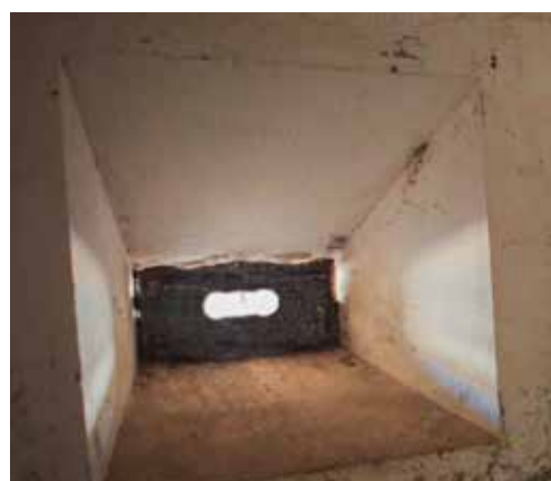
Izda aspilleras de la galería de escarpa. Dcha. Aspillera horizontal de la galería de escarpa con su porta metálica cerrada.
