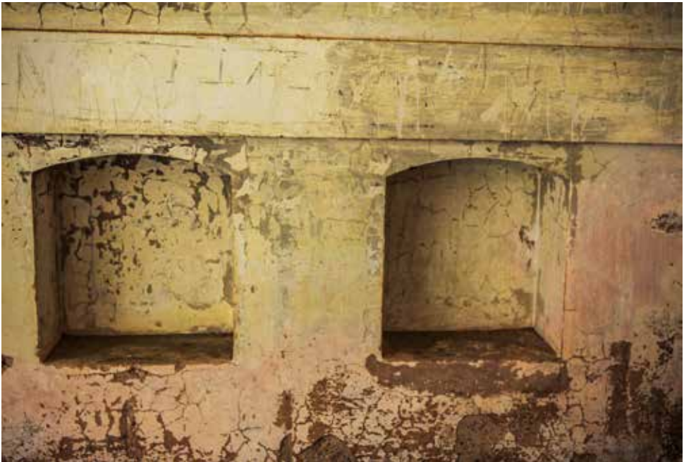
Detalle de los repuestos de mano para proyectiles del Cañón de Hierro Entubado "Ordóñez" de 15 cm, en el frente norte de la batería acasamatada en la Obra de la Izquierda
