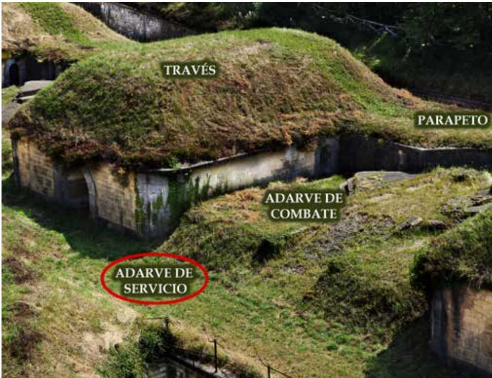
Adarve o terraplén de servicio de la Obra del Centro.
