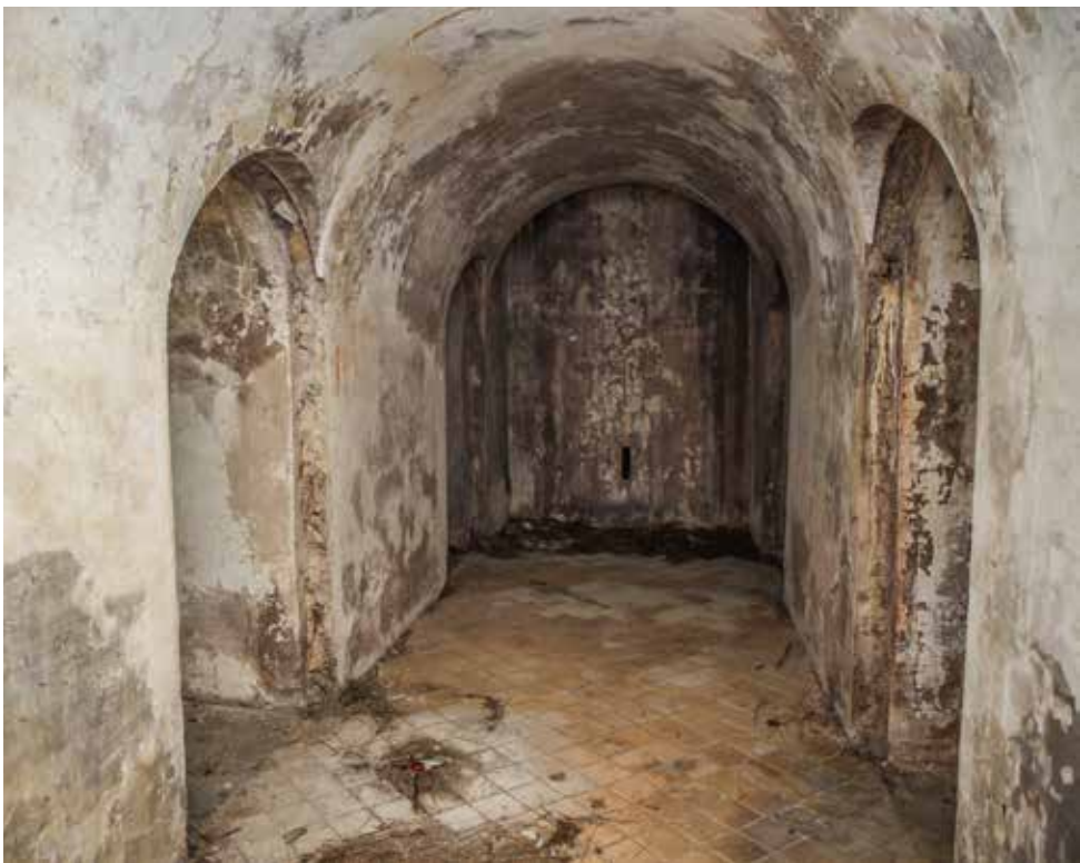
Depósito o almacén de distribución de la Obra de la Derecha (2). Bóveda de comunicación. A izquierda y derecha se aprecian los accesos a los depósitos propiamente dichos y al fondo la caja del montacargas de munición..
