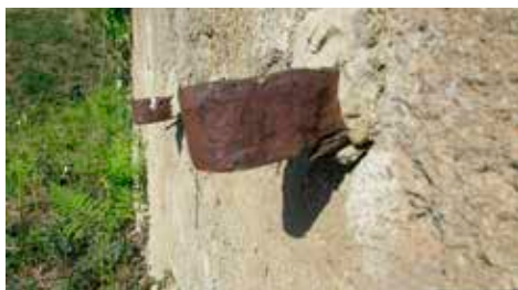
Anclajes de las escaleras (Frente norte de la Obra de la Derecha).
