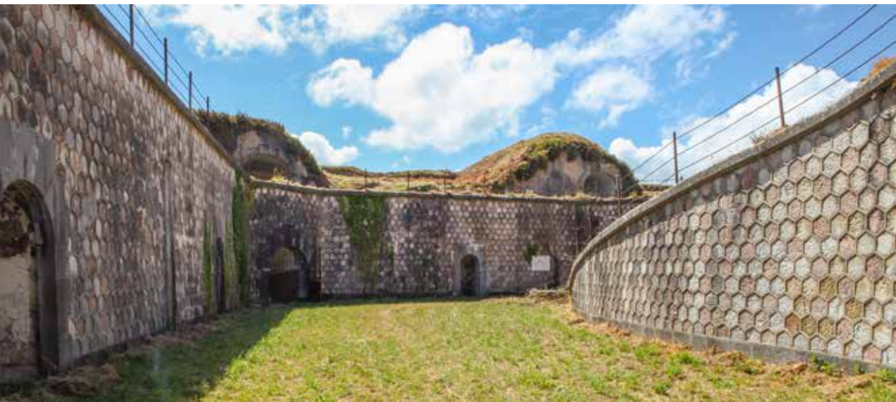
Fot. inferior: vista del patio desde la cubierta del cuartel de artillería. Se aprecian también los terraplenes de servicio y combate, así como los traveses del frente oriental.
