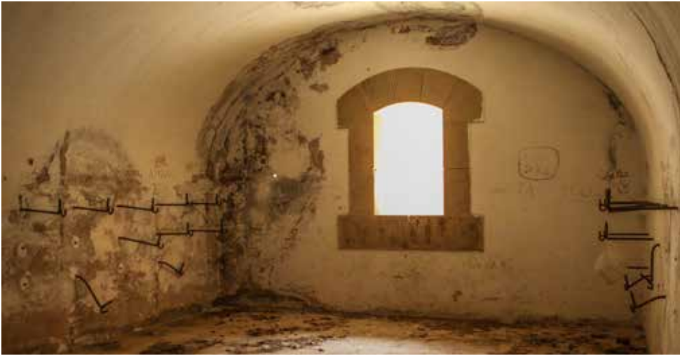
Frente sur de la batería acasamatada. Bóveda oriental. En los estribos de la bóveda sobresalen tres filas de soportes para los juegos de armas, parte de los cuales están cercenados.
