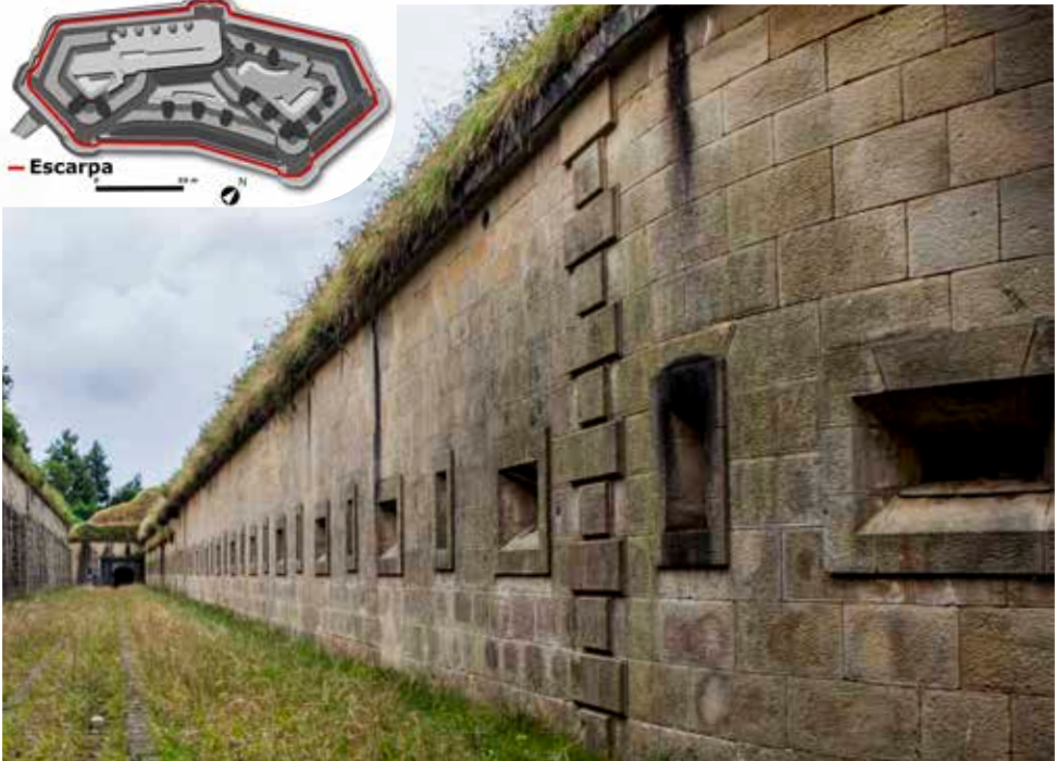
Escarpa de la Obra de la Izquierda, con su galería aspillerada. Al fondo la caponera de gola.
