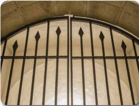
4 Antepuerta. Rastrillo con doble batiente y portillo, rematada con puntas de lanza.
