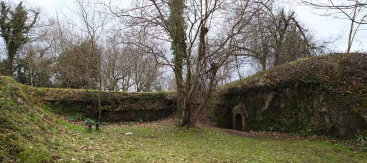
Bateria del Calvario. Se aprecia, al fondo, el parapeto y a la derecha uno de los traveses con la entrada al repuesto de munición.
