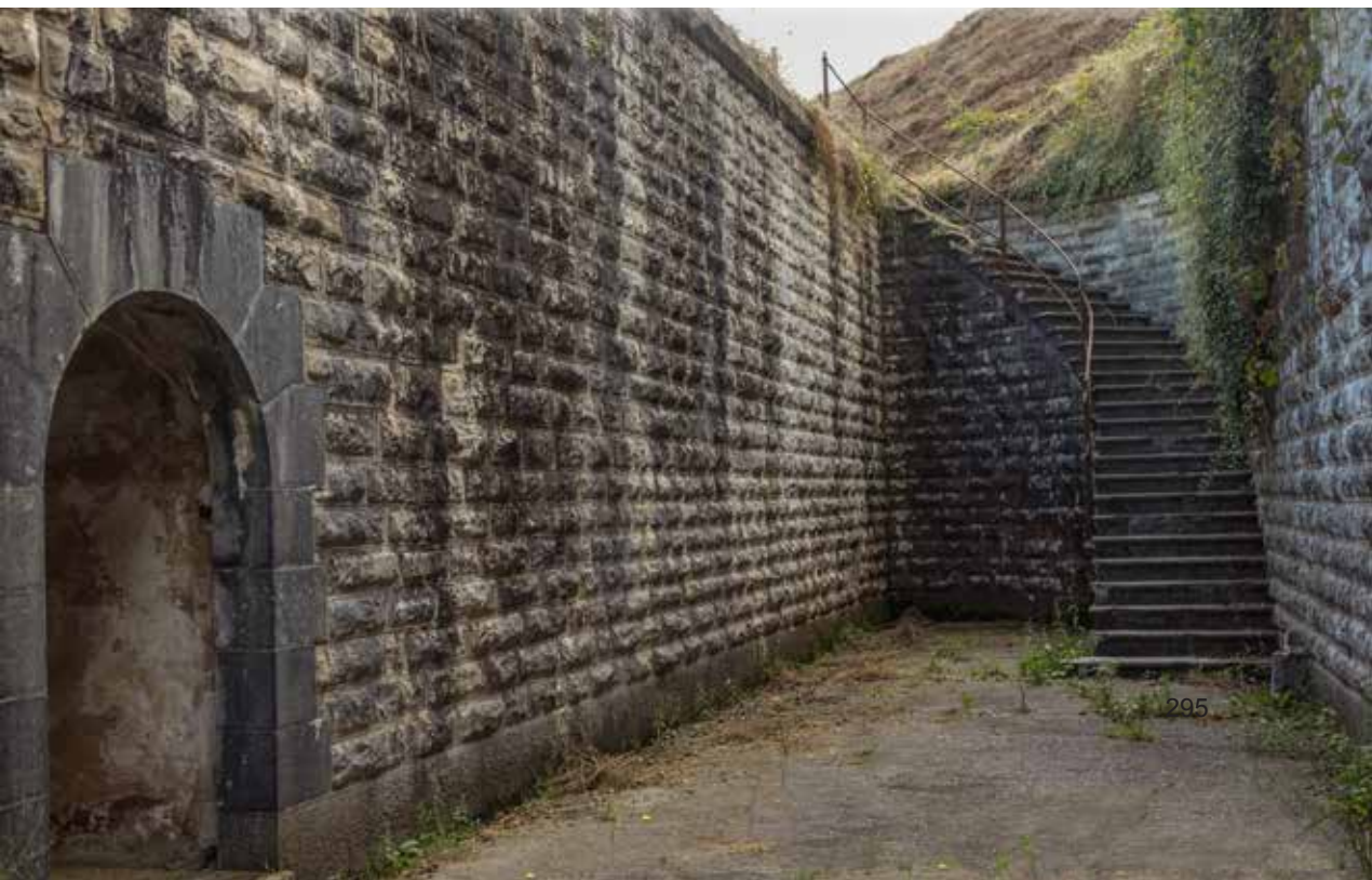
Acceso occidental al Almacén de Distribución de munición de la Obra del Centro y, al fondo la escalera que conecta el patio de la Obra del Centro con la planta de terraplenes.
