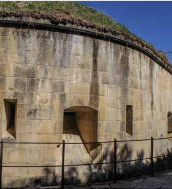
Caponera sureste. Vista desde el foso en el lugar donde no está flanqueada por artillería. Se aprecian los matacanes para defensa del fosete y dos aspilleras para defensa del tramo del foso.
