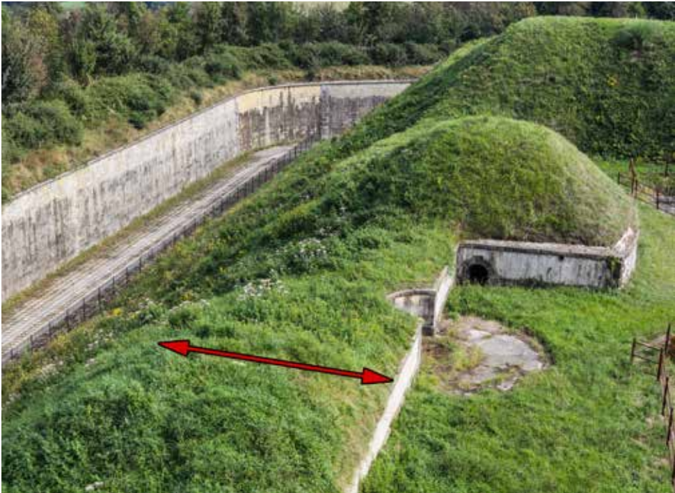
Paracascos en el frente norte de la Obra de la Derecha. En comparación con el través que se observa en la fotografía se aprecia que no corta el terraplén de combate ni tiene dependencias en su interior
