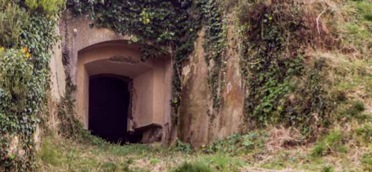
Batería acasamatada. Vista exterior de una de las cinco cañoneras septentrionales abiertas, con sus alas laterales.
