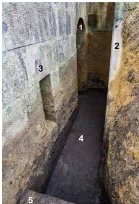
Caponera SE. Vista de la puerta (1) con el ala (2) y la aspillera (3) de vigilancia y defensa del camino de ronda (4) y de la verja (5).
