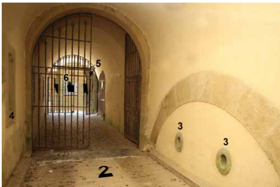
Defensa de la puerta de acceso al foso. 1 Seis aspilleras exteriores para fusilería. 2 Foso con puente móvil. 3 Dos lanzaproyectiles hacia el foso. 4 Seis aspilleras en el interior del túnel. 5 Reja o rastrillo con portillo. 6 Cañonera para cañón o ametralladora y dos aspilleras.
