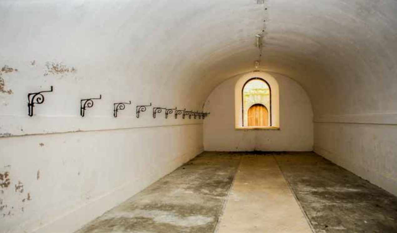
Bóveda en carpanel del cuartel de infantería. Al fondo, ventana hacia el patio de infantería.
