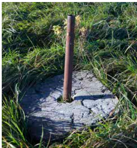
Sillar calizo de fijación del pararrayos oriental de la batería acasamatada.
