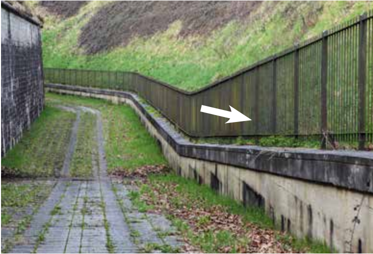
La escarpa del foso (a la derecha de la fotografía) está formada en las obras del Centro y de la Derecha por un zócalo sobre el que se levanta una verja metálica (la actual no es la original) y tras ella, un talud de tierra. Inicialmente estuvo prevista la construcción de un muro aspillerado en lugar de la verja. El muro en la izquierda de la fotografía es la contraescarpa.
