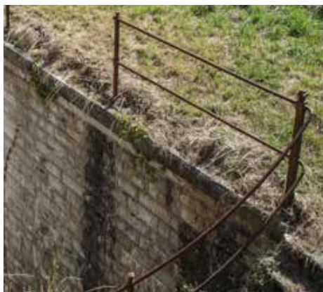
Barandilla (3) en torno al patio y escalera de la Obra del Centro. Se conserva aproximadamente en un 90%.
