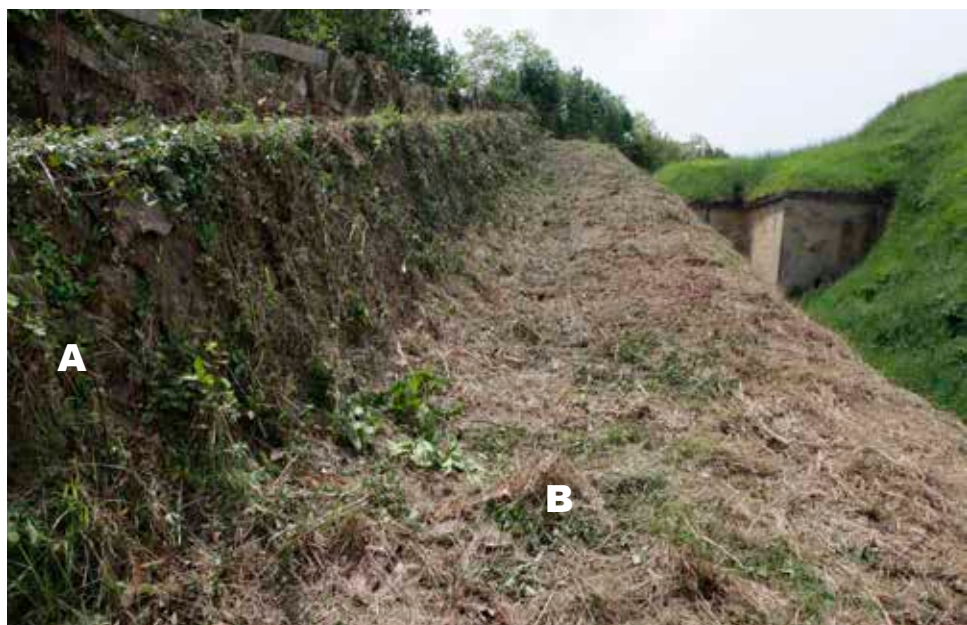
Camino cubierto y su parapeto ( A ) de fusilería en el tramo sur (revestido), perfectamente conservado, con excepción del suelo ( B ), que era de piedrilla sobre recebo de arena.
