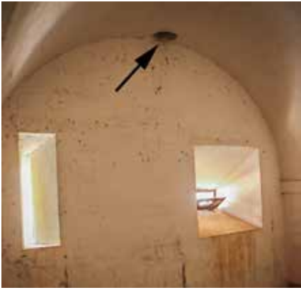
Galería de escarpa: en la parte superior del muro de máscara, con salida bajo el cordón de la escarpa.
