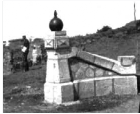
Embocadura izquierda completa, rematada por una bombeta, símbolo de Artillería. Estado hacia 1906.
