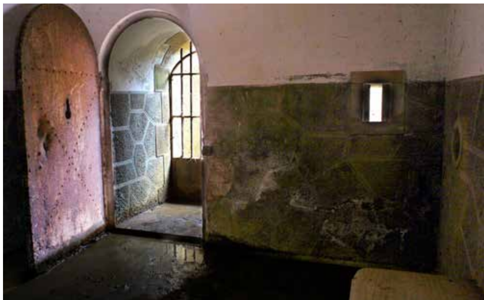
Interior de una dependencia anexa a la caponera sureste (3). A la izquierda, la puerta de acceso al camino de ronda y a su derecha la aspillera de defensa del mismo. A la derecha, en primer plano: la boca de un lanzaproyectiles y la banqueta de un matacán.
