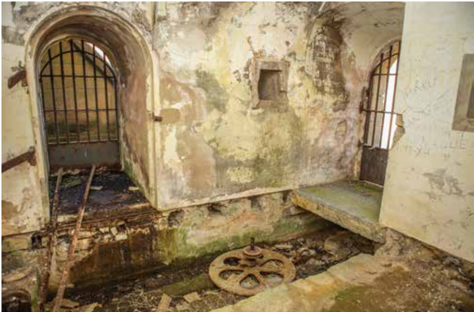
Interior de la estancia donde se abre la puerta de guerra (a la derecha) en el entorno de la semicaponera oriental (2). El pequeño foso corresponde al espacio donde evolucionaba el puente móvil, que estaba bajo el piso (que ahora falta). La puerta de la izquierda corresponde a la salida al camino de ronda que recorre el espacio posterior a la reja de escarpa.
