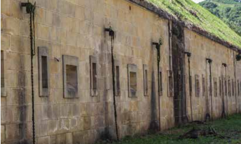
Seis de las ocho cadenas de lluvia, incorporadas como solución para conducción de aguas.
