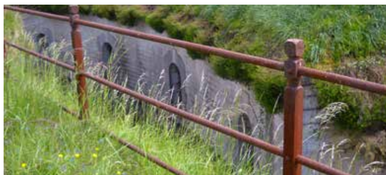
Barandilla (4) de la Obra de la Derecha que protege de las caídas hacia el patio de artillería. Se conserva íntegramente
