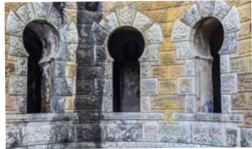
Fachada exterior, al patio de armas, de los pabellones de oficiales de Infantería. Llamam la atención los arcos de aspecto árabe.
