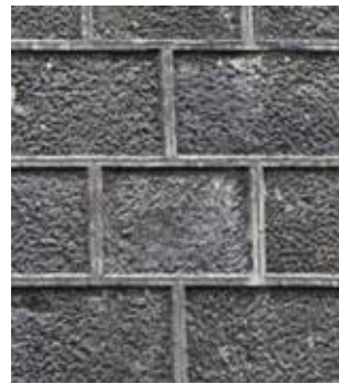
Sillarejo calizo con las juntas encintadas.
