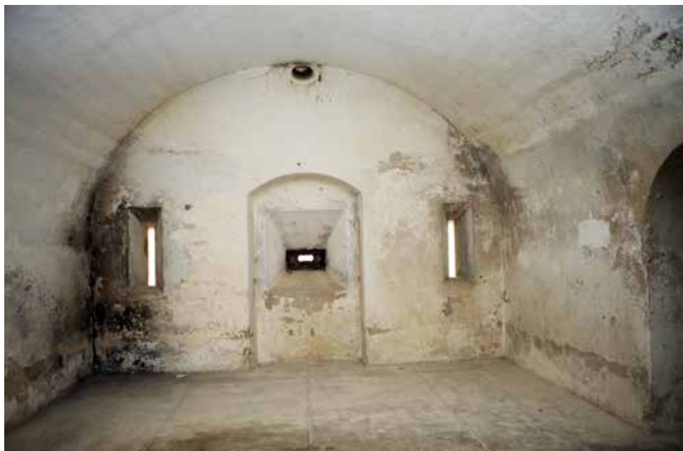
Bóveda de la planta inferior del cuartel de infantería que hace también la función de galería de escarpa. Se observa que está enfoscada convenientemente, cubriendo los estribos de mampostería y la bóveda de hormigón, confiriéndole un aspecto uniforme.
