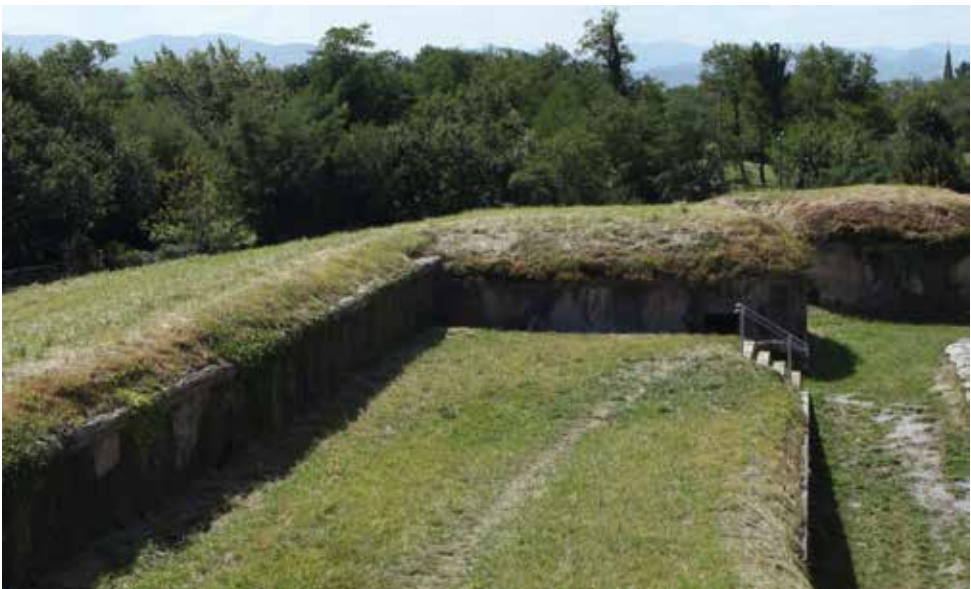
Otro ejemplo de batería a barbata en el Fuerte son los diversos frentes de la Obra de la Izquierda, en este caso sin explanadas para las piezas de artillería..
