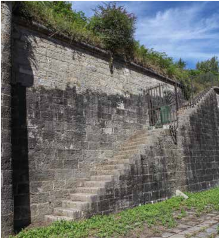
Escalera de contraescarpa próxima a la semicaponera SW (3) cerrada mediante reja metálica de época indeterminada, dotada de puerta con cerrojo y elementos punzantes.
