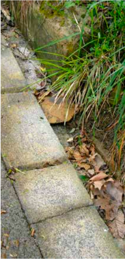
Cuneta para recogida de las aguas pluviales (estado actual).
