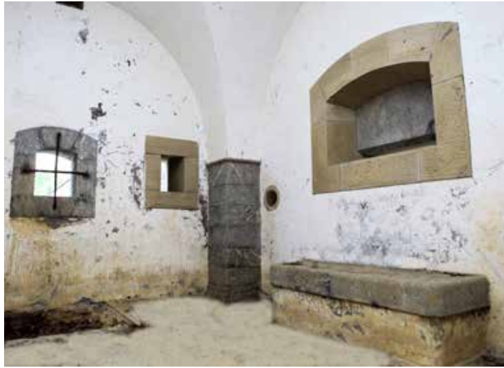
Matabacán y su banqueta (a la derecha de la fotografía) en el interior de la caponera SE. A la izquierda se aprecia la cañonera y una de las aspilleras para flanqueo del foso
