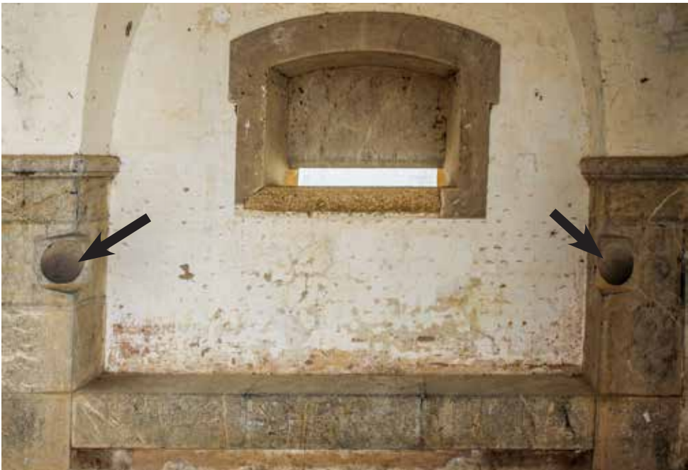
Boca interior de dos tubos lanzaproyectiles para defensa del fosete de la semicaponera oeste. Se aprecia también, entre ambos, un matacán con su banqueta.
