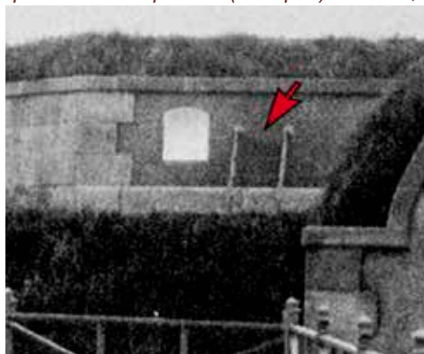
Escalera de parapeto, frente este, Obra de la Derecha, en una fotografía del año 1900
