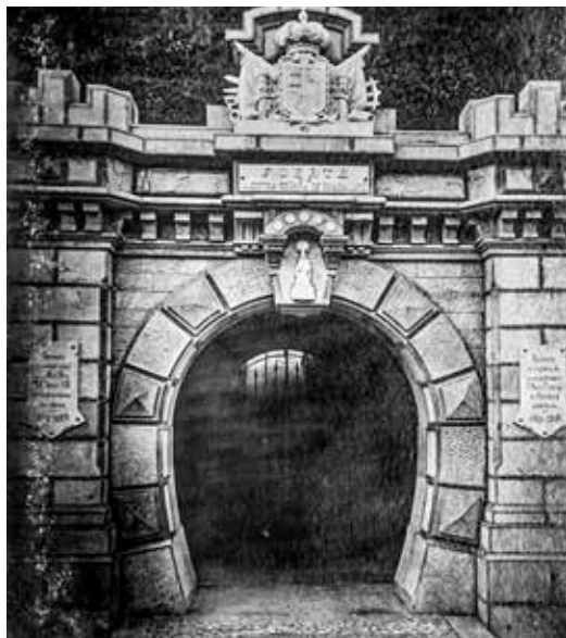
La puerta principal desemboca en una poterna en rampa que une el foso con el patio de armas.
