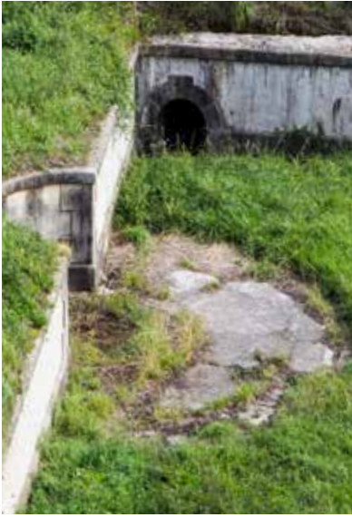
Explanada de un CHE de 15 cm sobre marco alto en el frente norte de la Obra de la Derecha.
