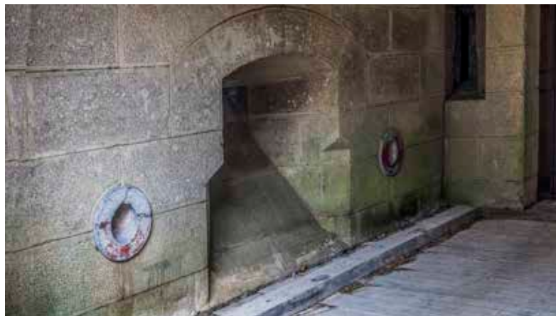
Interior del vestíbulo de la puerta principal. Se observa a la derecha de la fotografía el arco de descarga del muro, las dos bocas de los lanzaproyectiles y la poterna de acceso al patio principal con una aspillera frontal a cada lado.
