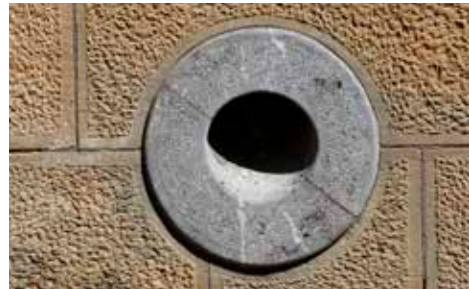
Detalle del aspecto de la boca exterior de un tubo lanzaproyectiles.
