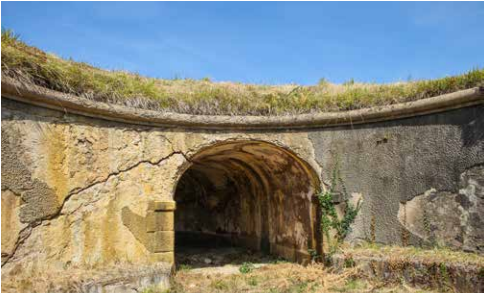
Gola del asentamiento circular sureste en la Obra de la Derecha, visto desde su interior. Se aprecia el túnel de acceso, bajo el parapeto, así como el cordón.
