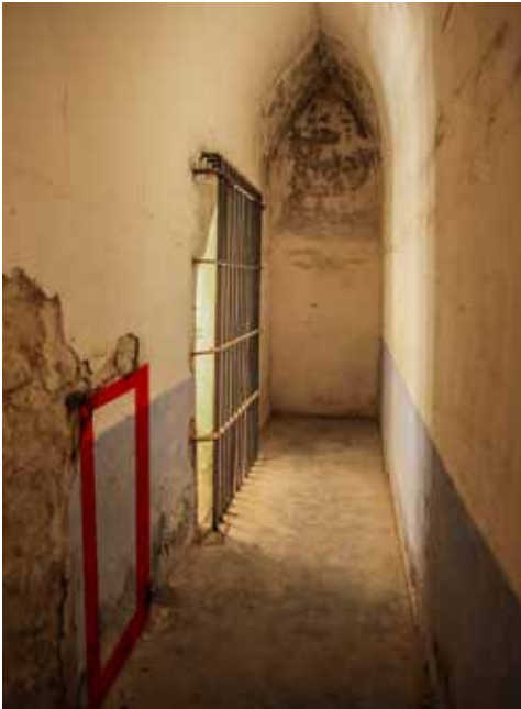
Espacio tabicado para la instalación de una estufa en el pasillo de comunicación entre los pabellones de oficiales de Infantería y la poterna de comunicación entre el patio de Armas y el patio de infantería.
