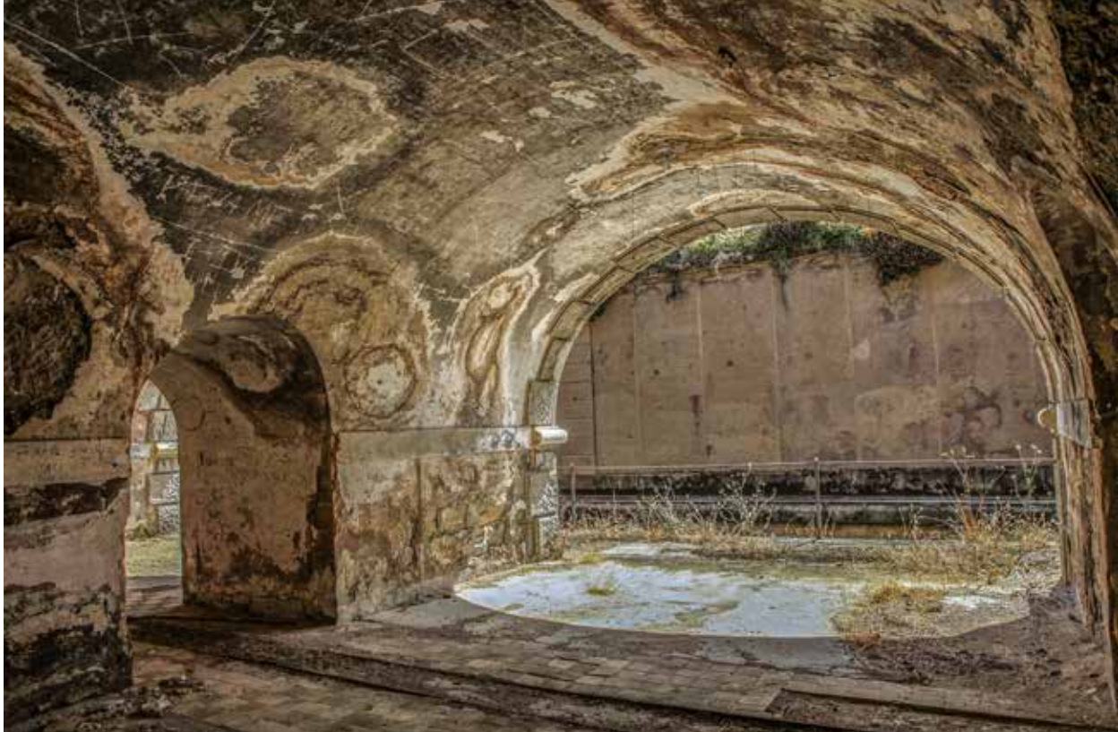
Casamata de la batería de fuegos curvos. Asentamiento para un mortero.
