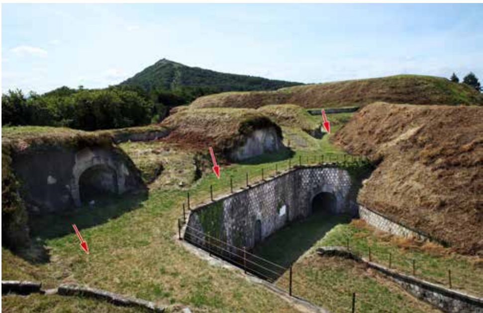
Adarve de servicio de la Obra de la Derecha.
