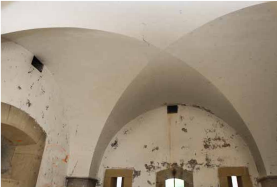
Una de las casamatas de la caponera sureste, para un cañón Nordenfelt de 5,7 cm, matacán, diversas aspilleras y lanzaproyectiles, cubierta con bóveda de arista.
