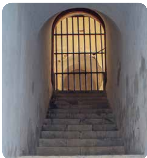
La escalera que comunica el cuartel de infantería con la batería acasamatada tiene tres tramos, incluyendo un recodo.
