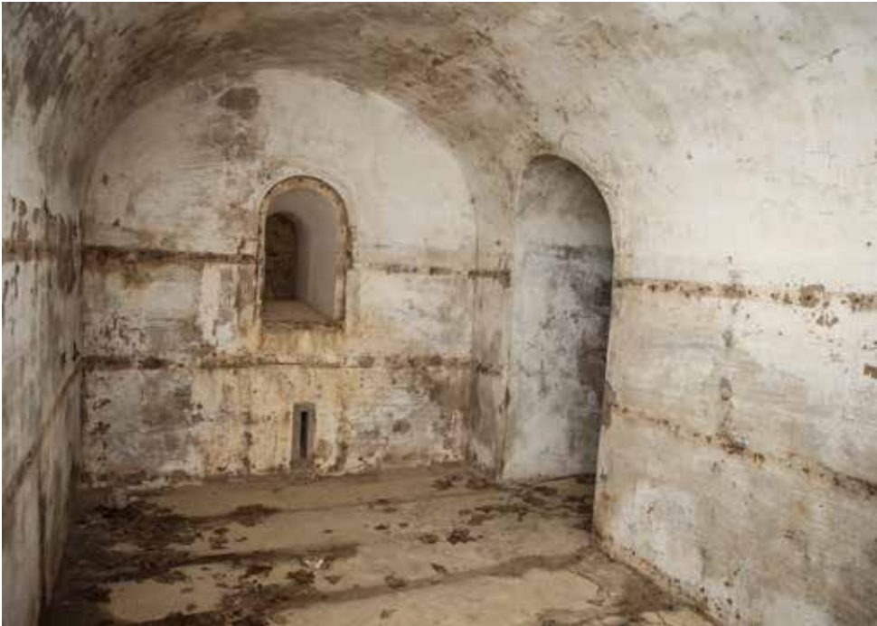
Depósito de distribución de la Obra del Centro. Interior de uno de los depósitos (5). Al frente se aprecia la ventana de iluminación (11) y a la derecha el acceso desde la bóveda de comunicación. En suelo y paredes se perciben vestigios del entarimado formando cámara de aire..
