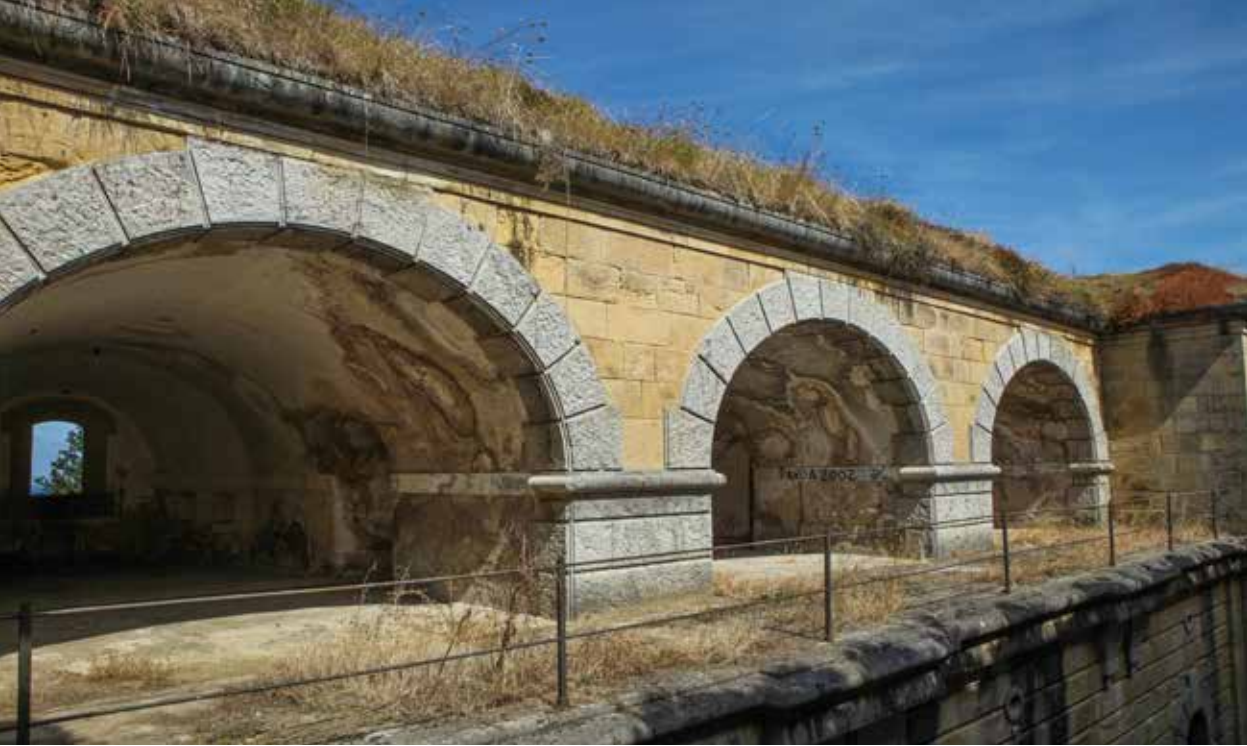
Batería de fuegos curvos de la Obra de la izquierda. Al fondo de la primera casamata se aprecia la cañonera para una pieza de artillería costera, disponiéndose los morteros en el extremo opuesto de la casamata, en primer término de la fotografía.
