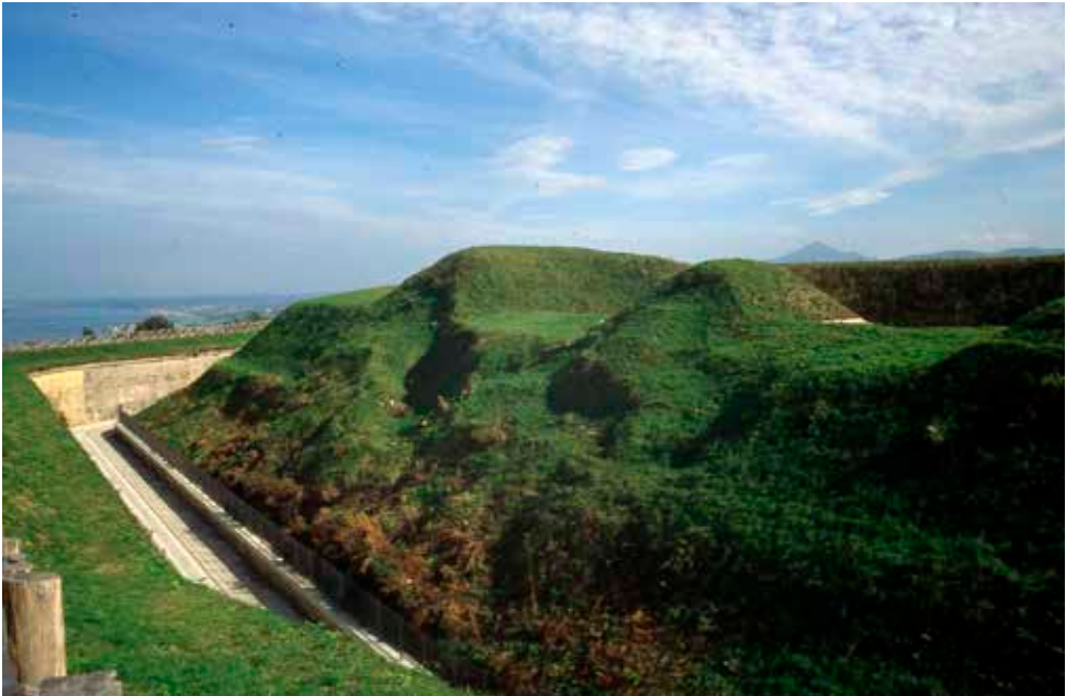
Escarpa entre la caponera de gola y el ángulo NE del fuerte. Se aprecia el talud (1), con su berma (2) y la verja (4) sobre un zócalo (3). La verja original fue eliminada, siendo sustituida por el Ayuntamiento por otra de características diferentes.
