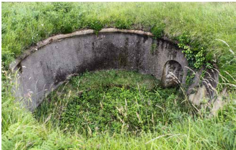
Entre las medidas de adaptación a las nuevas granadas se incorporaron en el Fuerte tres asentamientos para cúpulas acorazadas giratorias artilladas o para piezas de giro central, que nunca fueron instaladas.
