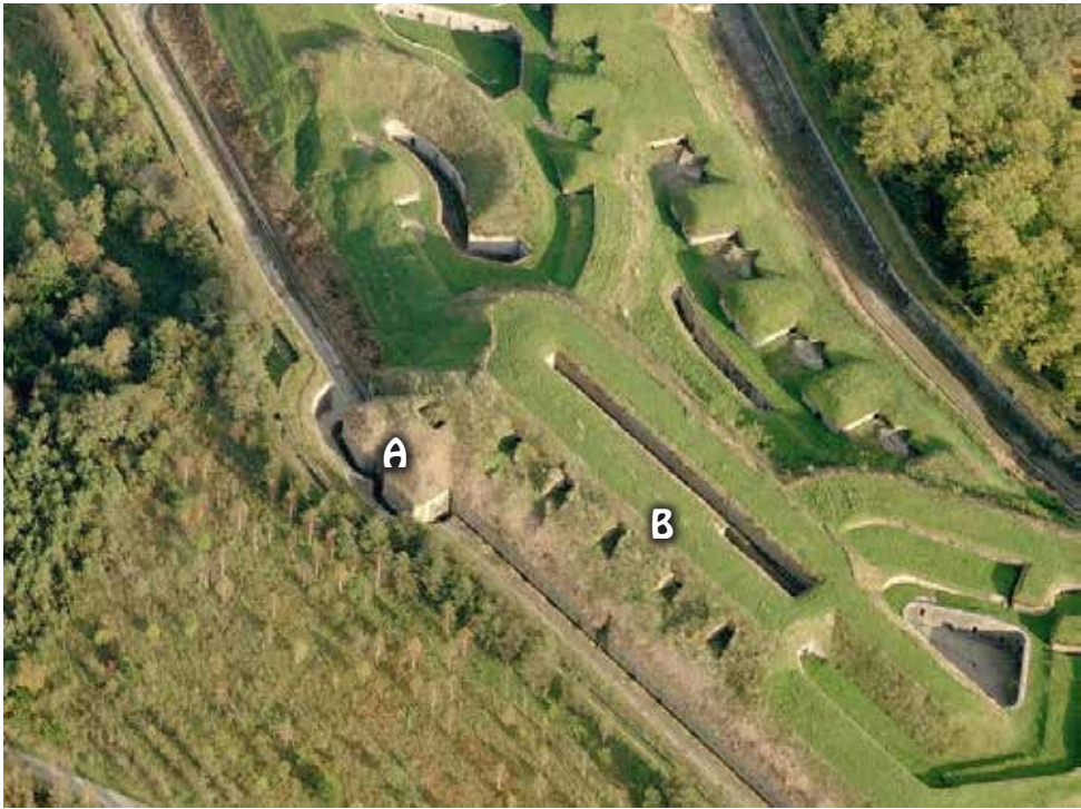
La gola se corresponde con el sector de la izquierda de la fotografía. En ella se aprecia tanto la caponera “de gola” (A) como las cinco cañoneras septentrionales de la batería acasamatada (B). (Fotografía aérea: Diputación Foral de Gipuzkoa).
