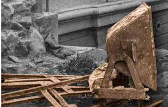
Vagoneta y vía portátil Decauville desmontada, utilizada para realizar movimientos de tierra en la construcción del Fuerte.
