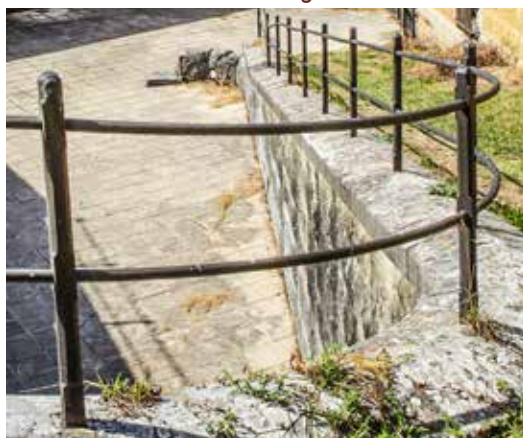
Barandilla (1) de la rampa de acceso al adarve de servicio de la Obra de la Izquierda, rodeando el patio principal. Se conserva aproximadamente la mitad de su longitud, reponiéndose el resto.
