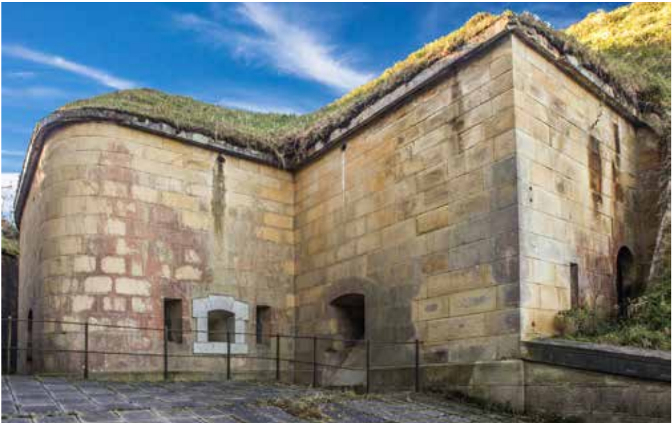
Flanco oriental de la caponera SW. (4) Se aprecia la cañonera y dos aspilleras de flanqueo y a su izquierda un matacán para defensa del fosete.
