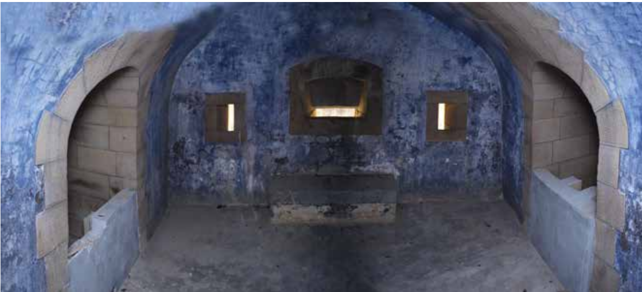
Caponera sureste. Espacio interior donde finaliza la poterna (5) que da acceso a las dos casamatas (1). Se aprecia un matacán con su banqueta y dos aspilleras que corresponden a las que se aprecian en la fotografía superior izquierda.
