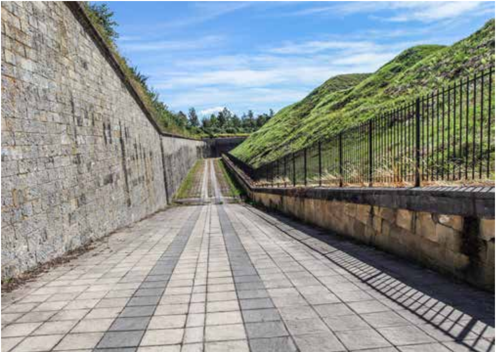
Uno de los dos sectores de foso correspondientes a la gola de la fortificación. A la izquierda la contraescarpa y a la derecha la escarpa en talud, limitado con un zócalo con una verja.
