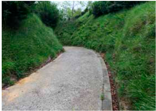
En pendiente, trinchera acentuada y curva abierta a la izquierda.
