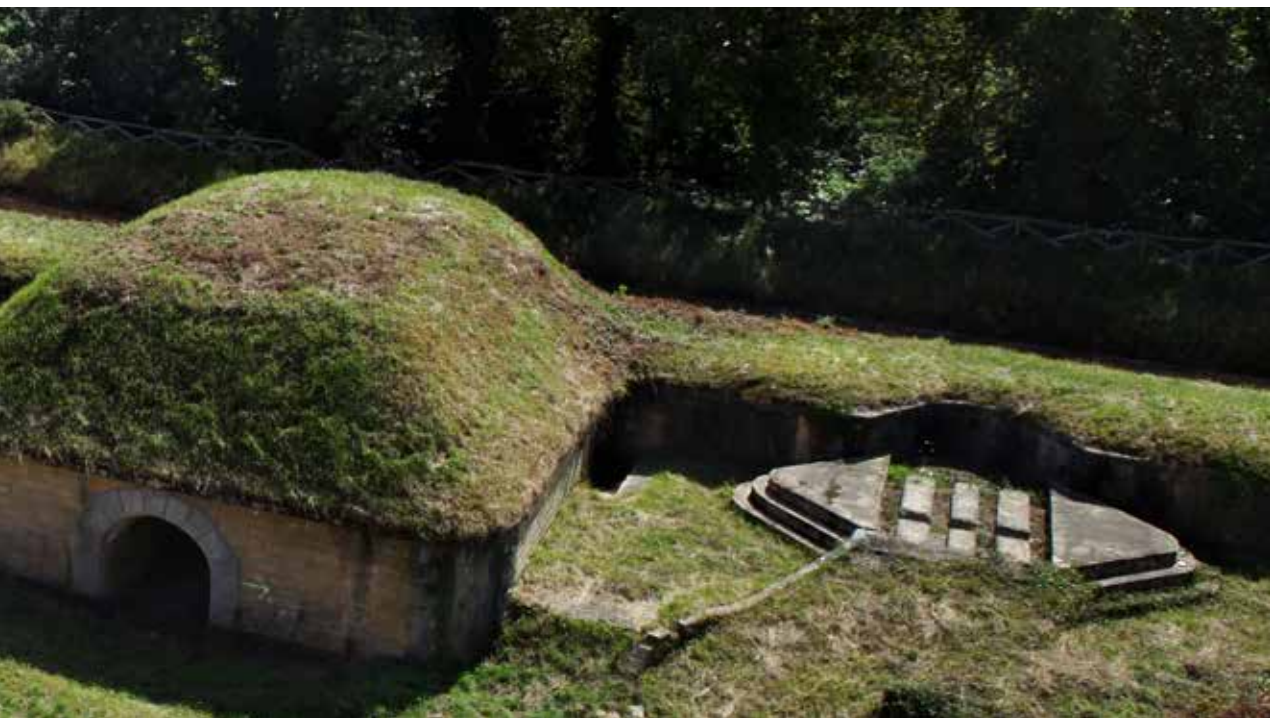
Vista general de la Obra, con sus tres traveses y las explanadas con sus rampas.
