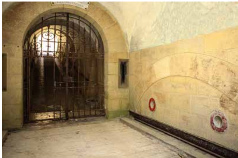
Interior del vestíbulo de la puerta principal. Se observa a la derecha de la fotografía el arco de descarga del muro, las dos bocas de los lanzaproyectiles y la poterna de acceso al patio principal con una aspillera frontal a cada lado.
