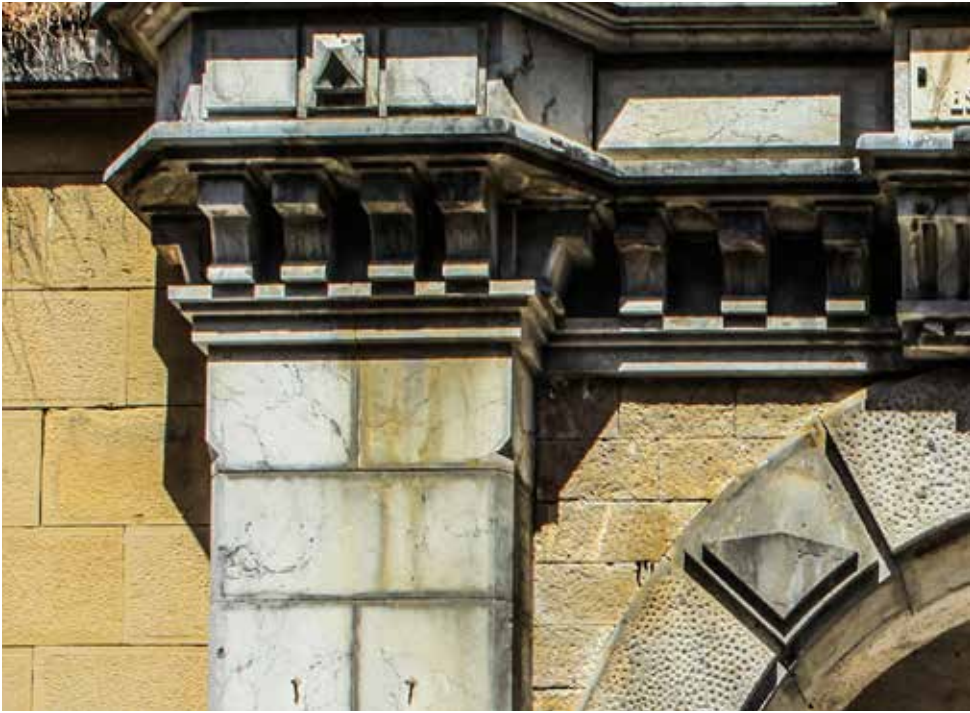
Detalle de sillería caliza (grisácea) y arenisca (amarillenta) en la puerta principal del Fuerte.
