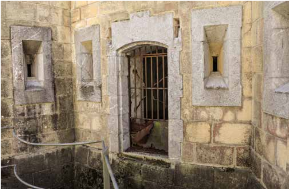
Puerta de guerra de la caponera de gola (1). Se aprecia la reja que impide el acceso, las aspilleras de defensa, el fosete y los orificios y poleas por los que pasaba la cadena del puente levadizo.
