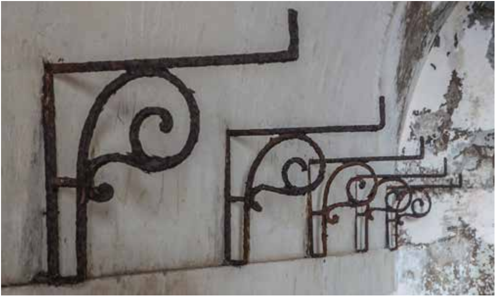
Palomillas para las tablas de equipo en una de las casamatas de la Obra de la Izquierda, ya que tenía la condición de cuartel auxiliar de tropa.
