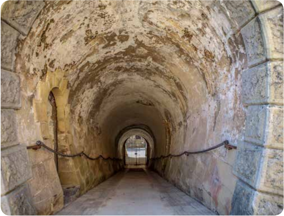
Obra de la Izquierda. Poterna entre el foso (al fondo de la fotografía) y el patio de armas (1).
