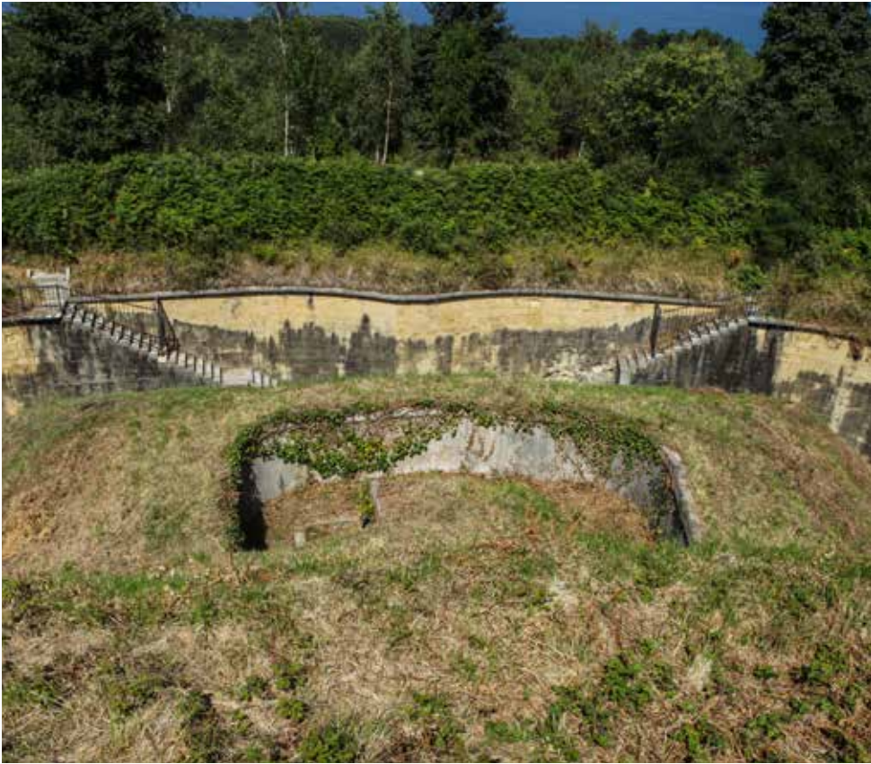
Observatorio sobre la caponera de gola. Domina las escaleras de contraescarpa y el camino cubierto. También tiene vistas sobre el mar.
