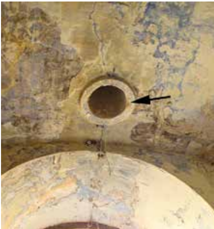
Cuartel de artillería. Izda.: boca interior del conducto sobre las ventanas y puertas. Describe trayectoria ascendente y sale bajo el cordón, según se aprecia en la sección (dcha.).
