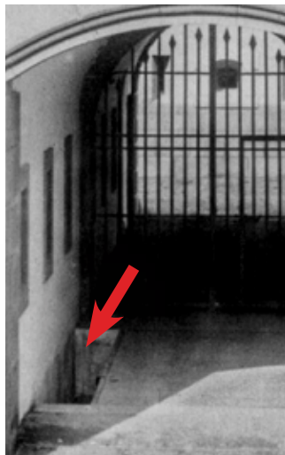
Foso de la antepuerta, con su puente original entreabierto. A la izquierda se aprecian varias aspilleras.
