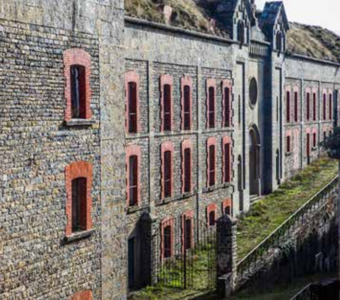
1 Fuerte de San Cristóbal o Alfonso XII (Navarra). Es el mayor fuerte poligonal de mayores dimensiones del Pirineo. Se aprecia en la fot. la entrada de la capilla.
