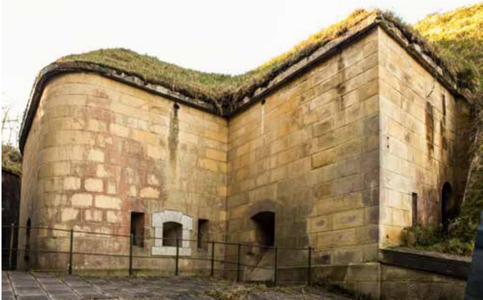
Frente oriental de la caponera SW (1). Se observa la cañonera y las dos aspilleras del frente, así como un matacán para defensa del fosete. A la derecha, la puerta de acceso al camino de ronda de la escarpa.
