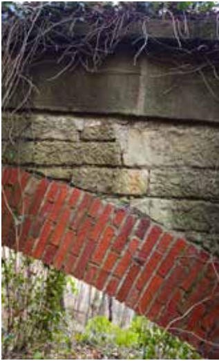
Detalle del acueducto.
