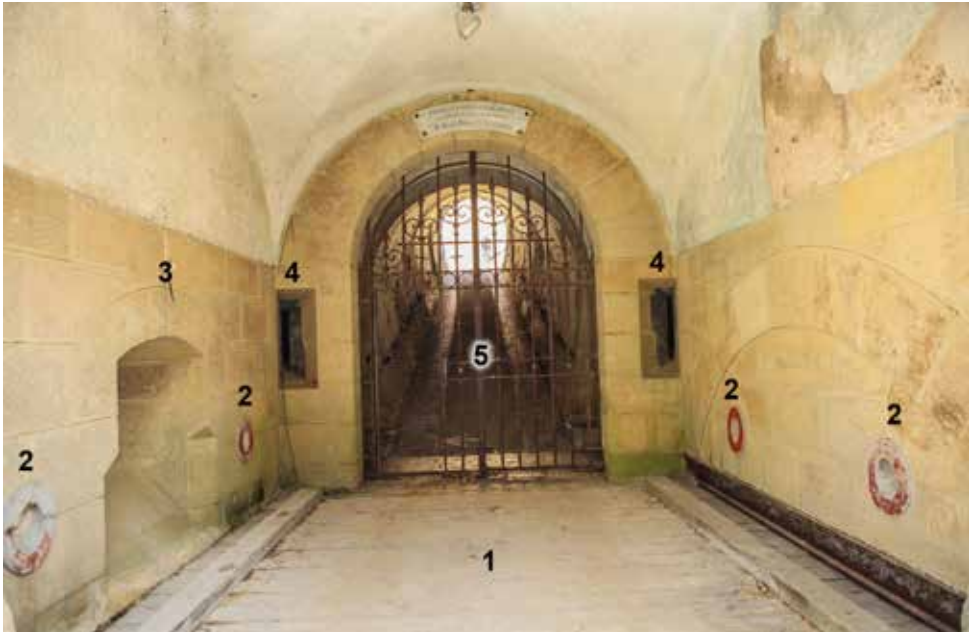
1 Foso con puente corredizo. 2 Cuatro lanzaproyectiles hacia el foso. 3 Matacán. 4 Dos aspilleras verticales. 5 Reja de cierre con portillo. Al fondo, se aprecia la poterna en rampa de acceso al patio de armas.
