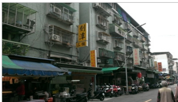
圖五：劍潭整宅一期 A 棟外觀
