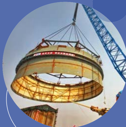
钢制安全壳制造、吊装、现场热处理、压力和泄漏率测试
