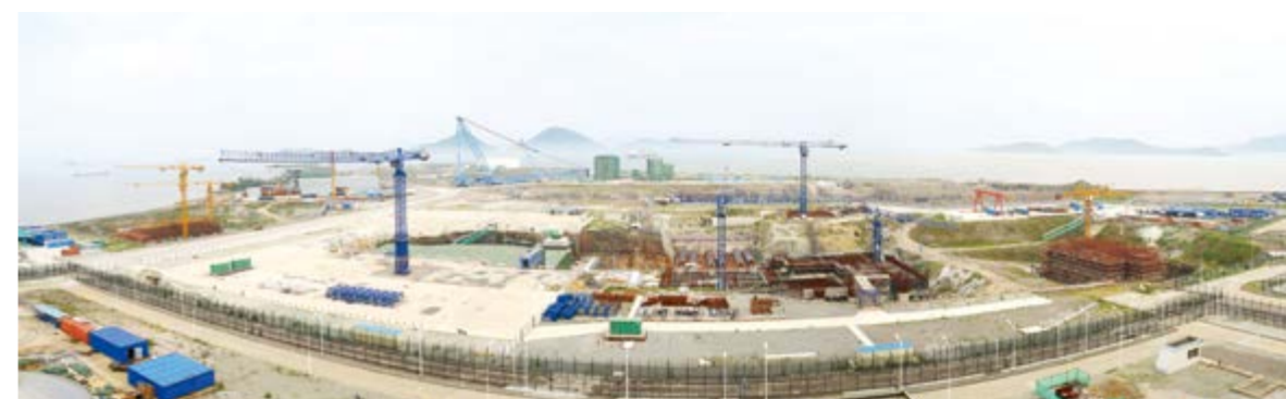
三门核电二期工程现场
