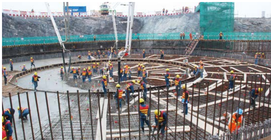
核岛筏基大体积混凝土一次性浇注现场
