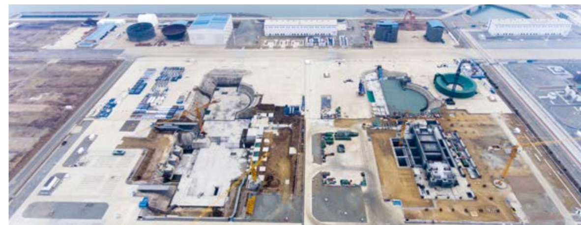
海阳核电二期工程现场
