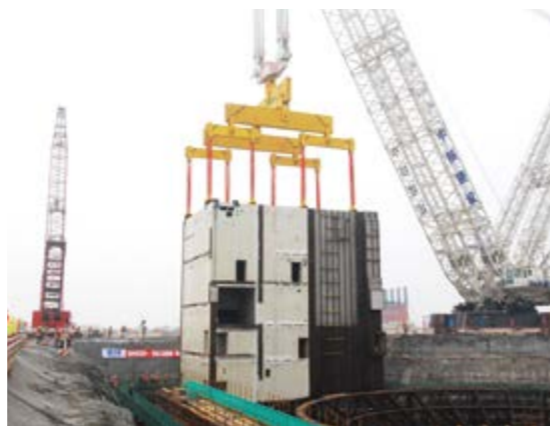
海阳核电模块化吊装
