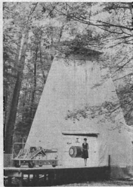
Fig. 2. Här undergår ESRO I-modellen magnetiska stabiliseringsprov. Dessa måste utföras i fält på stort avstånd från industriområden, kraftledningar m. m., för att inte störningar skall förrycka mätresultaten.
