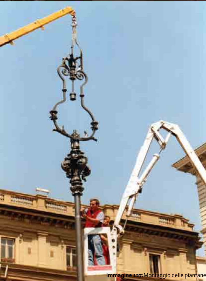
Immagine 126: Montaggio delle piantane
