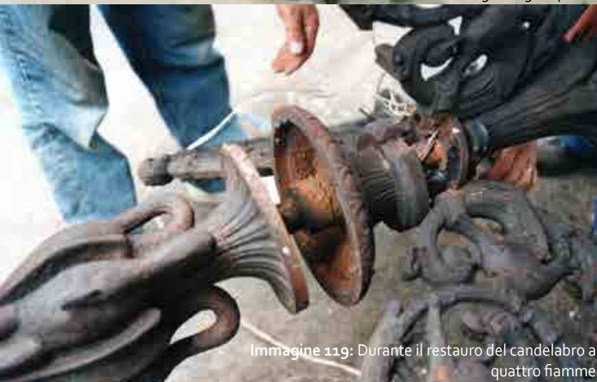
Immagine 118: Candelabro a quattro fiamme smontato in ogni singolo pezzo
