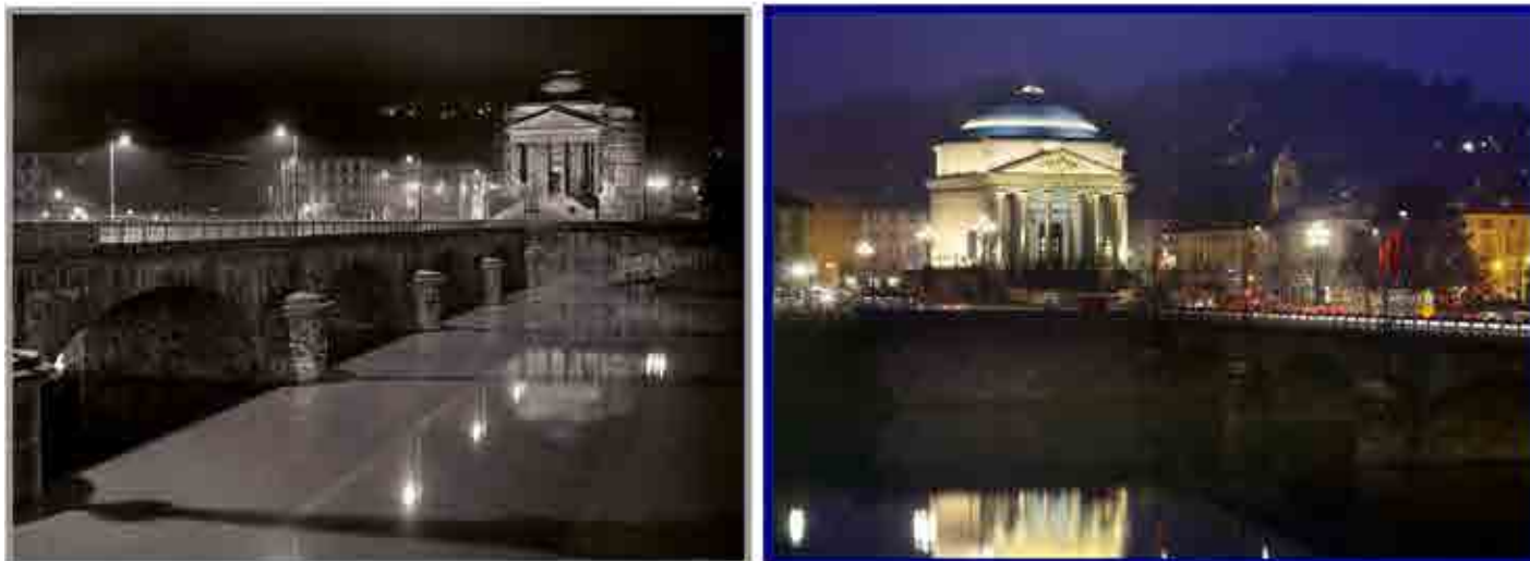
Fig. 5 Illuminazione del Ponte Vittorio Emanuele I e della Gran Madre negli anni '60 e com'è invece oggi
