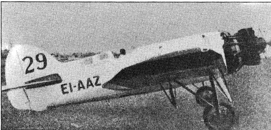
**Bellanca 28-29** de serie, **sin el carenado del motor**.
