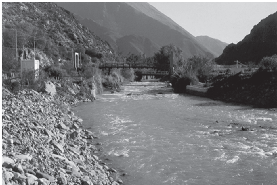
Fig. 3.16a. Vista general de estación fluviométrica Río Elqui en Algarrobal.
