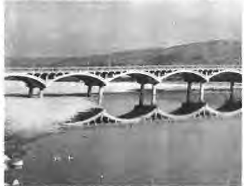
图 11-20 西乡牧马河大桥
