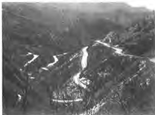
图 11-6 108 国道佛坪土地岭段
