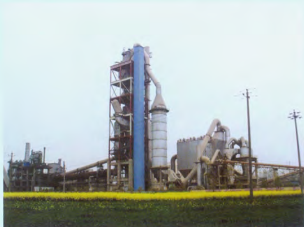
汉中水泥厂（汉中建材股份有限公司）
