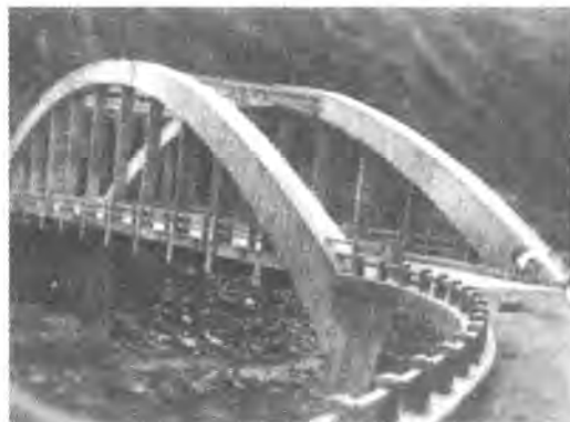
图 11-17 解放后重建鸡头关大桥
