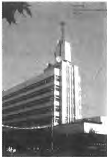
图 12-1 汉中地区邮电综合楼
