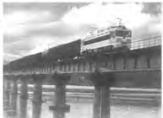
图 11-21 洋县汉江铁路大桥(三号桥)
