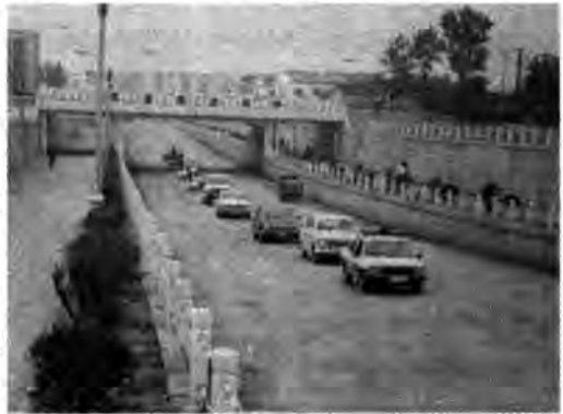
图 15-13 汉中市汉武路立交桥
