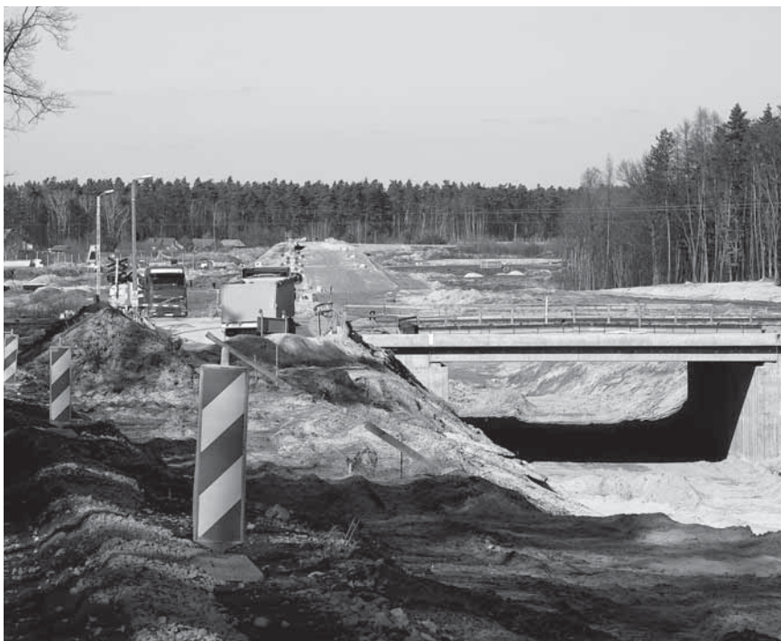
Prace w okolicy ulicy Leśnej nabierają coraz większego tempa - fot. arch. MOK
