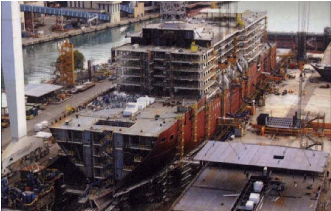
Фото 11. Судно у побудові: формування корпусу (формирование корпуса) пасажирського судна « QUEEN ELIZABETH » на будівельному місці (построечном месте).
