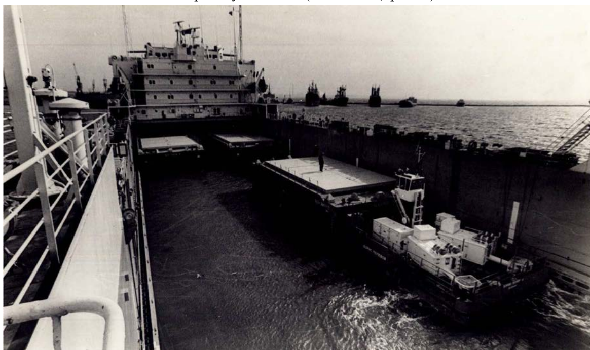
Фото 8. Завантаження барж [ліхтерів типу ЛЕШ (LASH – Lighter Aboard Ship) ] в трюм - докову камеру баржевозу (ліхтеровозу) «БОРИС ПОЛЕВОЙ» з допомогою штатного судового буксиру.
