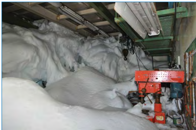
Станция Русская. Машинный зал в здании дизельной электростанции, полностью заполненный льдом через выдавленные ветром окна (2008 г.) (слева). Вырванная ветром часть крыши над медблоком в служебно-жилом здании станции (фото 2010 г.) (справа).
