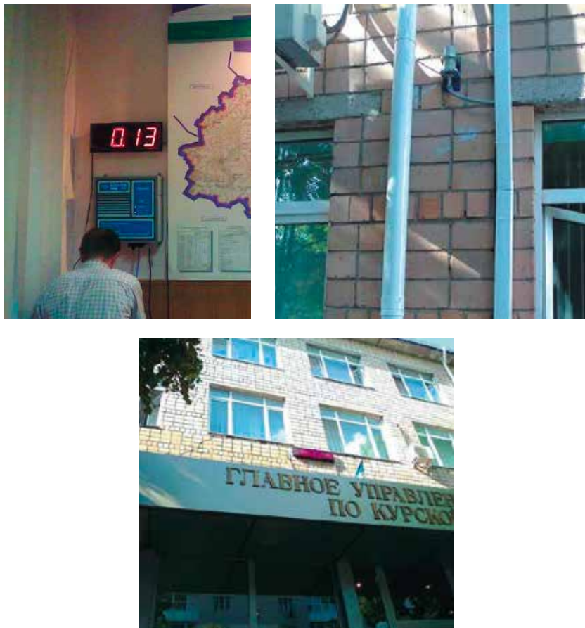
Рис. 9. Размещение оборудования поста контроля КТ АСКРО в ГУ МЧС России по Курской области
