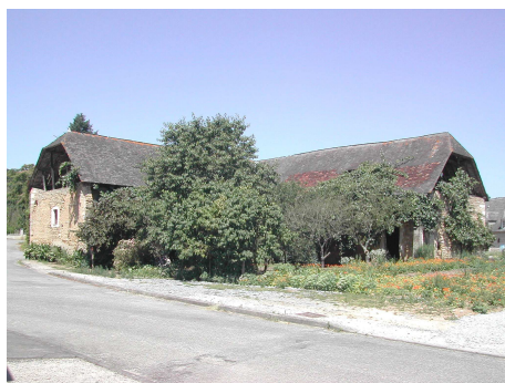
La Maison des Vins et du Terroir du Jurançon avant travaux (photo : été 2004)
