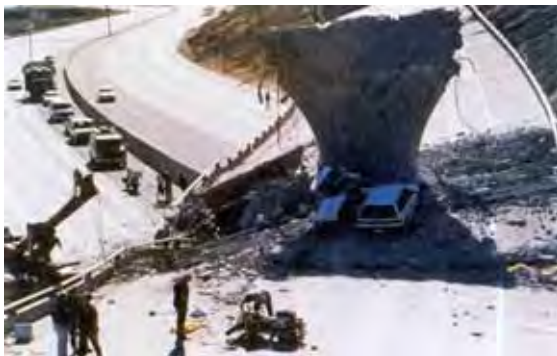
شكل D.1d دمار وخراب الجسور والطرق السريعة بسبب الزلازل 1997, Tarbuck & Lutgens
