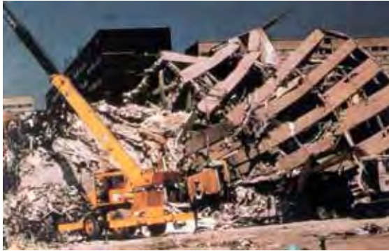
شكل D.1b دمار مواقف السيارات والمباني الضخمة بسبب الزلازل 1993, Montgomery
