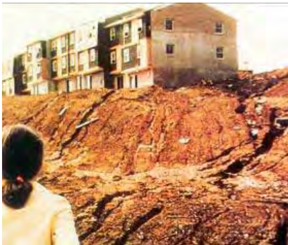
شكل E.37 تحات علي جانب حاجز واق للمباني Montgomery, 1993
