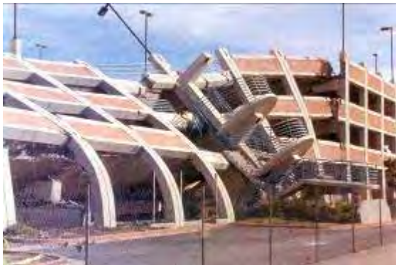
شكل E.17c تأثير الزلزال في مبنى مواقف السيارات Tarbuck & Lutgens, 1997
