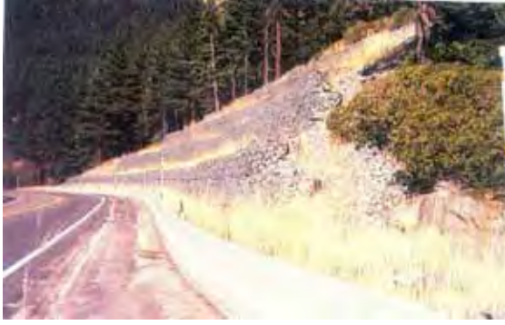
شكل S.151 طريقة تثبيت المنحدر ببناء مصاطب صخرية وتغطيتها بشبك فولاذي (Montgomery, 1993)
