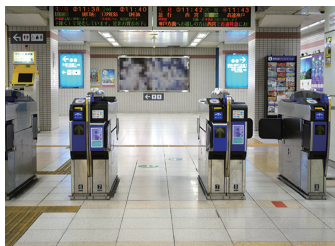
車いす対応改札機
