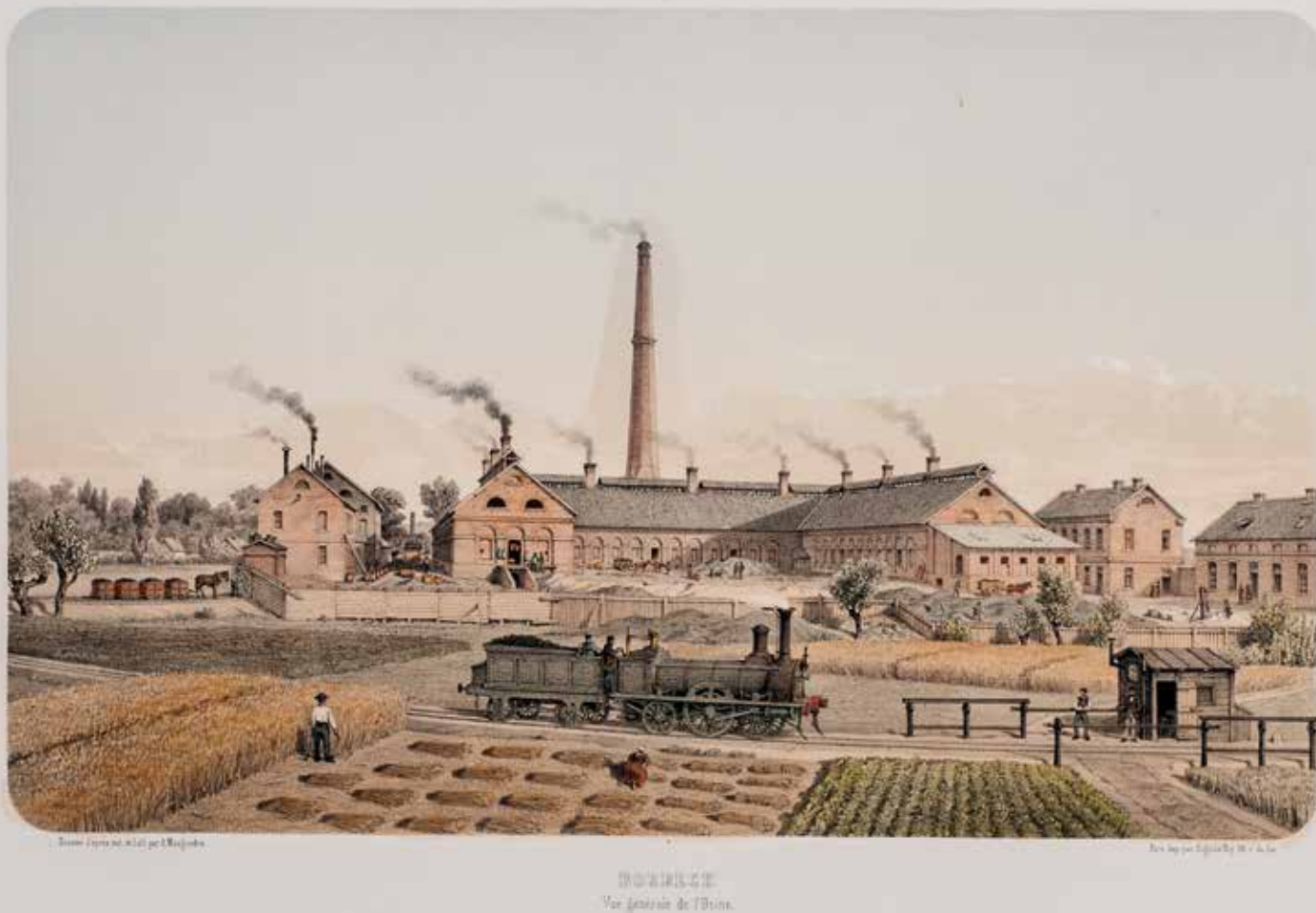
Abb. 8: Druck „Borbeck“ von Adolphe Francois Maugendre, um 1855. Außenansicht der Zinkfabrik in Borbeck bei Essen. (© LVR-Industriemuseum)
