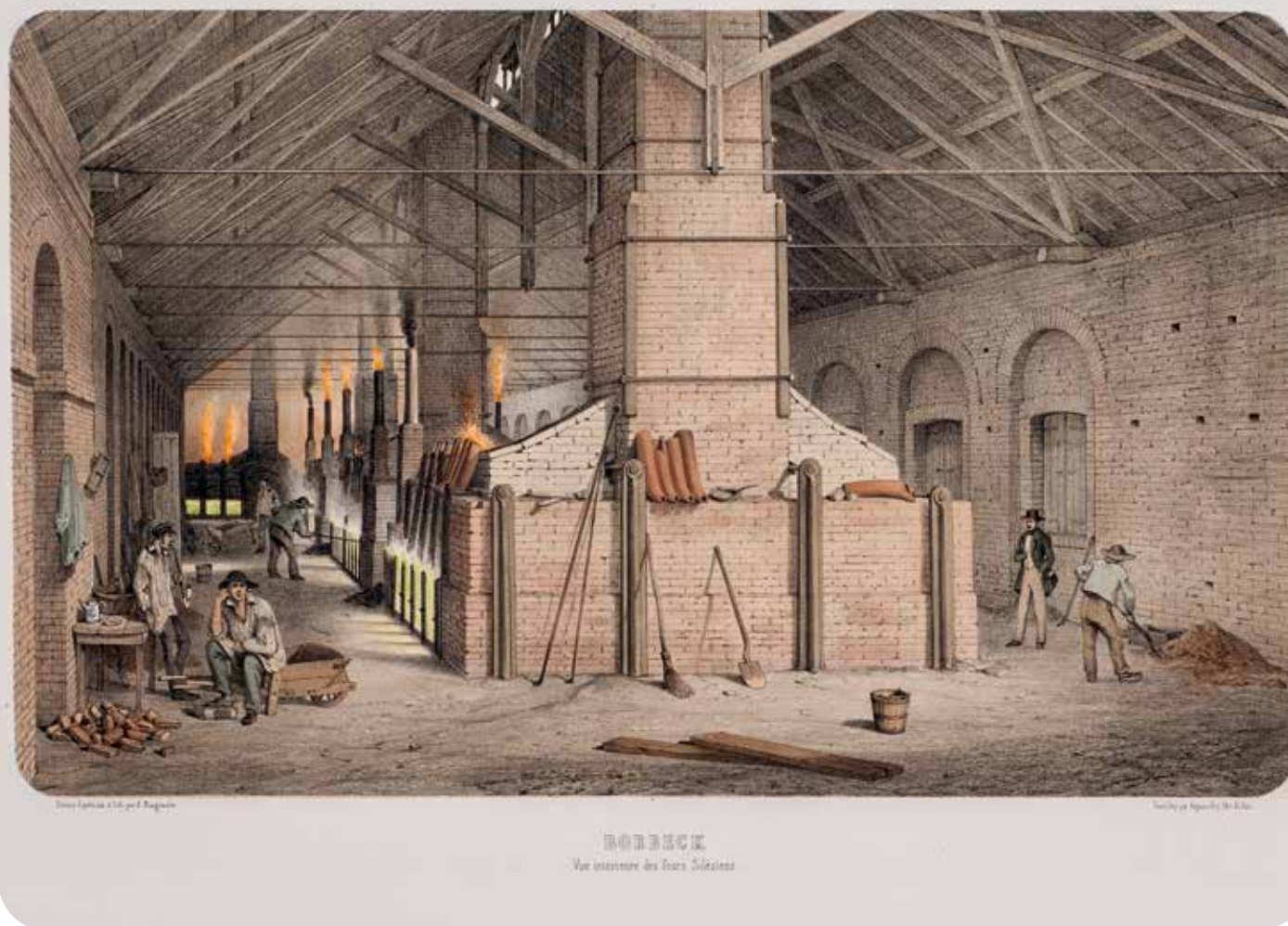
Abb. 9: Druck „Borbeck“ von Adolphe Francois Maugendre, um 1855. Innenansicht der Zinkrösterei in Borbeck mit den schlesischen Zinkreduktionsöfen. In Essen wurde das preisgünstigere schlesische Röstverfahren gegenüber dem belgischen Verfahren bevorzugt. (© LVR-Industriemuseum)
