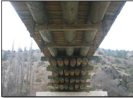
Şekil 26. Tarihi Bayramören Köp, Çankırı (Restorasyon Sonrası) (KGM, 2015, s.18)
