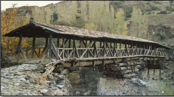
Şekil 24. Tarihi Bayramören Köprüsü, Çankırı (Restorasyon Öncesi) (KGM, 2015, s.18)
