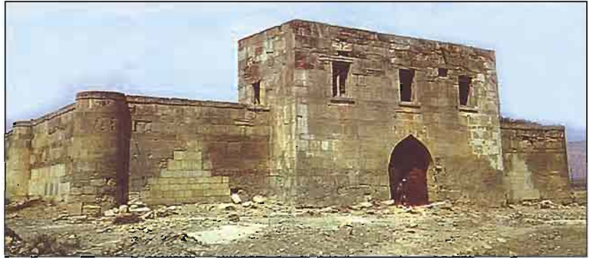
Sanqaçal kəndi. Karvansaray. 1439-cu il. Ümumi görünüş.
