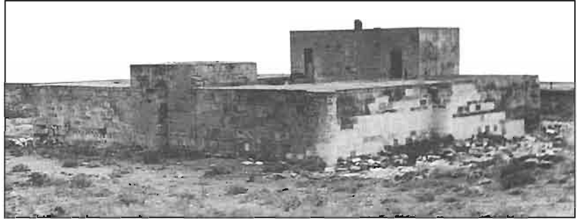
Sanqaçal kəndi. Karvansaray. 1439-cu il. Şimal-qərbdən ümumi görünüş.
