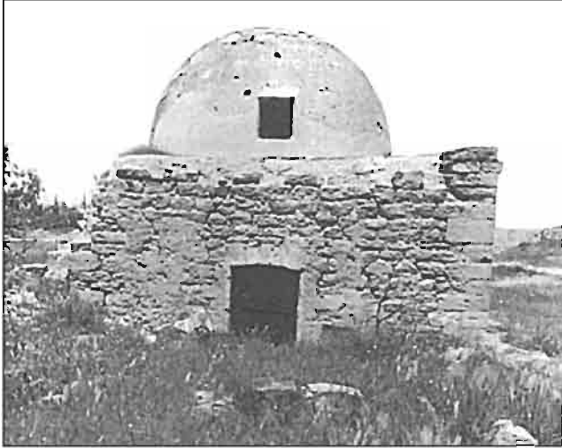
Goradil kəndi-bağlar. Plan, uzununa kəsim, fəsad. Ümumi görünüş. Ş.S.Fatullayevin ölçmə və çertyoju. 1984-cü il.
