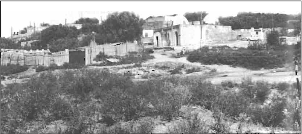
Novxanı kəndi. Hamam və tikilinin panoraması.
