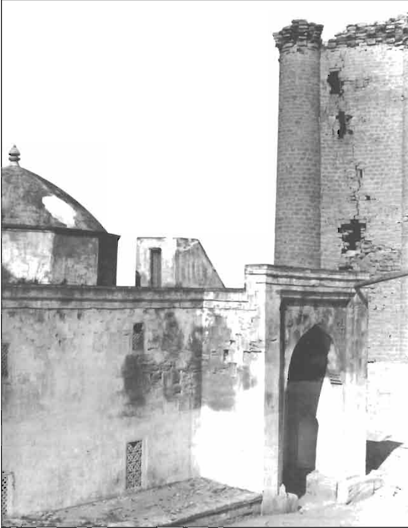
Mərdəkan kəndi. Tuba-Şahi məscidi. Ümumi görünüş.
