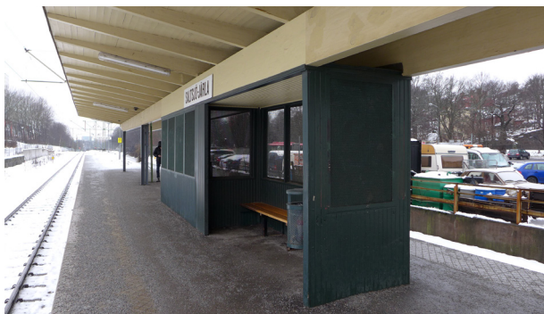
Perrongtaket har två inbyggda väntkurer.
