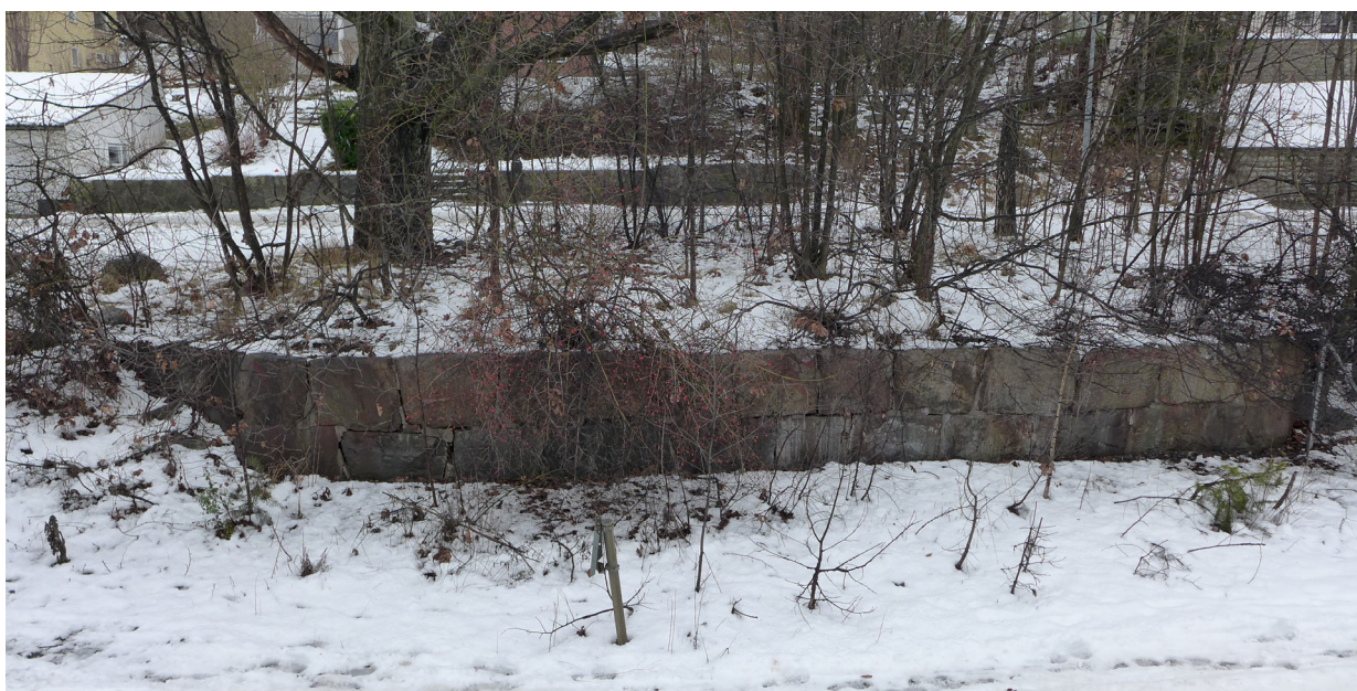
Stensättningen norr om spåret utgör en kulturhistoriskt intressant lämning av tidigare verksamhet vid stationen.
