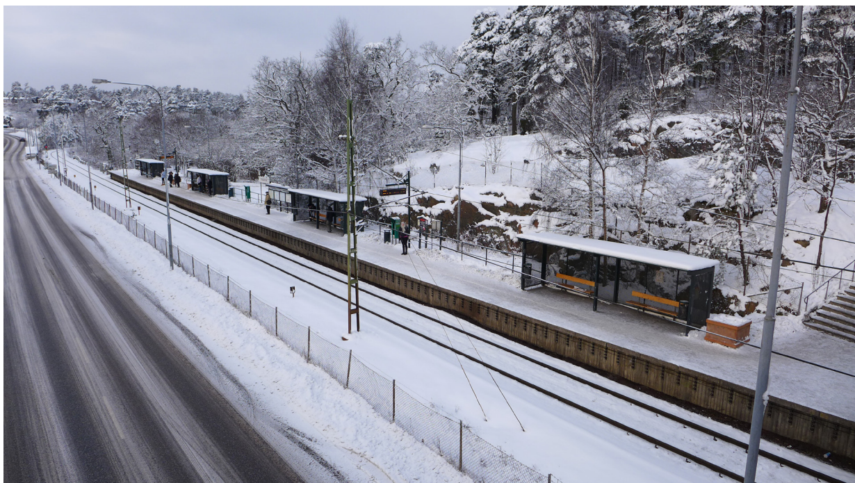
Vy över hållplatsen från gångbron över till Fisksätra centrum.
