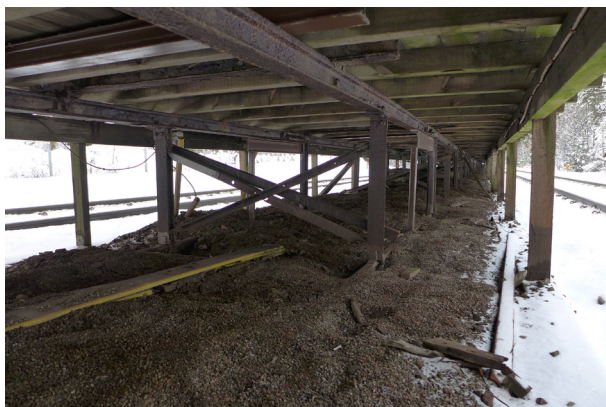
Det ursprungliga perrongunderredet är bevarat under den sentida träplattformen.
