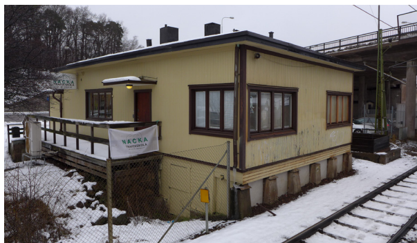
Stationshuset har förvanskats genom ombyggnader.
