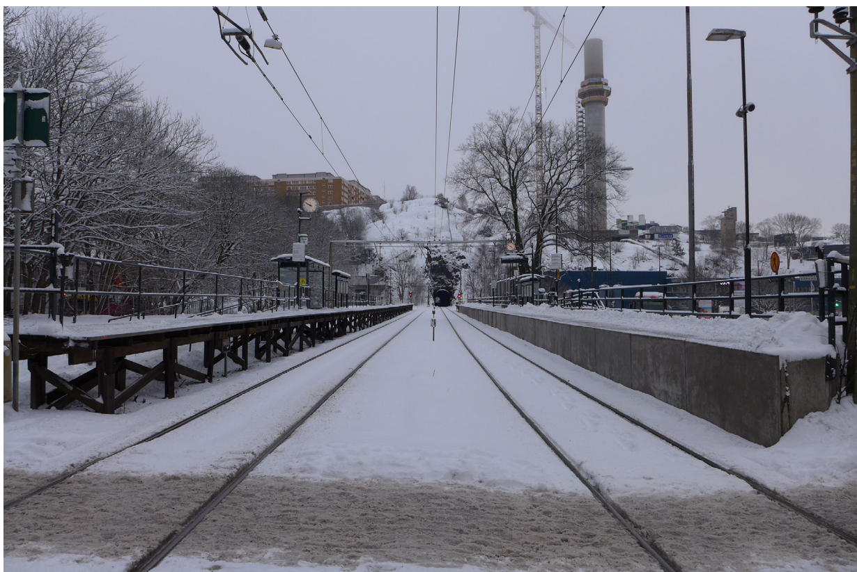
Henriksdalsberget med sina tunnlar och reningsverket vid dess fot upptar vyn mot öster.
