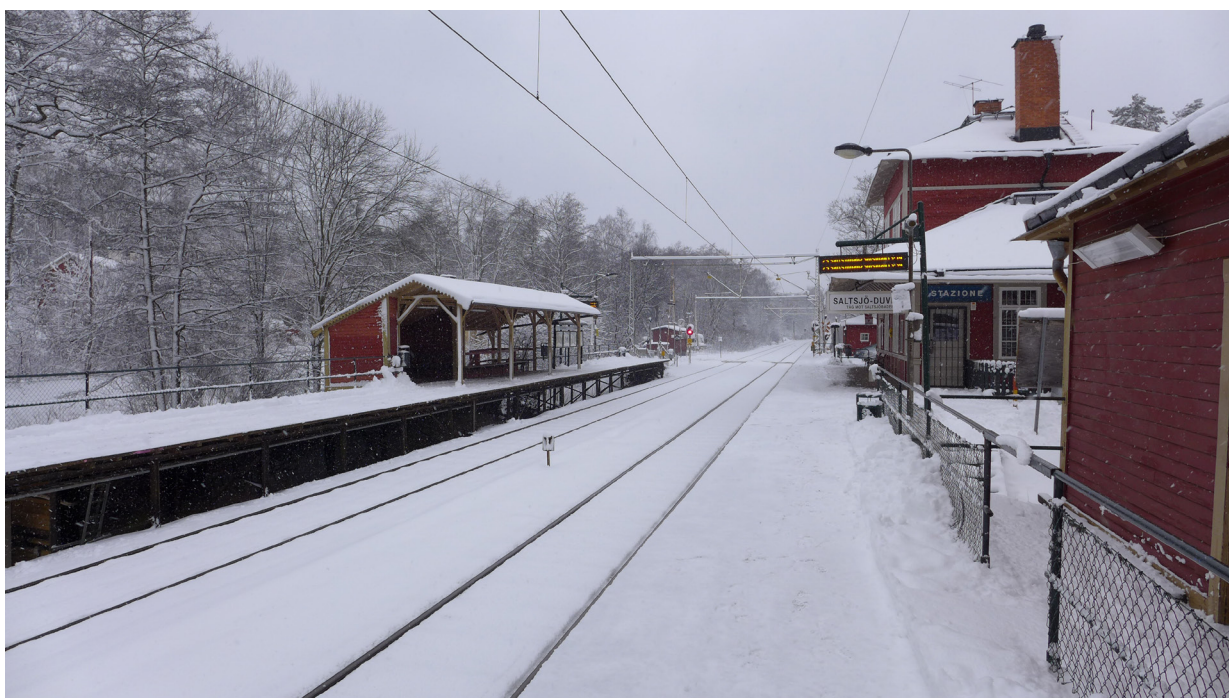
Saltsjö-Duvnäs är en väl bevarad helhetsmiljö med stationshus, väderskydd och godsmagasin.
