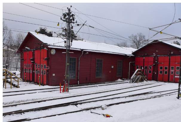
Verkstadsbyggnaderna är väl bevarade exteriört.
