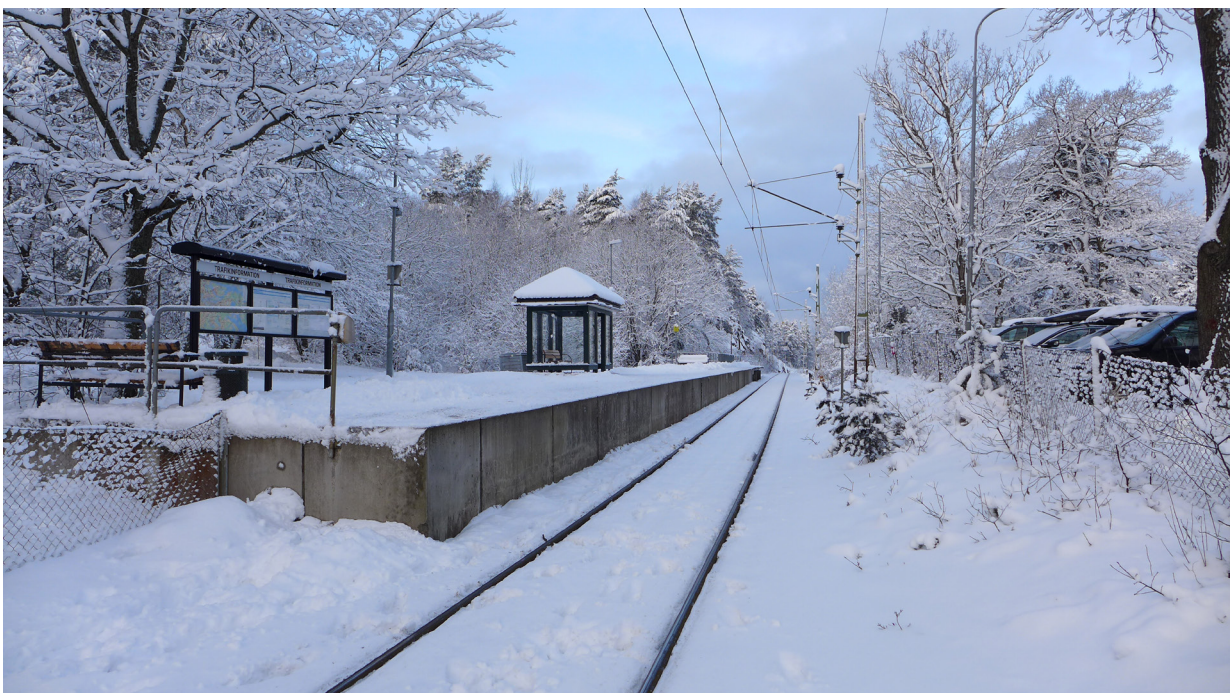
Stationen i Tattby består idag av en perrong i betong samt en sentida väntkur.
