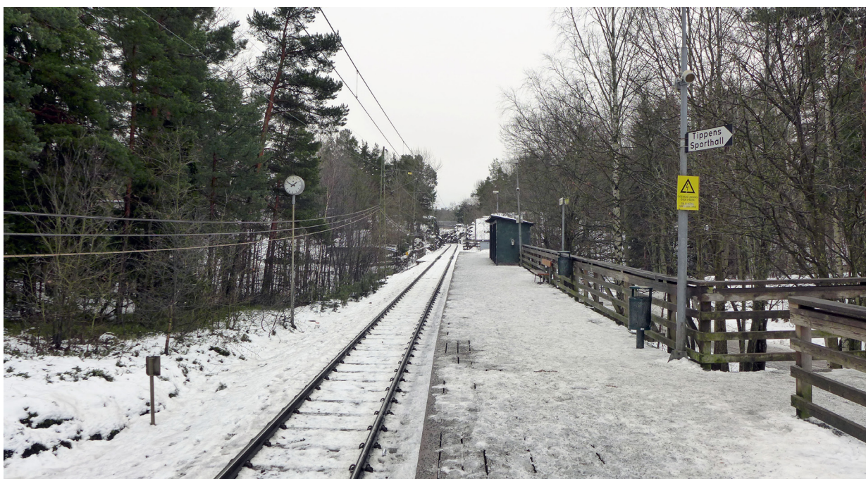
Tippens perrong ligger högt över marken på en träkonstruktion.
