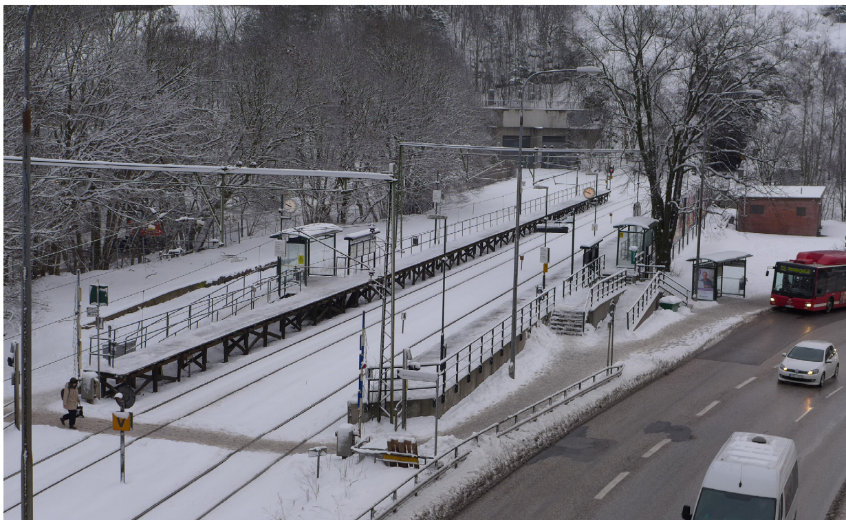
Henriksdals station ligger mellan en skogsdunge och den hårt trafikerade Värmdövägen.
