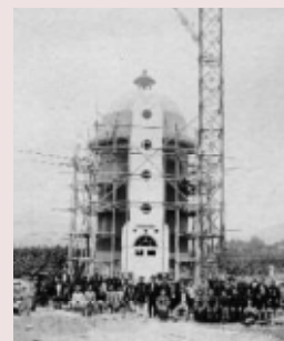
建設中の児玉町旧配水塔
