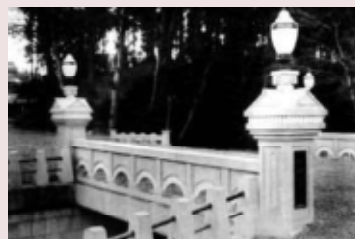
完成直後の賀美橋
