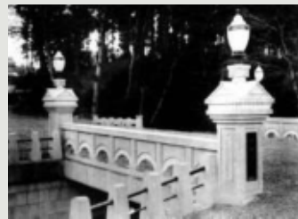
竣工当時の賀美橋
