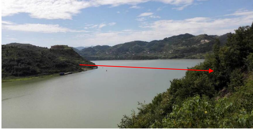
汉江特大桥跨汉江位置
