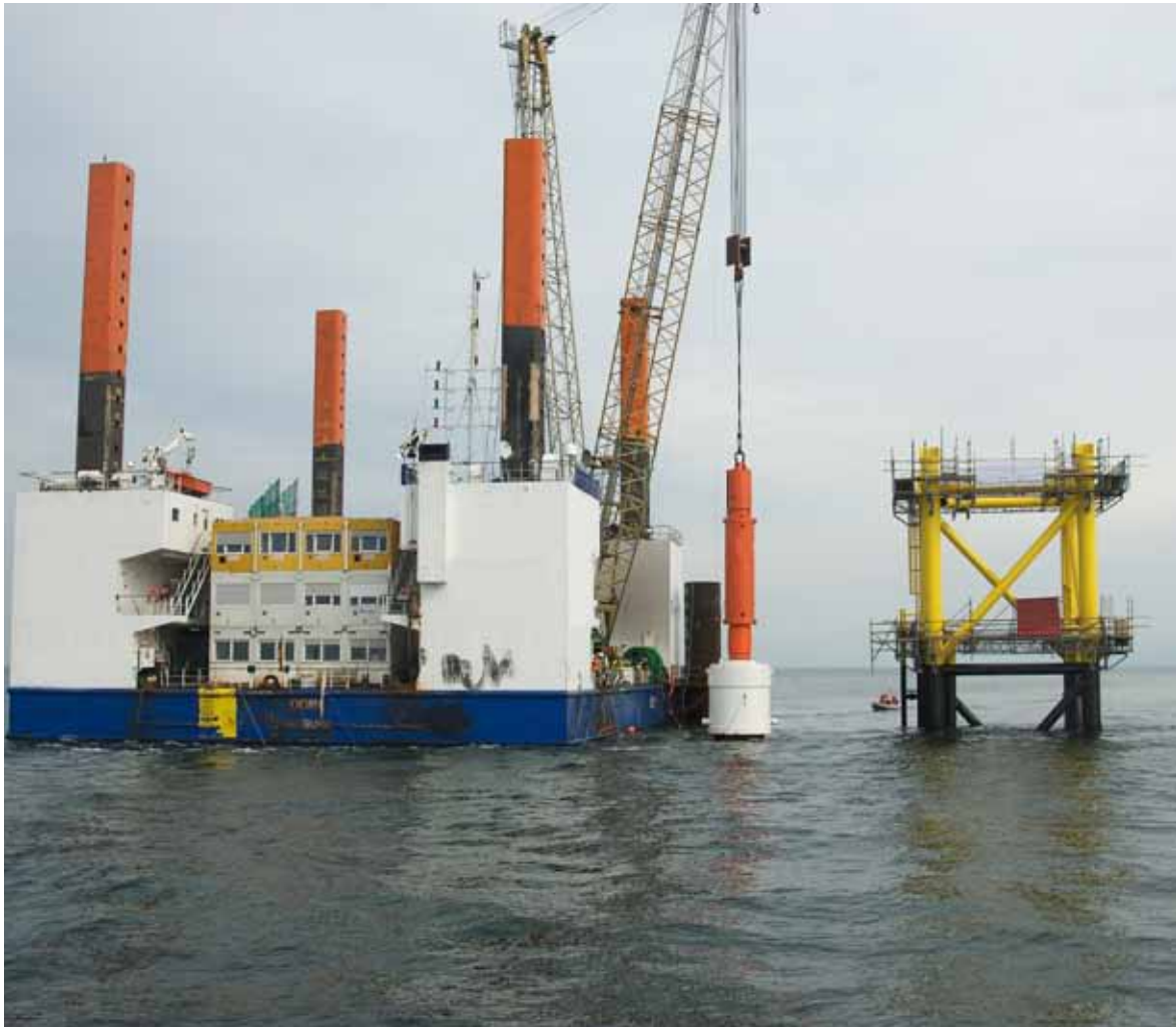
Photo: Stiftung Offshore Windenergie
