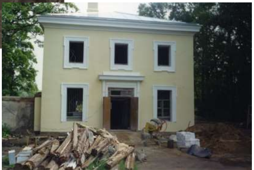
Ремонты: было и стало Северный флигель
