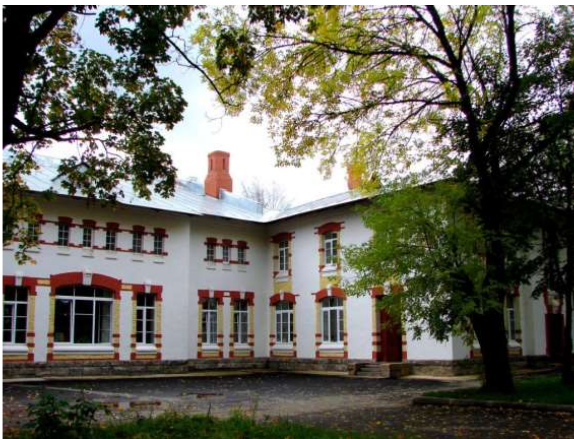
Ремонты: было и стало Здание бывшей прачечной – Центр реабилитации
