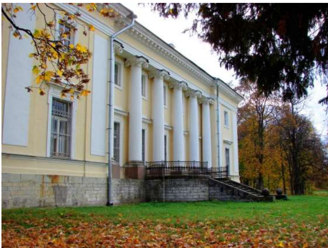
Ремонты: стало Административный корпус (главное усадебное здание)
