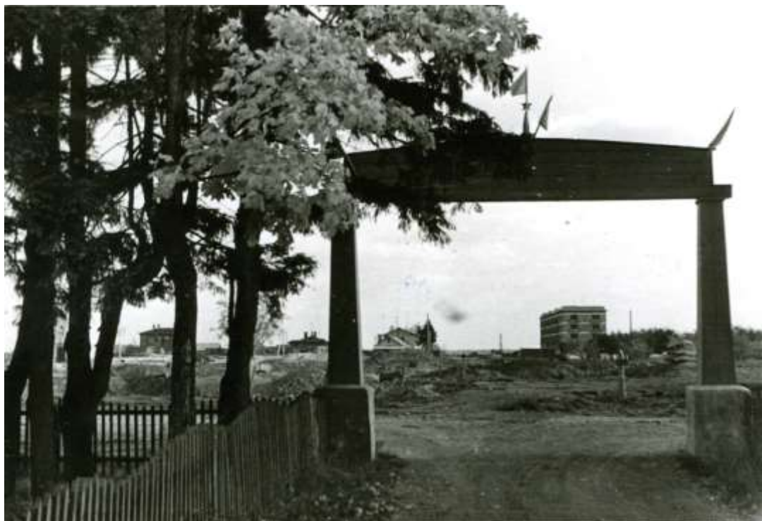
Строится жилой городок
