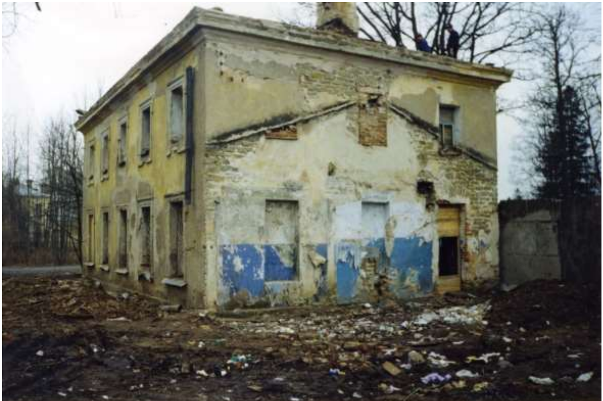
Ремонты: было Северный флигель
