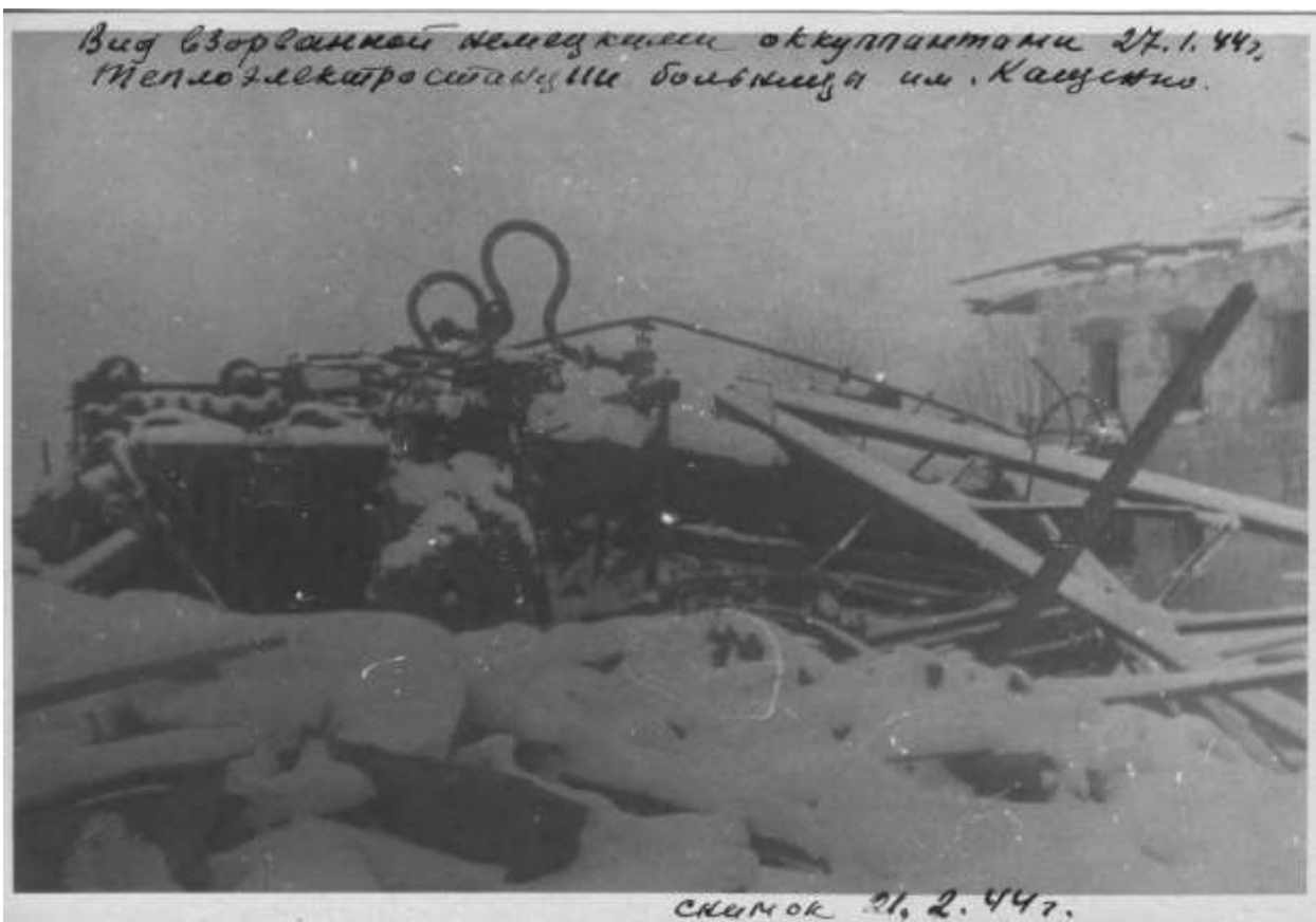
Разрушенная электростанция. 21.02.1944 г.
