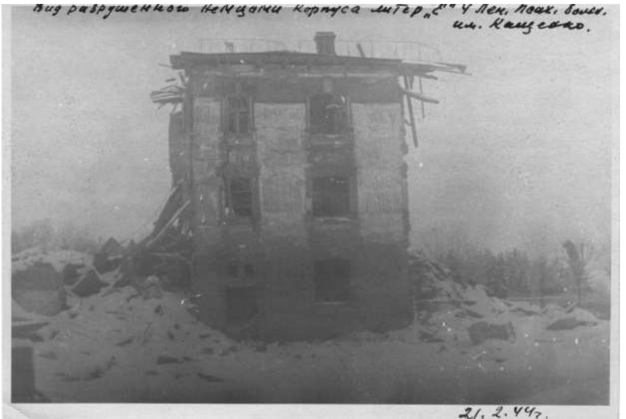
Разрушенный корпус Е. 21.02.1944 г.
