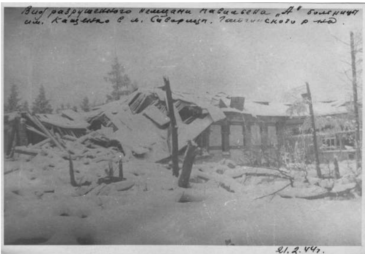
Разрушенный корпус А. 21.02.1944 г.
