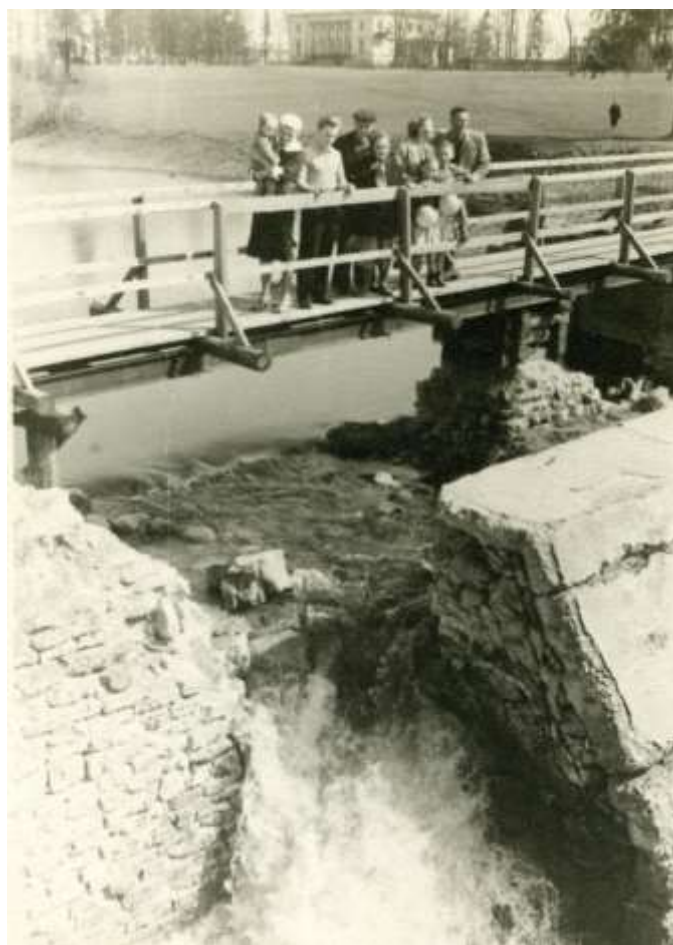
Временный мост через водопад. 1950-1960-е гг.
