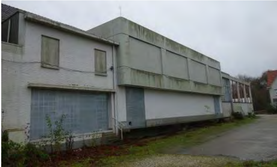
De noordelijke gevel voor gebouw F gezien richting het zuidwesten met links het overgebleven deel dat in 1947 is gebouwd.
