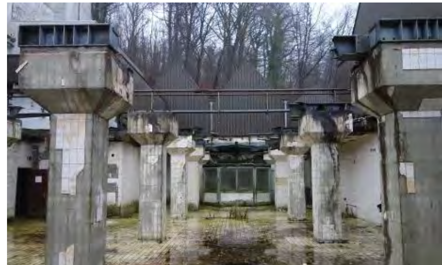
Ruimte 0.12 gezien richting het zuiden met de met damwandplaten dichtgemaakte zuidelijke hallen.
