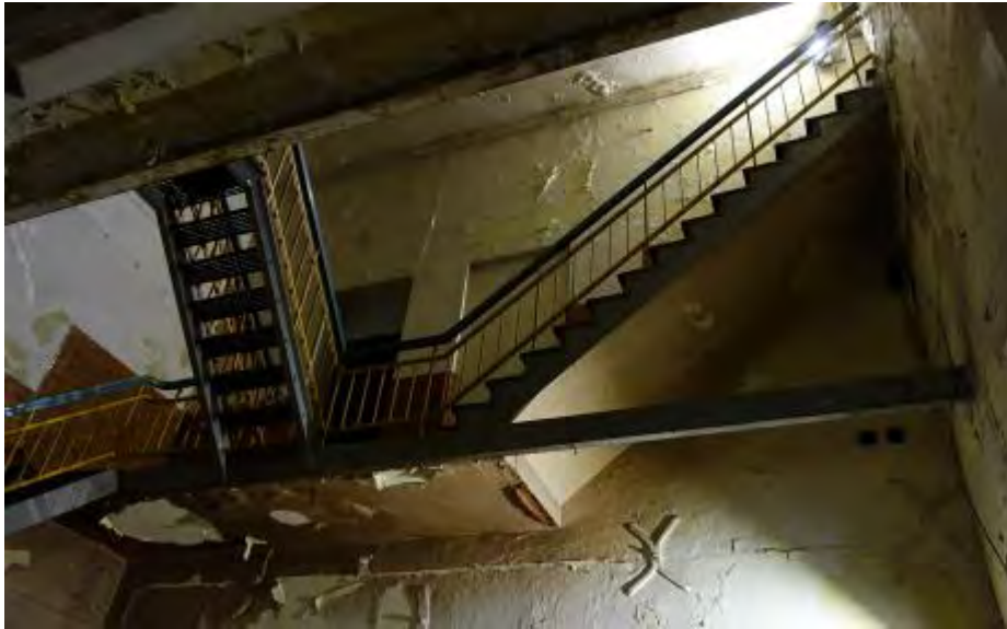
Overloop op de verdieping aan de noordzijde van de ruimte.
