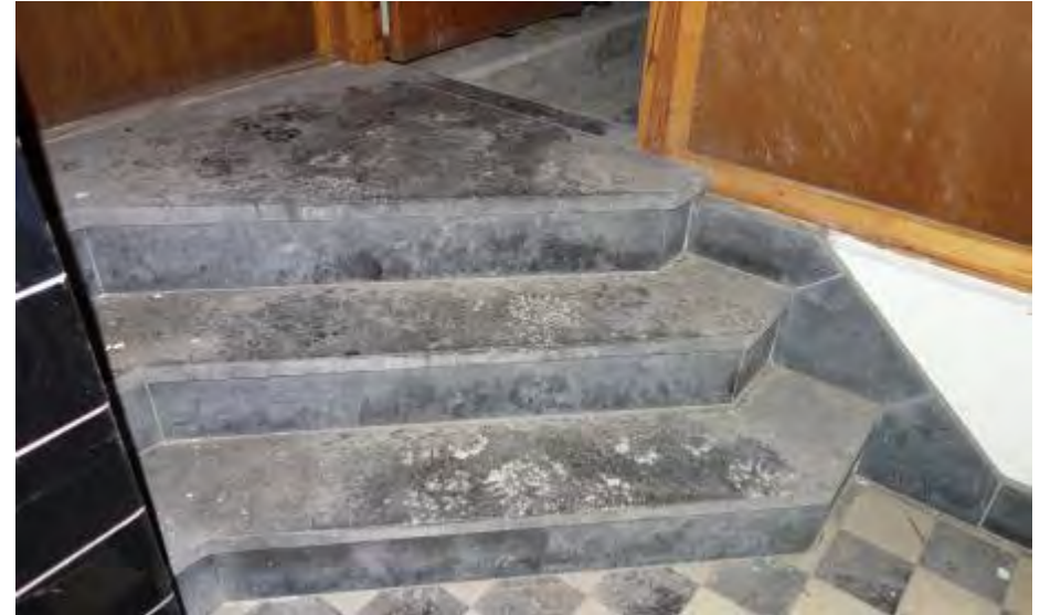
Detail hardstenen trapje bij overloop tussen noord en zuid ruimte.
