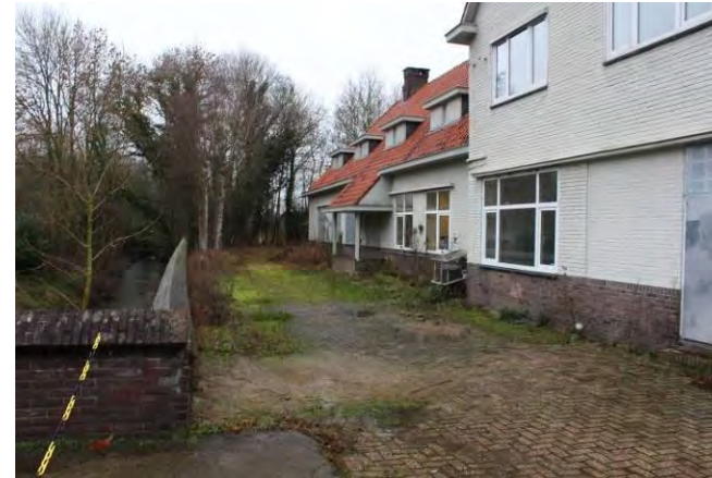
Zuidgevel ontvangstgebouw met achterliggende werkplaats.
