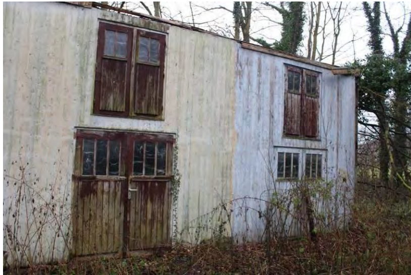
Opslagloods op het achterterrein van het ontvangstgebouw.
