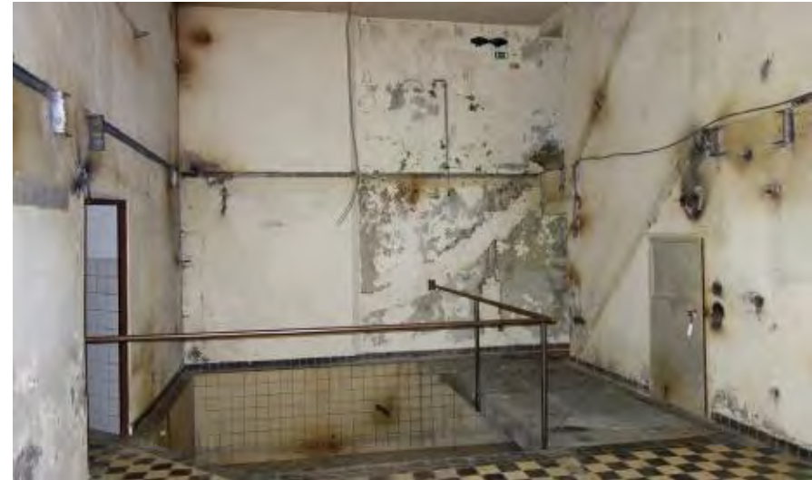
Ruimte 0.2 gezien richting het zuiden met links de toiletruimte in de basement van de schoorsteenpijp.
