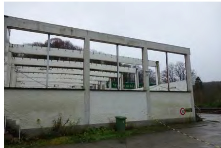
Noordgevel de hal uit 1964.
