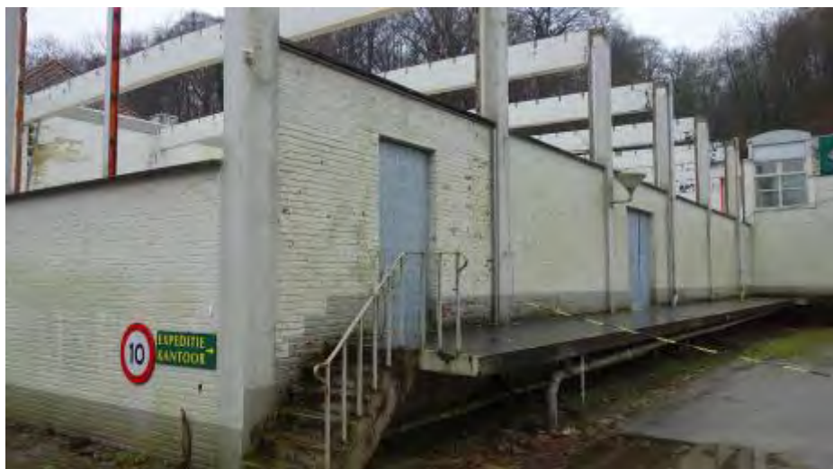
Westgevel van de fabriekshal uit 1964 gezien richting het zuiden.
