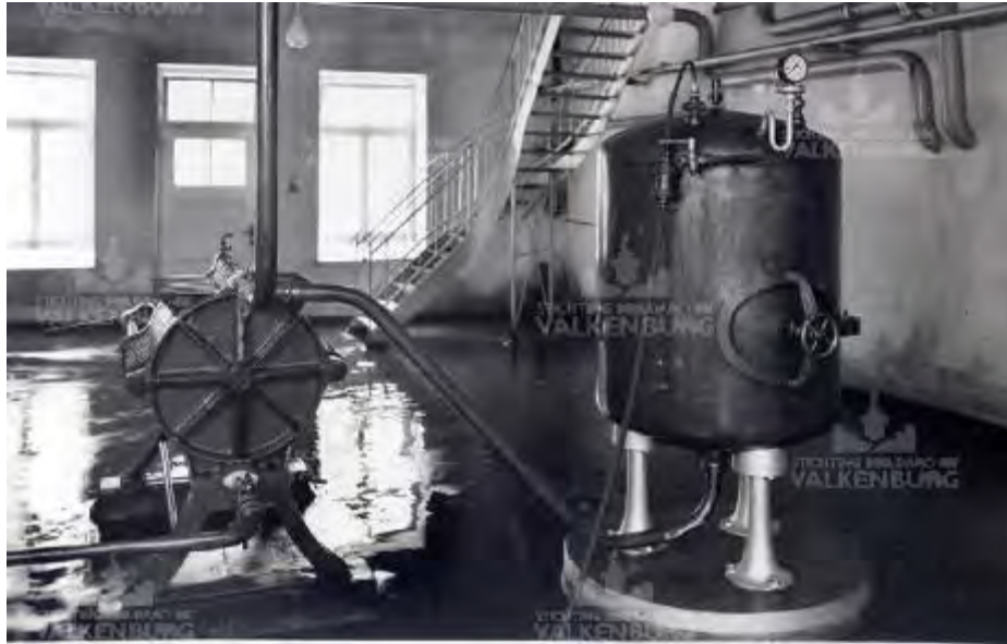
Koelhuis op de verdieping in het westelijke bouwdeel in 1935 met doorgang naar het platdak boven de ruimte waar het ijs werd geproduceerd. Gezien richting het noorden (bron: Beeldbank gemeentearchief Valkenburg LE-0093).
