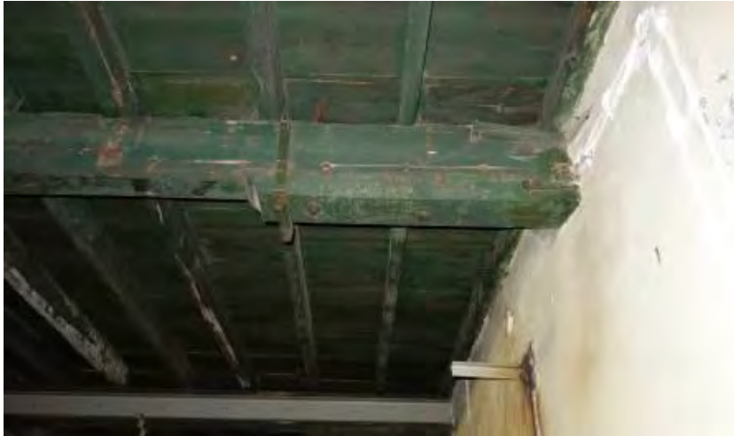
Tweede verdieping met zicht op een samengestelde balklaag met moerbalken met langwerpige sleutelstukken in het oostelijk bouwdeel onder het T-dak, gezien richting het zuiden.
