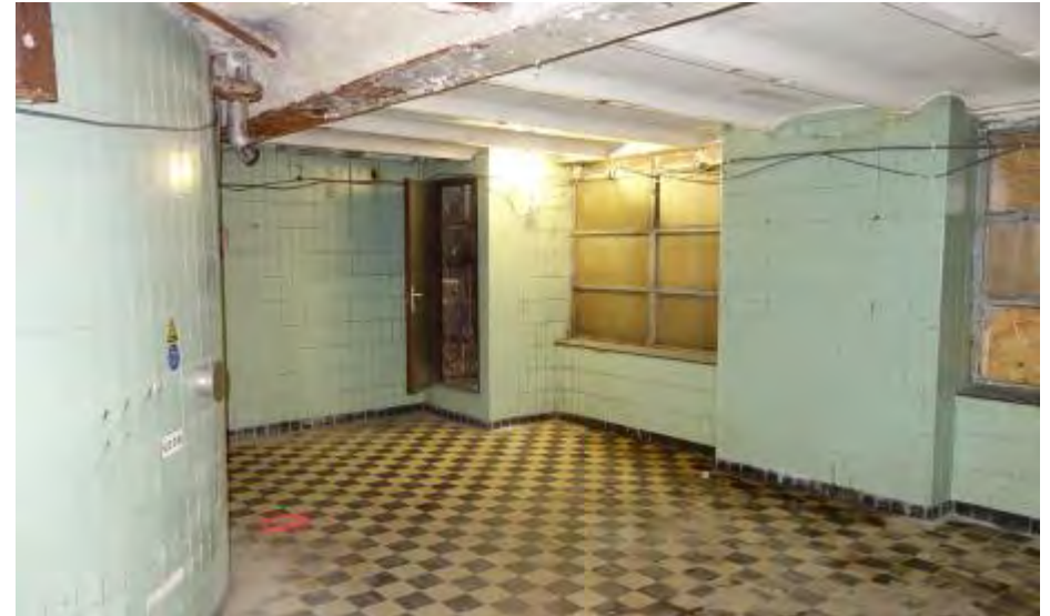
Ruimte 0.3 gezien richting het zuidoosten met links de gebogen wand waar een van de ketels van het bovengelegen brouwhuis staat.
