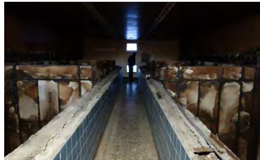
Gistkelder 0.10 gezien richting het westen.
