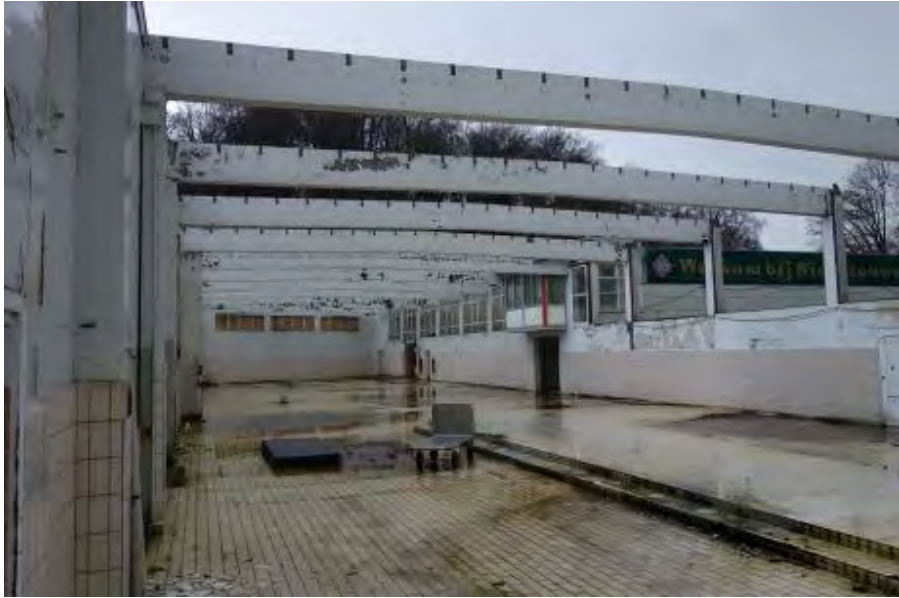
Fabriekshal 0.20 uit 1964 gezien richting het zuidwesten.
