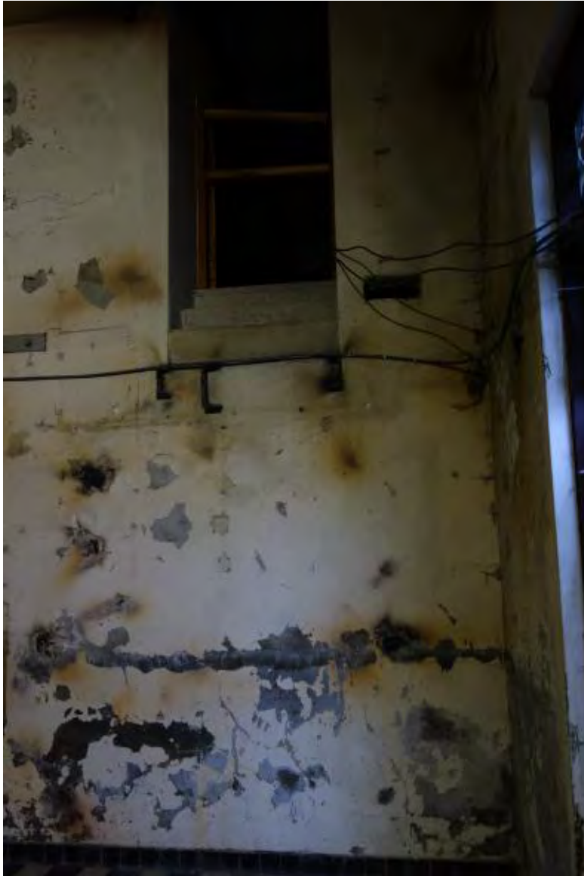
Detail van de doorgang in de westmuur die uitkwam op een stalen overloop.
