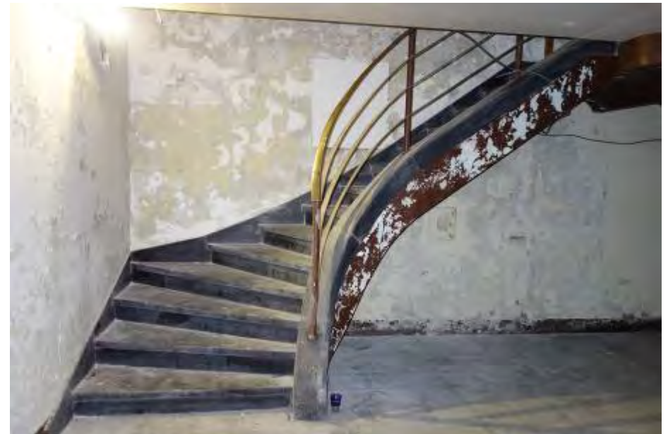
Trapopgang in de zuidoostelijke hoek van de machineruimte.
