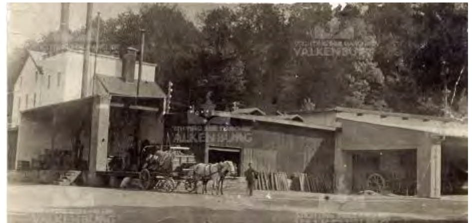
Aanzicht van de brouwerij in 1920 gezien richting het zuidoosten (bron: Beeldbank gemeentearchief valkenburg LE-0004).
