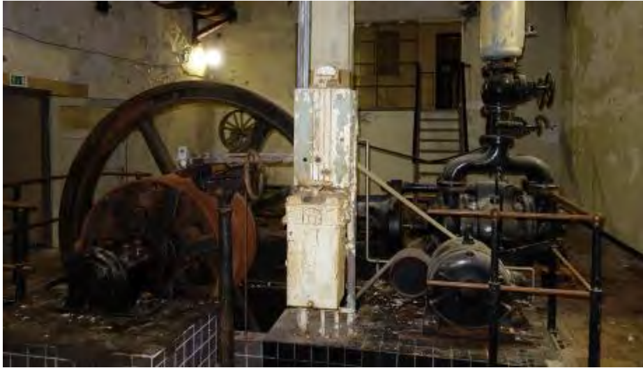
Koelruimte 0.5 gezien richting het zuiden.
