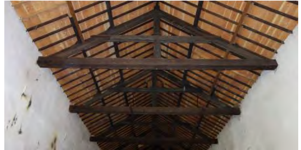
Langwerpig gebouw in de zuidoosthoek van het terrein, gezien richting het oosten.
