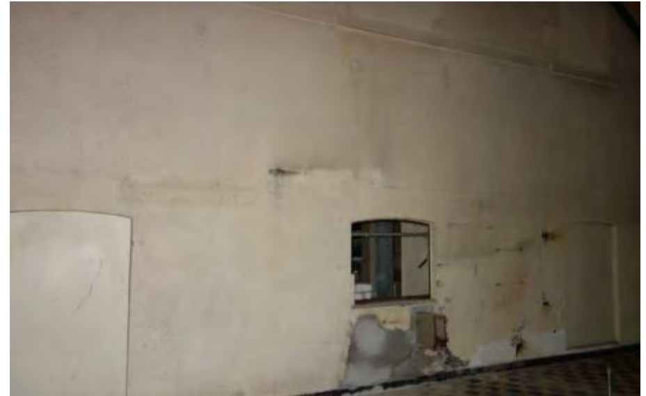
Ruimte 1.3 gezien richting het zuiden met de dichtgezette vensters in de oorspronkelijke noordgevel van het oostelijke deel van het hoge bouwdeel.
