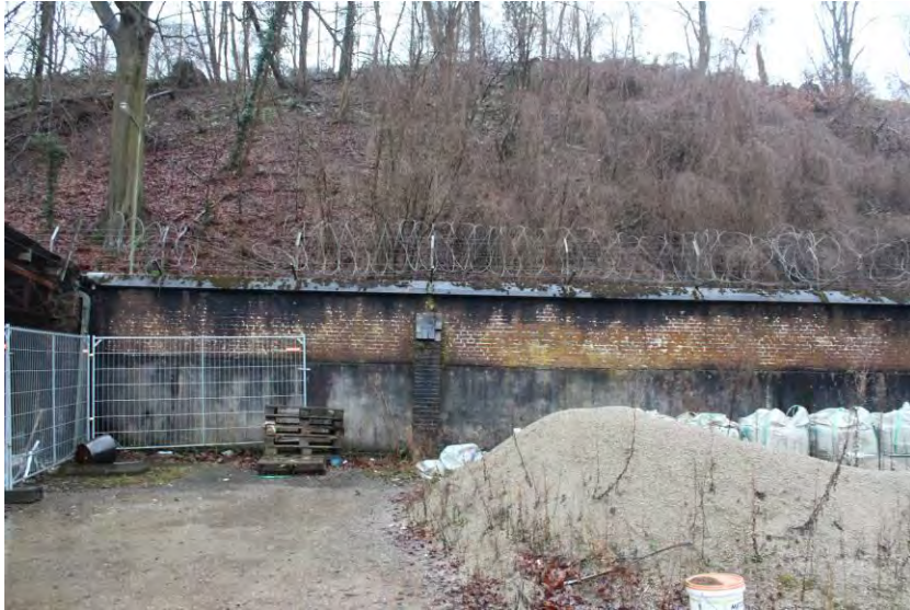
Muur langs de Plenkertstraat, gezien vanuit het noorden.
