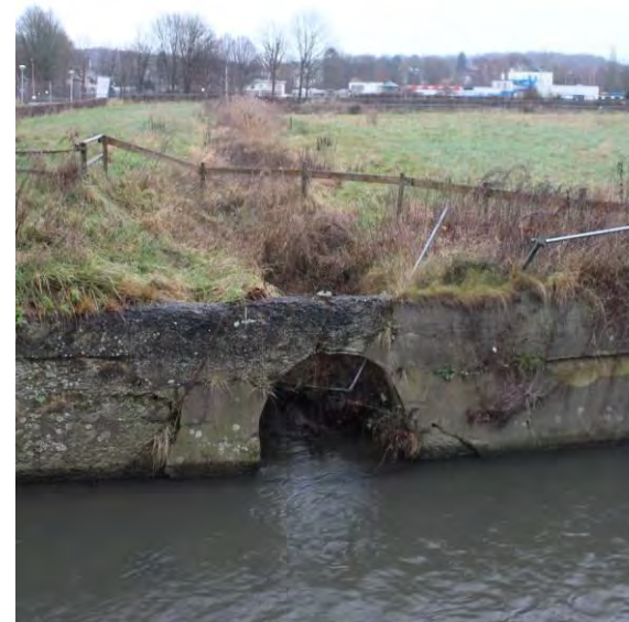
Doorgang in de kademuur ter plaatse van de watergang.
