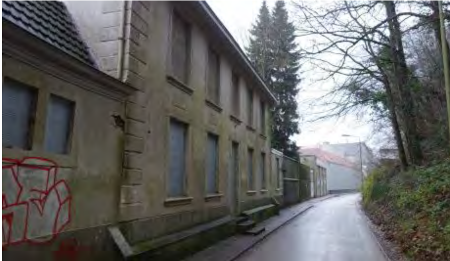
Plenkerstraat gezien richting het oosten met op de voorgrond de zuidgevel van het kantoor en ten oosten daarvan het toegangshek.
