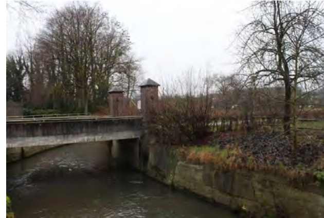
Brug met toegangshek.
