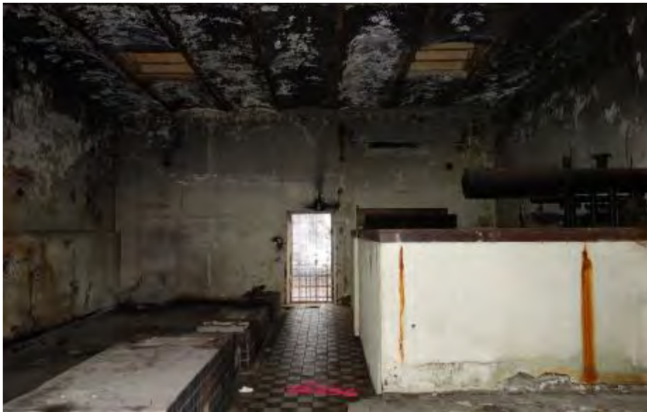
Ruimte 0.6 gezien richting het noorden met rechts de bak die diende voor de ijsbereiding.
