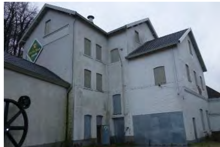
Noordgevel van het oostelijke deel van het hoge bouwdeel (B) met daarvoor de opgehoogde overkapping boven het waterrad, gezien richting het zuidwesten.
