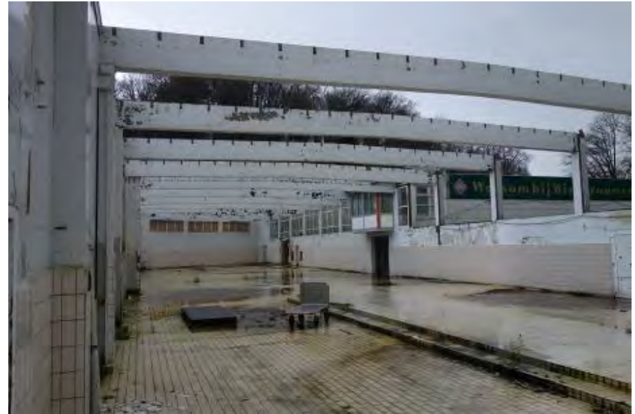
Fabriekshal uit 1964 met betonskelet en betonnen dakliggers, gezien richting het zuidwesten.
