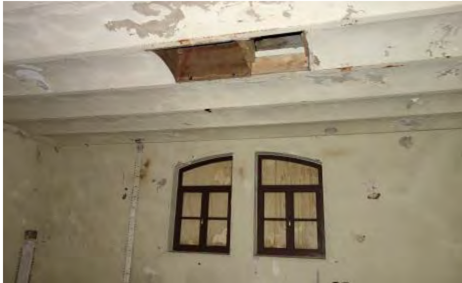
Ruimte 2.2 op de tweede verdieping gezien richting het zuiden.
