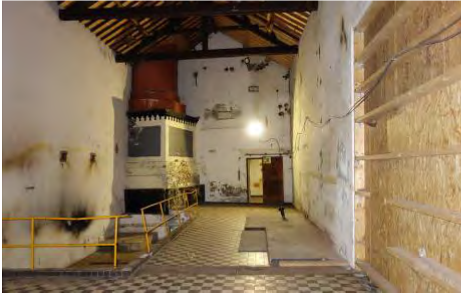
De ruimte 0.1 gezien richting het westen.
