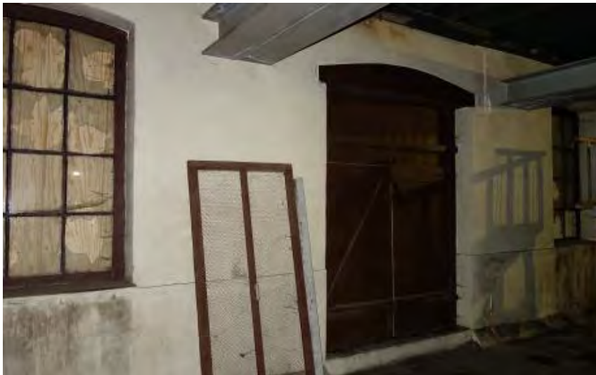
Ruimte 2.1 op de tweede verdieping gezien richting het zuiden.
