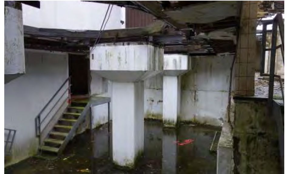
Ruimte 0.13 gezien richting het noorden.
