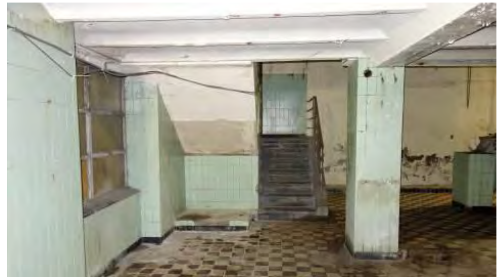
Begane grond met troggewelven, oostelijk bouwdeel onder het T-dak, gezien richting het zuidoosten.
