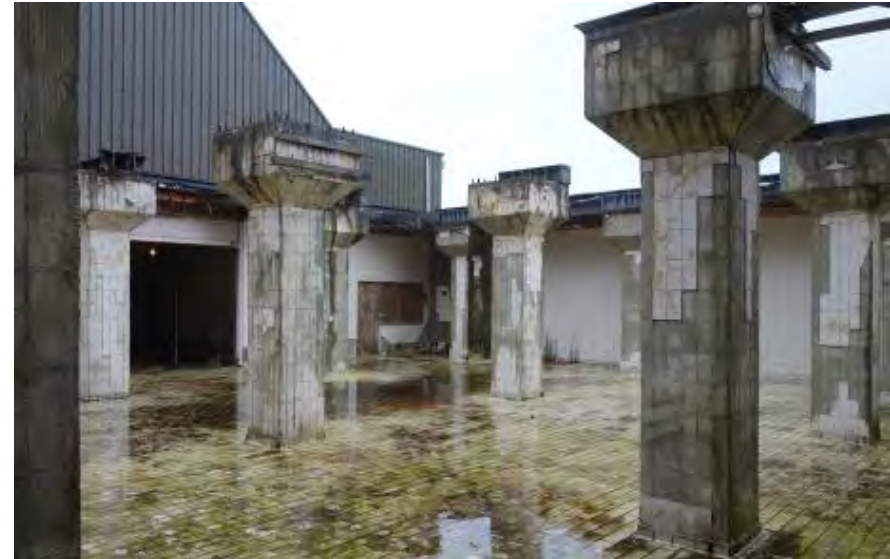
Ruimte 0.12 gezien richting het noordwesten met de betegelde kolommen uit 1991.
