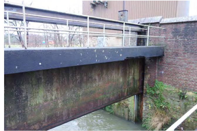
Zicht op de stuw en de noordzijde van de kademuur met de onderste laag uit mergelblokken, gezien richting het noordwesten.
