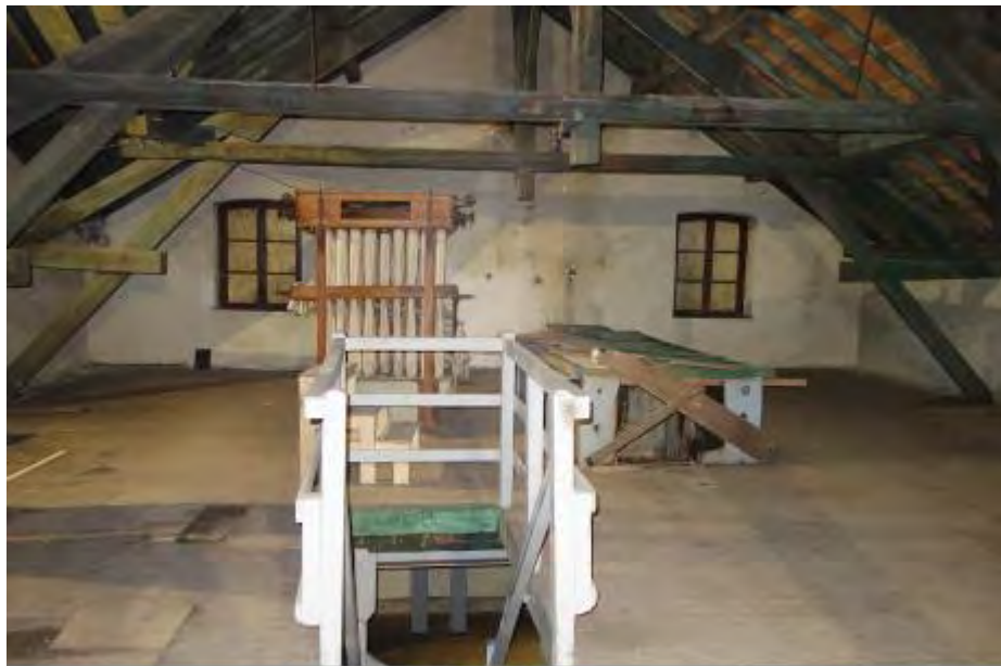
Zolderverdieping gezien richting het noorden.
