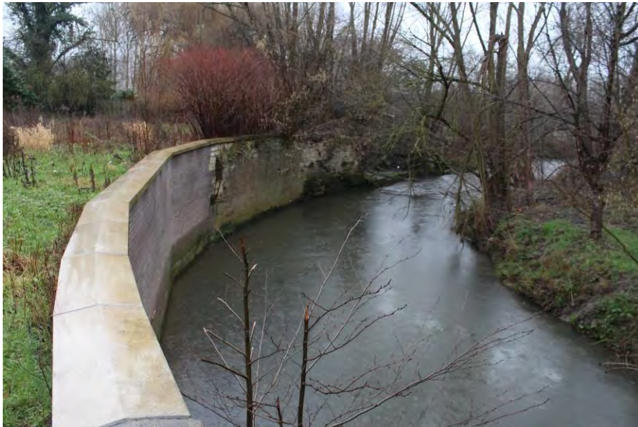
Kademuur langs de Geul achter de voormalige wasserij.
