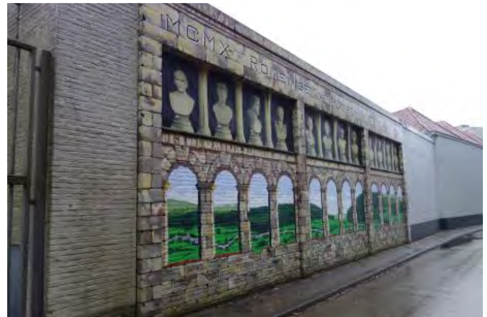
Zuidgevel van de fabriekshal uit 1964, gezien richting het oosten.
