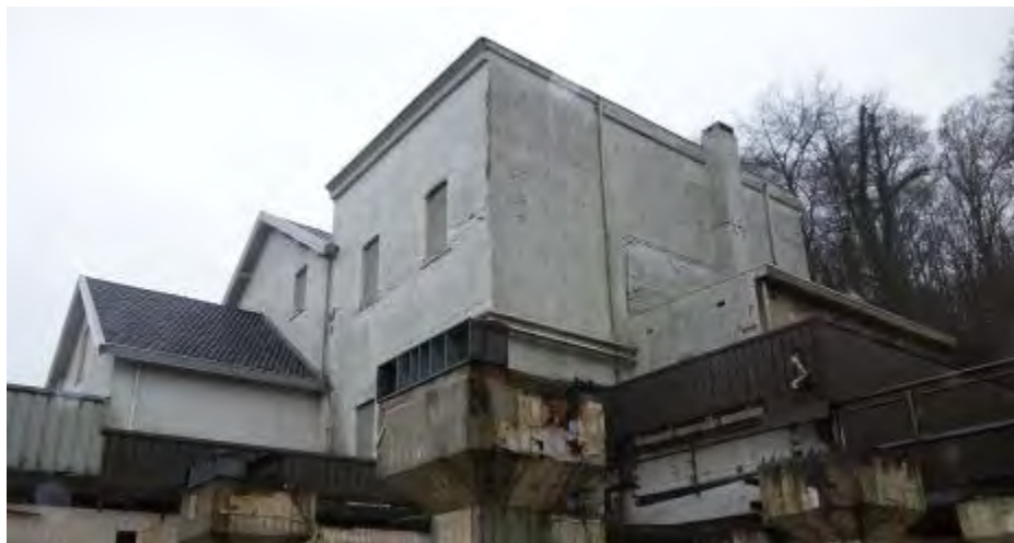
Zicht op de blinde westgevel van het westelijke deel van het hoge bouwdeel, gezien richting het zuidoosten.
