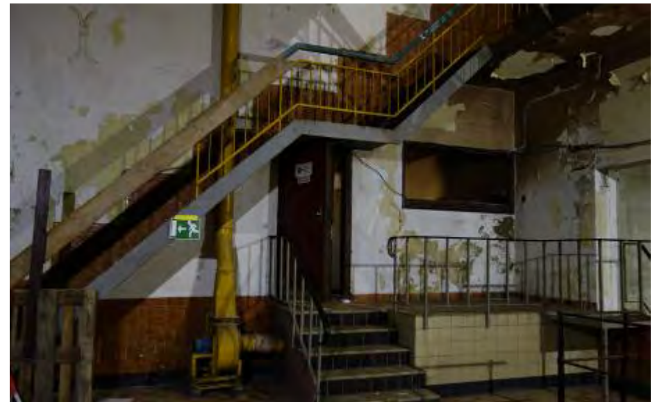
Ruimte 0.8 gezien richting het westen met de trapopgang naar de verdieping van het westelijke deel van het hoge bouwdeel.
