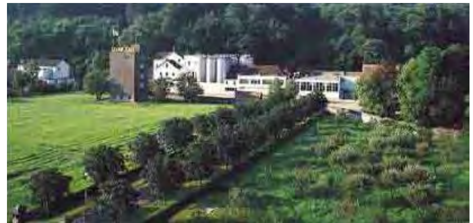
Situatie van het terrein rond 2000, gezien richting het zuiden. De laan die richting het noorden op de Prins Bernardlaan aansluit was aan beide zijden beplant met bomen.
