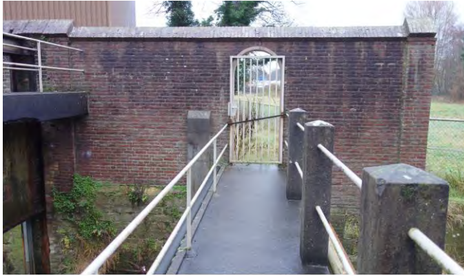
Zicht op de noordzijde van de kademuur met de verlaagde loopbrug en het halfronde poortje in de kademuur.
