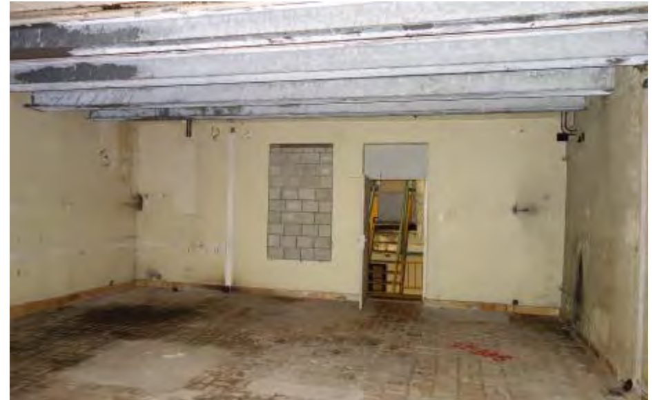
Ruimte 1.2 gezien richting het zuiden.
