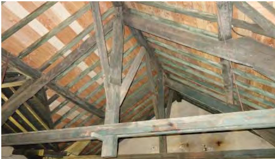
Zolderverdieping met kapconstructie, oostelijk bouwdeel onder het T-dak.
