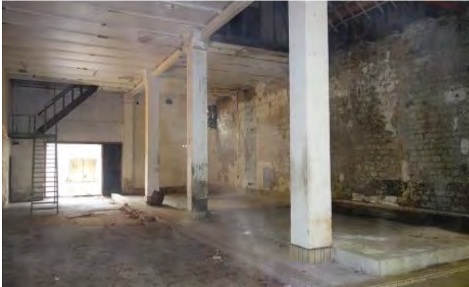
De begane grond met troggewelven uit 1924 van de zogenaamde Schwankhalle gezien richting het zuidoosten.
