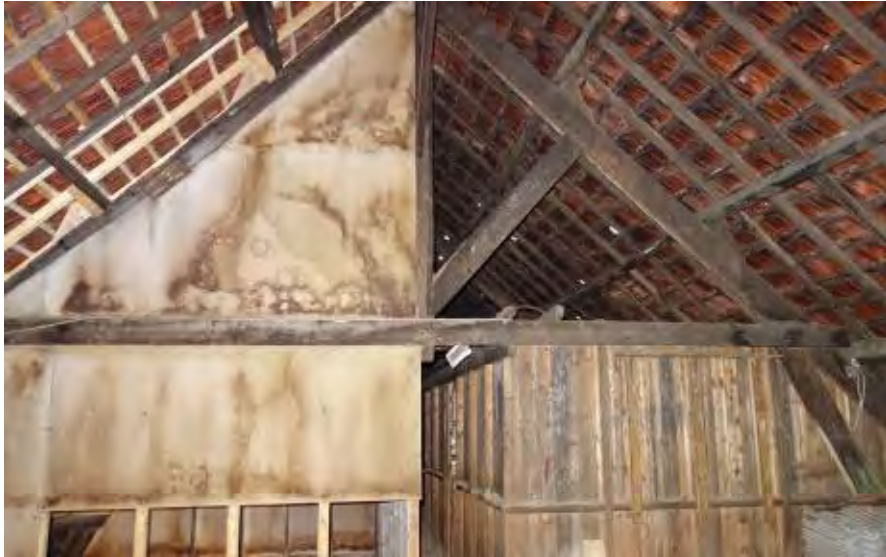
Zolder van de Schwankhalle gezien richting het westen.
