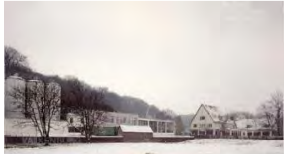
Overzicht van het terrein na 1993 met drie grote silo's op de plek van de Schwankhalle en de nieuwe facade bij hetzelfde gebouw, gezien richting het zuiden (bron: Beeldbank gemeentearchief Valkenburg EUMJ201).
