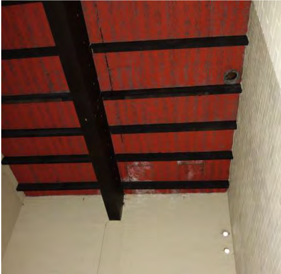
Noordelijke uitbouw tegen de Schwankhalle met moderne moerbalk met ribben uit 1993, gezien richting het westen.
