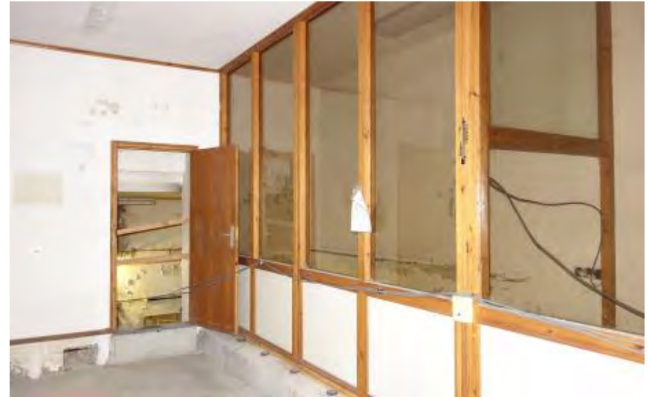
Noord ruimte 1.1 gezien richting het zuiden met glazen scheidingswand.
