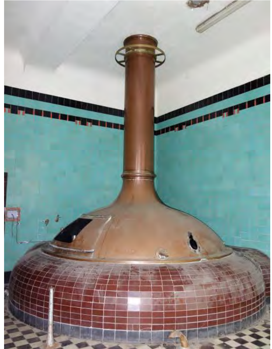
Detail van de zuidoostelijke ketel met interieurafwerking uit 1936.
