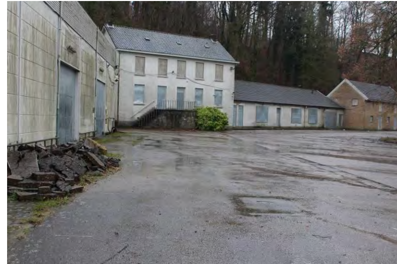
Cluster gebouwen aan de zuidwestzijde van het terrein, gezien vanuit het noorden.
