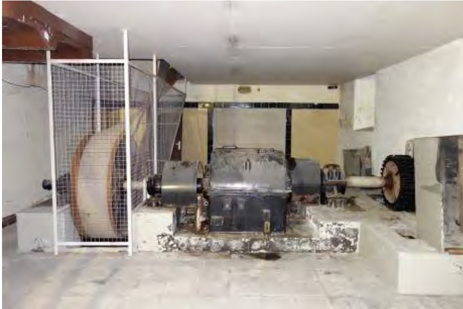
Machineruimte 0.4 gezien richting het westen.
