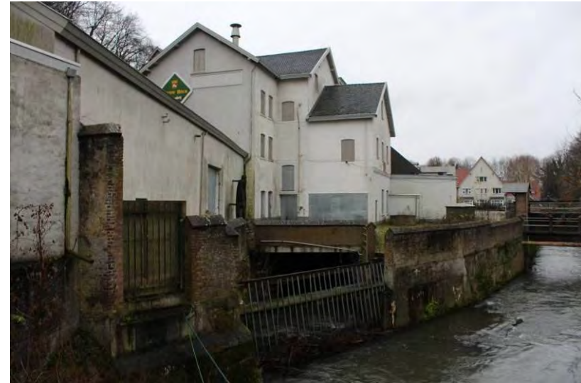
Zicht op de kademuur , gezien richting het westen.
