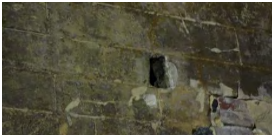
Detailopname van het muurwerk van een van de hallen dat bestaat uit mergelblokken.
