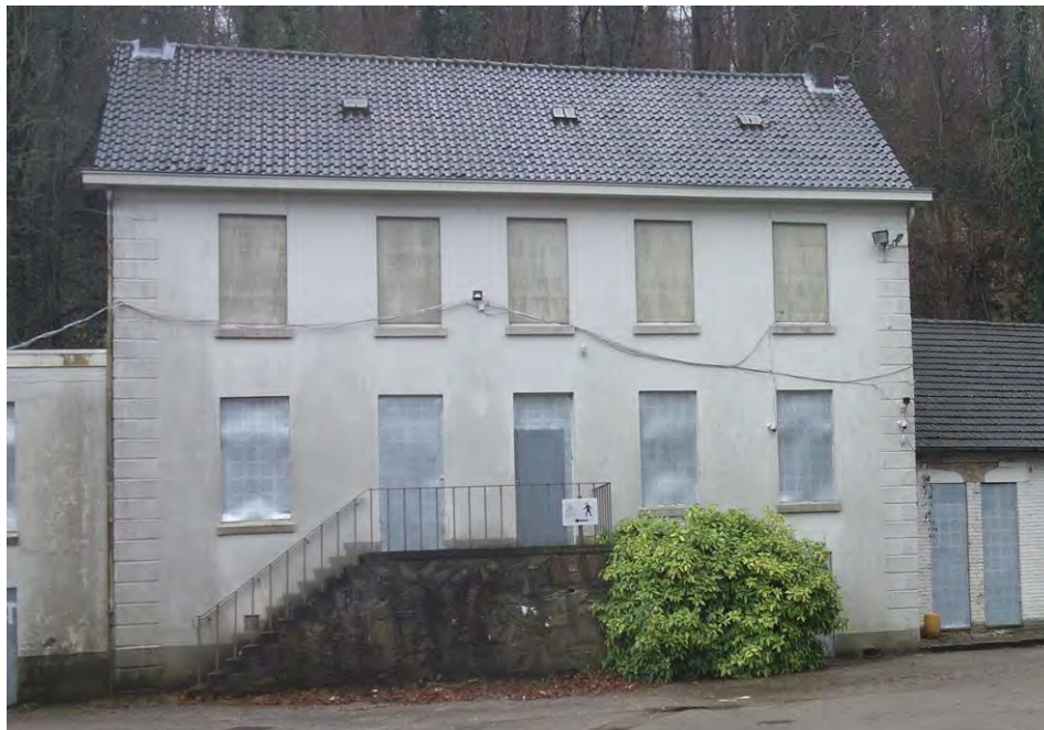
Zicht op de noordgevel van het kantoorgebouw.
