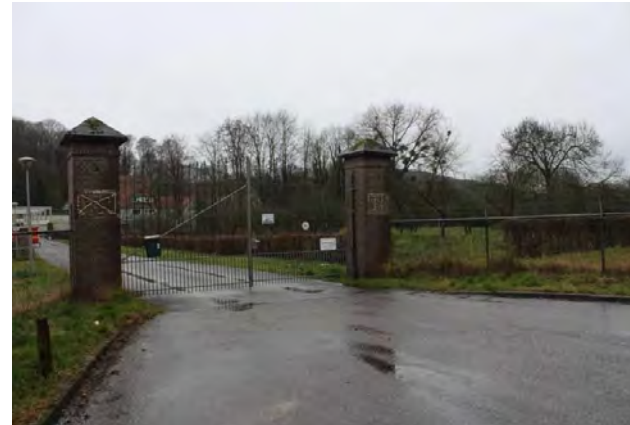
Zicht op de bakstenen kolommen uit 1986 gezien richting het zuiden.
