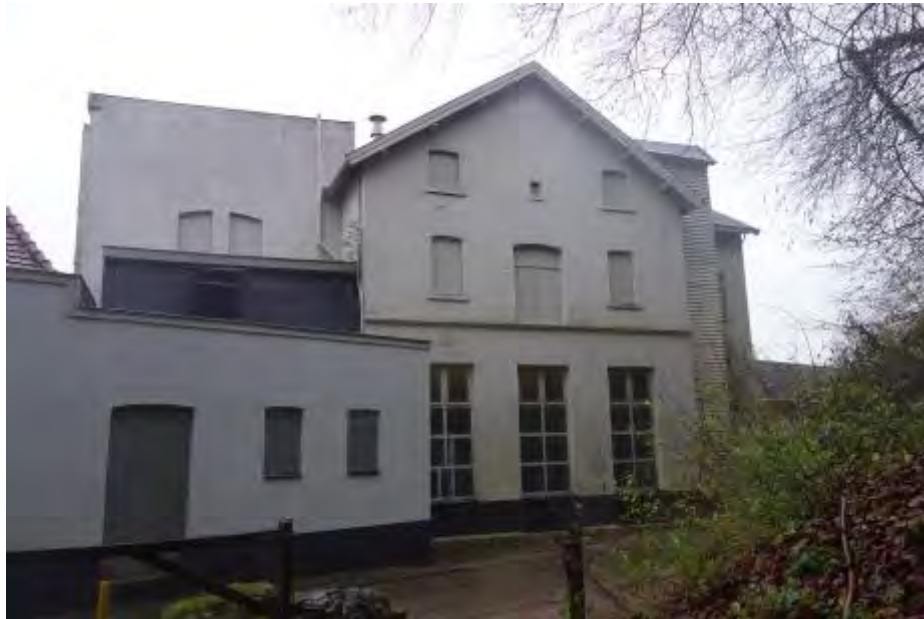
Zuidgevel van het oostelijke en westelijke deel van bouwdeel B met daarvoor bouwdeel C.
