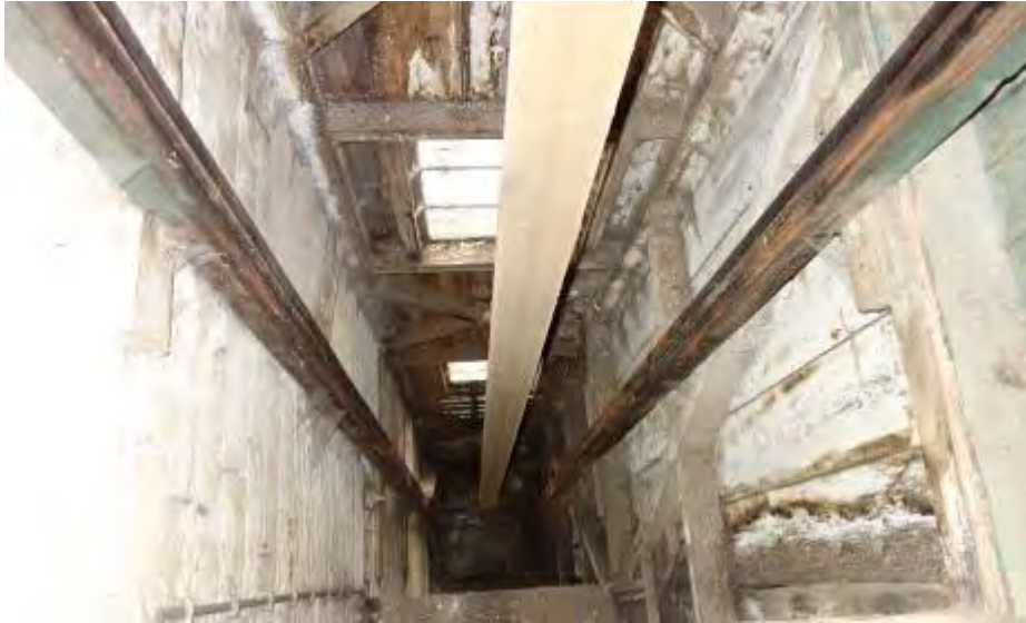
Liftkoker gezien vanaf de tweede verdieping naar beneden.
