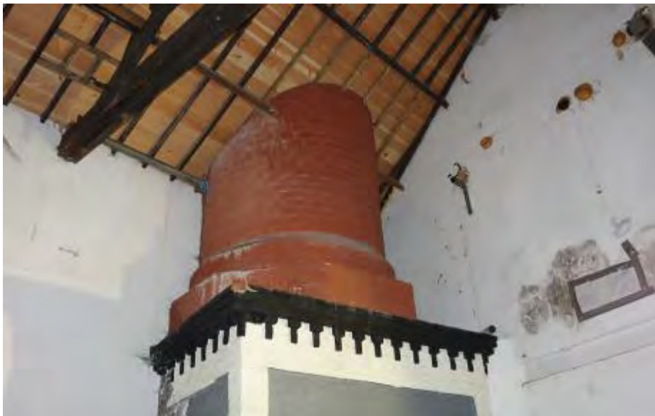
Detailopname van de schoorsteenpijp met basement uit 1886.
