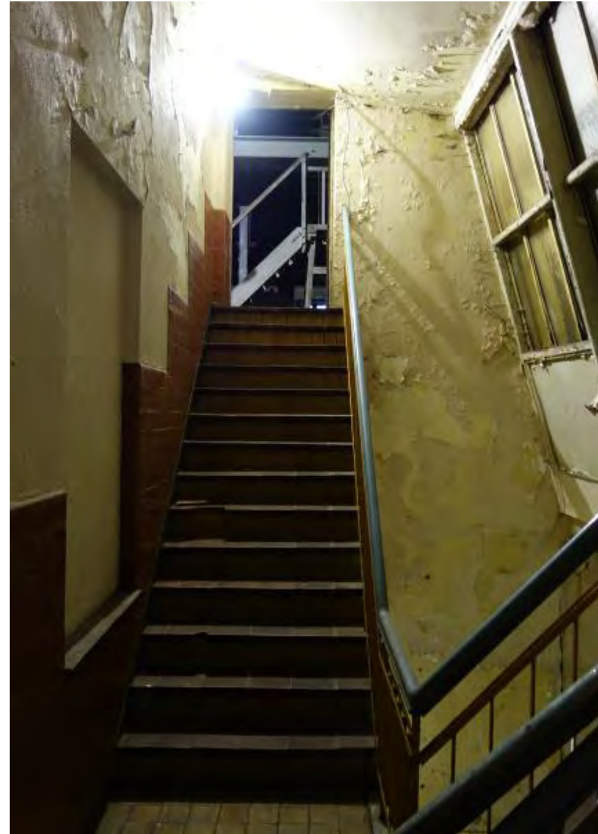
Detailopname van de betonnen steektrap die toegang geeft tot de tweede verdieping van het oostelijke deel van het hoge bouwdeel.
