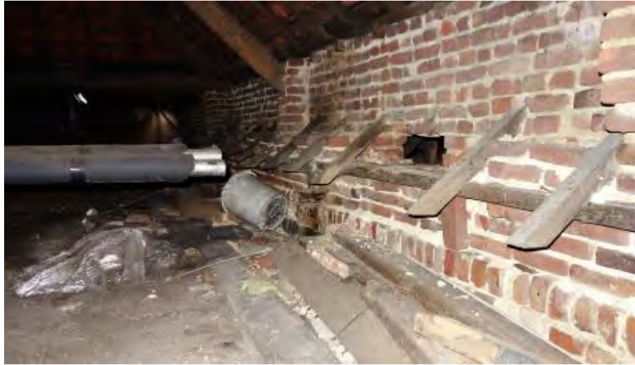
Detailopname van de zuidelijke borstwering met doorstekende sporen.
