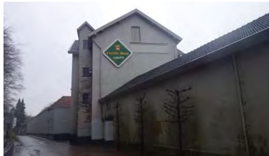
Zuidgevel van bouwdeel A, gezien richting het westen.
