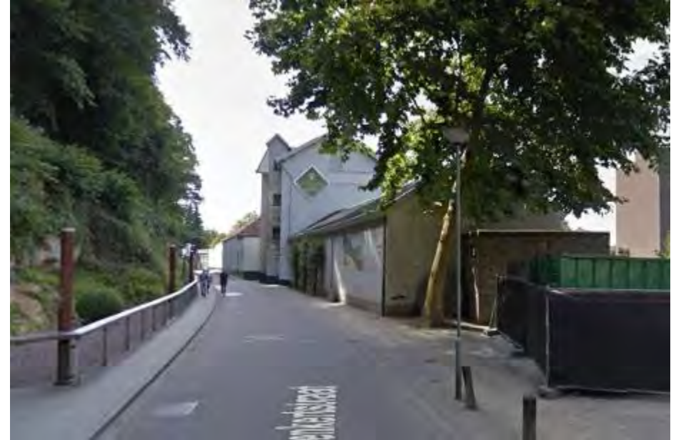
Zicht op de oostgevel van het langwerpige bouwdeel en het oostelijke deel van het hoge bouwdeel. Googlemaps@2015.
