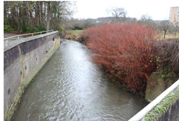
Kademuur langs de Geul, ten noorden van het ontvangstgebouw.
