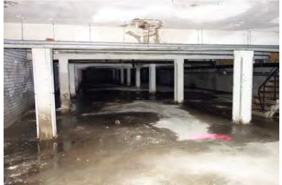
Kelder onder de fabriekshal uit 1964, gezien richting het zuiden.
