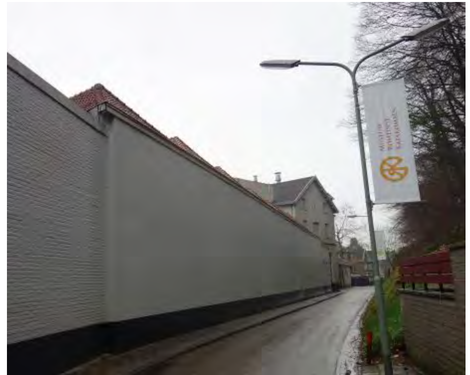
Blinde zuidgevel van bouwdeel D gezien richting het oosten.
