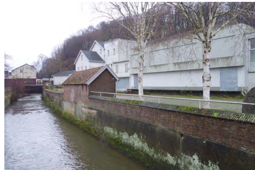
Zicht op de zuidelijke kademuur met de noordgevel van het schuurtje, gezien richting het zuidoosten.
