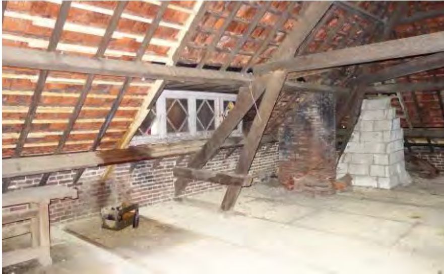
Zolder van de Schwankhalle , detailopname van de zuidzijde van het westelijke gebint.
