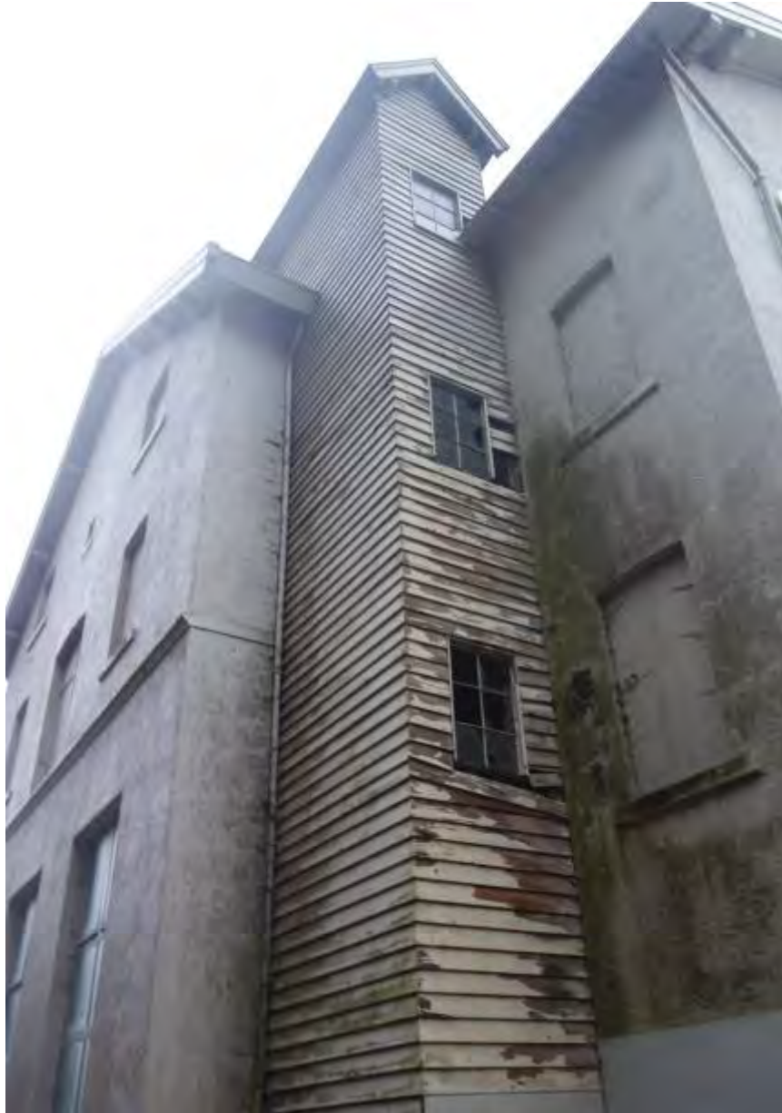
Houten liftekoker in de zuidoosthoek van bouwdeel B.
