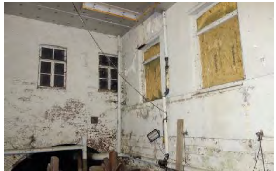
De ruimte van het waterrad gezien richting het noordwesten.
