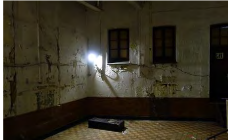
Ruimte 0.8 gezien richting het zuiden.
