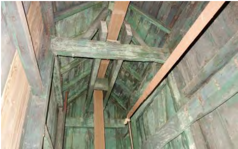
Zadeldak op de liftschacht gezien vanaf de zolderverdieping.
