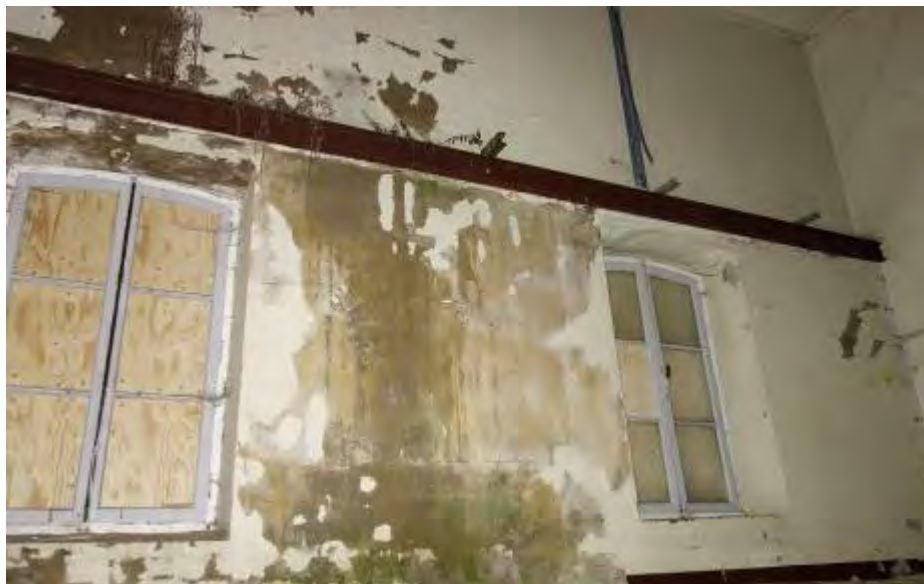
Ruimte 2.2 op de tweede verdieping gezien richting het noorden.
