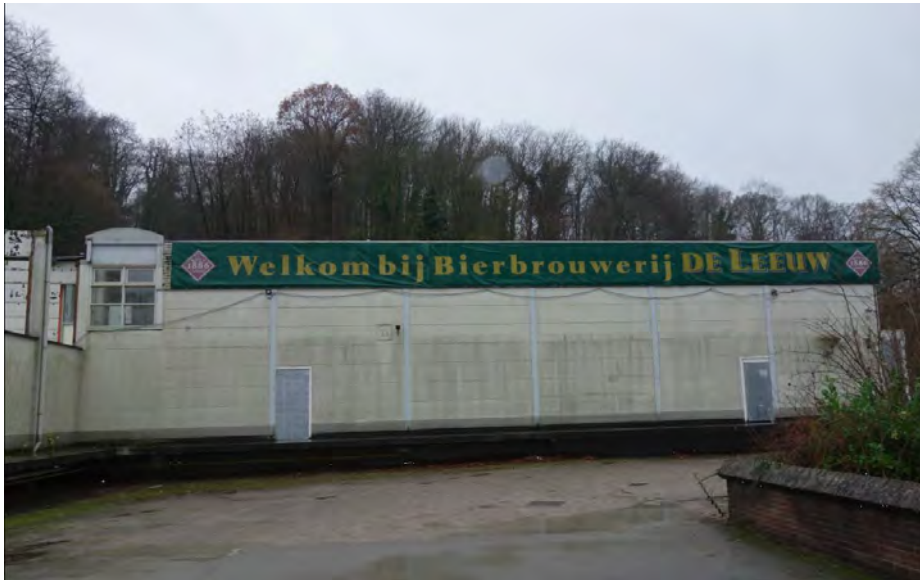
Fabriekshal 0.21 uit 1973 gezien richting het zuiden.
