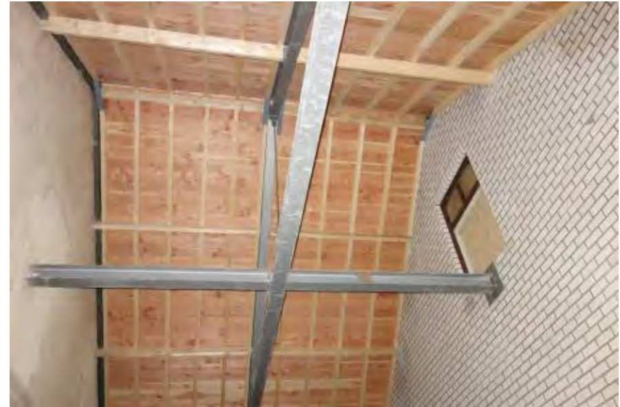
Verdieping, ophoging van het bouwdeel uit 1986 waar het waterrad is ondergebracht, gezien richting het oosten. De kap heeft een stalen spant.
