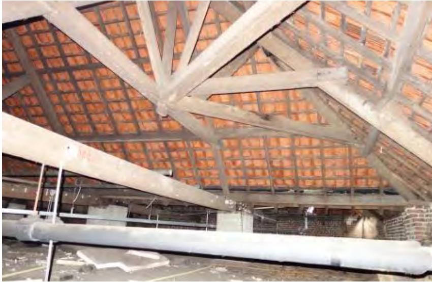
Zolder met kapconstructie boven een van de zes hallen, gezien richting het westen.
