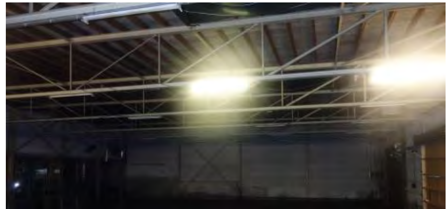
Westelijke hal uit 1973 met stalen vakwerkliggers, gezien richting het zuiden.
