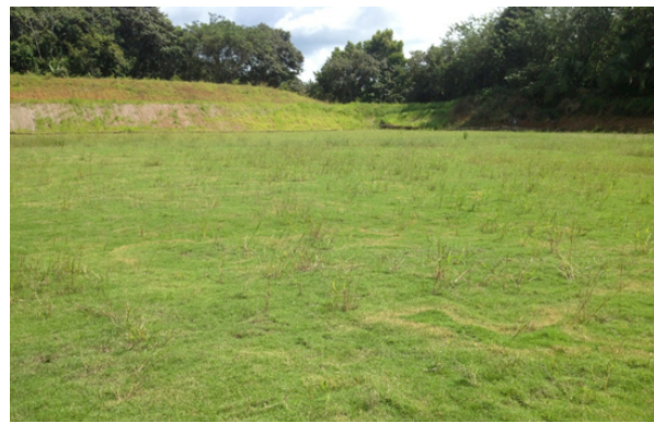
Diseño y Construcción de Polígono de Tiro y su Calle de Acceso. 2014
