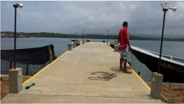
Construcción de Muelle del Batallón Caribe, Narganá. 2011
