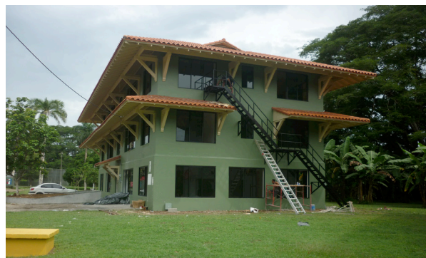
Estructuras del edificio 6012 en el año 2015
