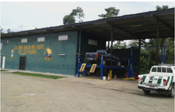
Construcción del Edificio de Motor Pool y Oficinas de Infraestructura y Transporte, 2013
