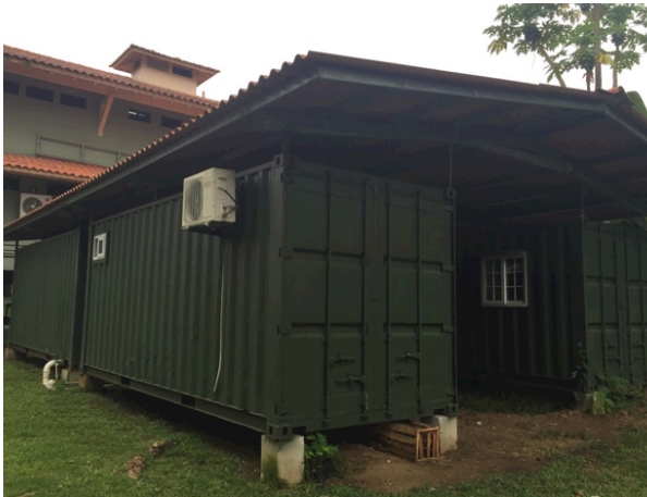
Suministro e Instalación de Módulos de oficina tipo Contenedor y Construcción del Techado para los mismos en la parte posterior del Edificio 6006. 2015
