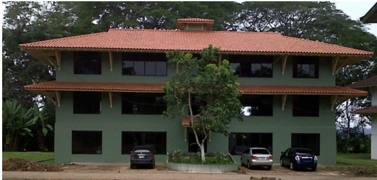
Remodelación de los Edificios 6005 y 6012 de Summit, Ancón. 2011-2012
