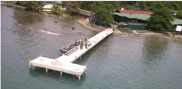
Construcción de Muelle del Batallón Caribe, Puerto Obaldía. 2012
