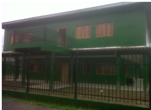
Construcción del Cuartel de Paso Canoas. 2010-2012
