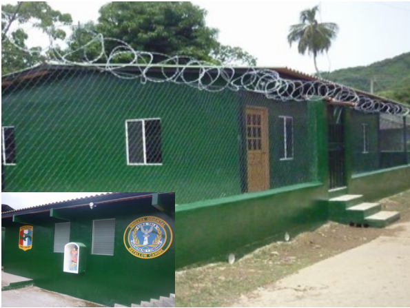
Construcción del Cuartel del Batallón Caribe, Puerto Obaldía. 2011
