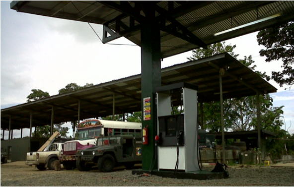
Construcción de Estación de Expendio de Combustible en la Base de Primera Brigada. 2012
