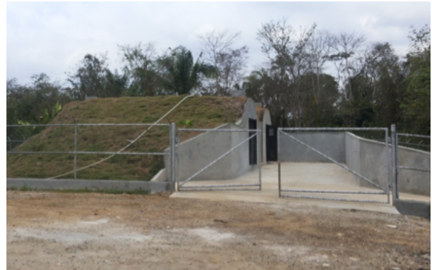
Diseño y Construcción de Dos Bunkers con su Calle de Acceso en la Primera Brigada Oriental, 2013
