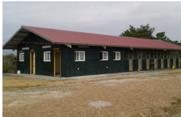
Construcción de la Cuadra Canina en la Primera Brigada Oriental. 2014
