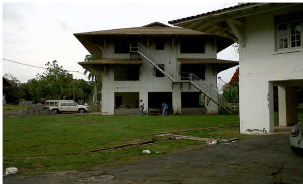
Estructuras del edificio 6012 en el año 2009
