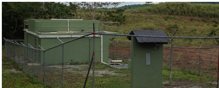
Construcción de Planta de Tratamiento de Aguas Residuales. 2012
