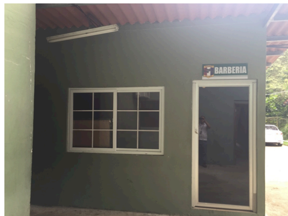
Remodelación del Antiguo Paquito para la Nueva Barbería. 2015
