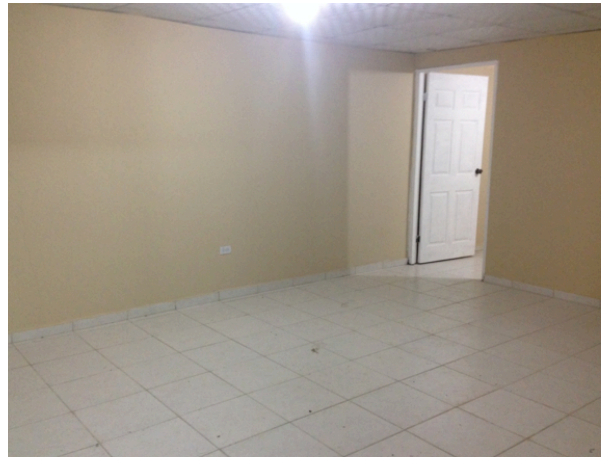
Construcción de Laboratorio de Visores Nocturnos en la Armería del Edificio 6007. 2014
