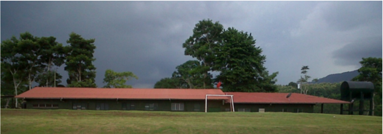
Construcción de la Cuadra Anexo de la Agrupación de Fuerzas Especiales A.FF.EE. en la Base de Primera Brigada Oriental, 2012
