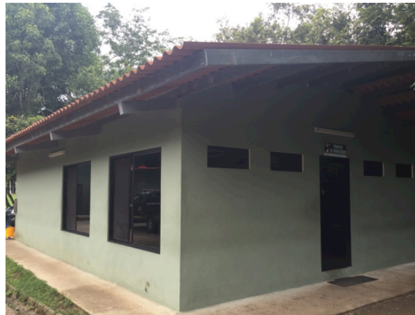
Construcción del Paquito. 2015
