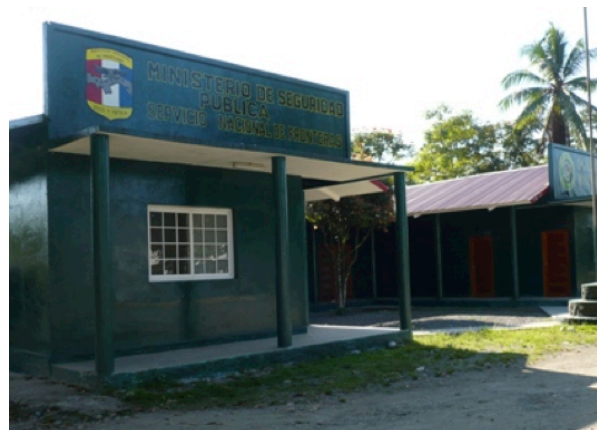
Construcción de la Base de Progreso. 2009-2012
