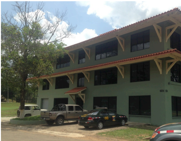
Remodelación del Edificio 6011. 2014
