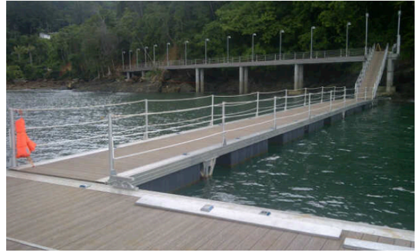
Construcción de Muelle Flotante del Batallón Pacífico en La Playita, Puerto Piña, 2012
