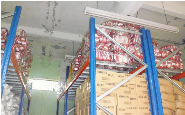
Adecuación de las instalaciones para el almacenamien- to de logística En el año 2012
