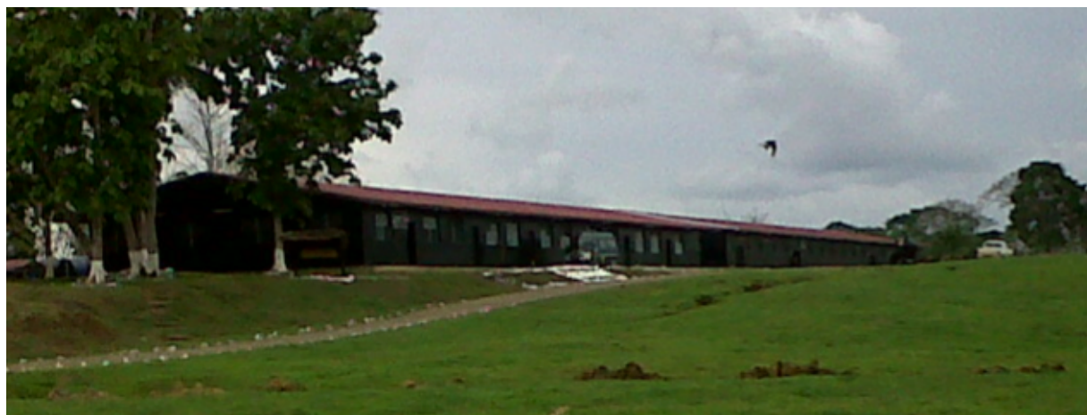
Construcción de Aulas de Clases y Cuadras Masculina y Femenina en la ACAFRONT. 2012
