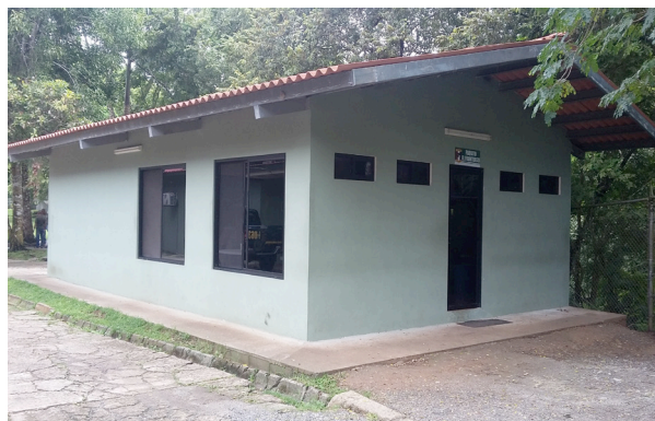
Finalización de los trabajos de construcción del Kiosco de Summit.
