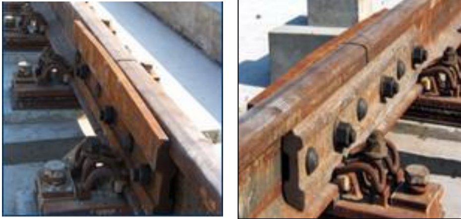
图 4.4-1 减振接头夹板
