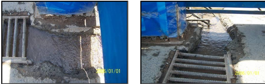
图 3.3-3 施工场地排水类比调查（西安地铁二号线钟楼站）
