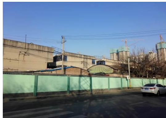
王家坟主变电站现状
