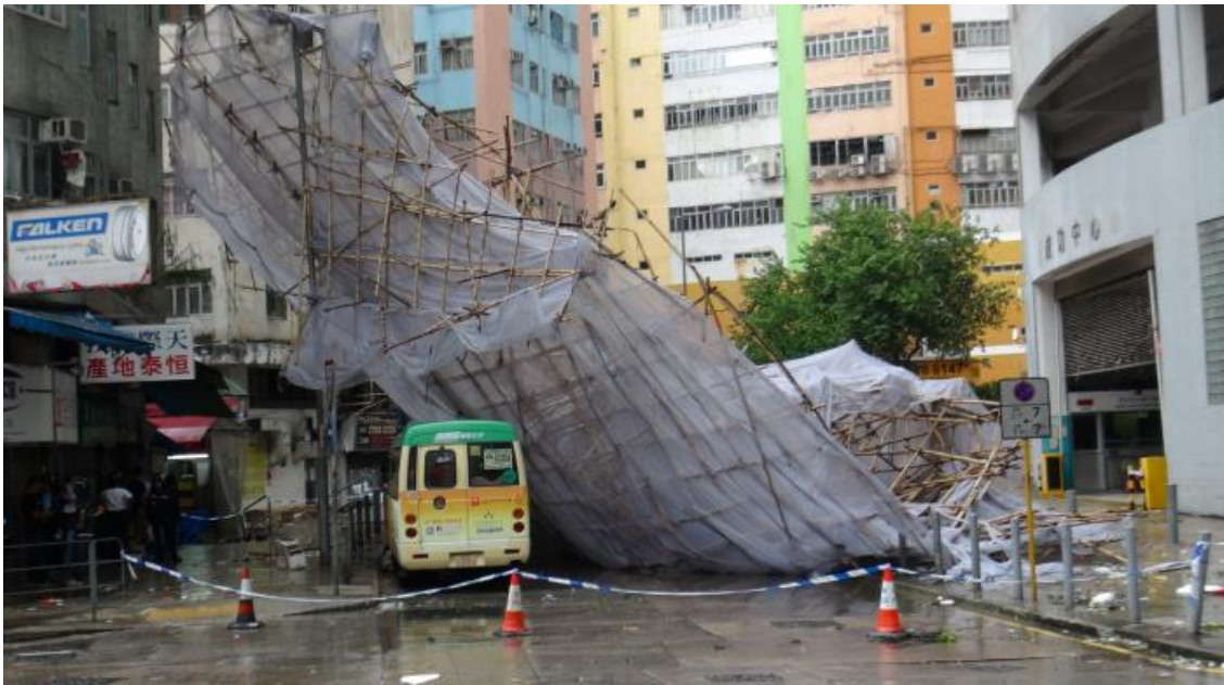
圖 3.4.9 颶風海鷗吹襲期間，葵涌打磚坪街有一幅棚架倒塌，導致一輛貨車及一輛小巴損毀(相片由星島日報提供)。
