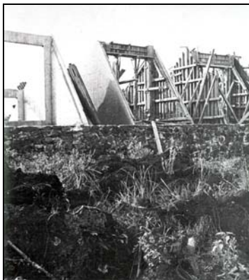
Construcción de los prismas.
