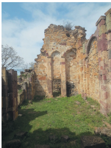
9. Кусирети. Интерьер. Западная стена. Фото автора Kusireti. Interior. Western wall. Photograph by the author
