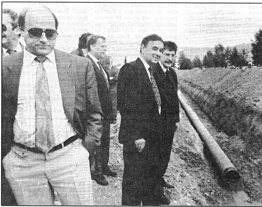
MM. Düblin, Mertenat et Kaech ont présenté le chantier ouvert aux représentants communaux concernés par l'arrivée du gaz naturel.
