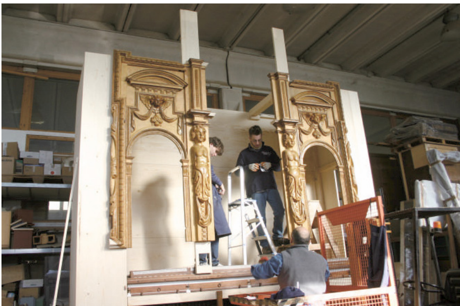
Ricomposizione delle decorazioni lignee di facciata.
