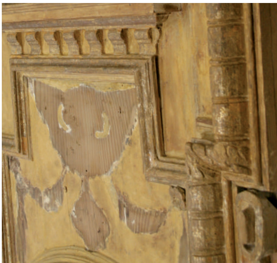
Pulitura del fornice e rimozione delle decorazioni.
