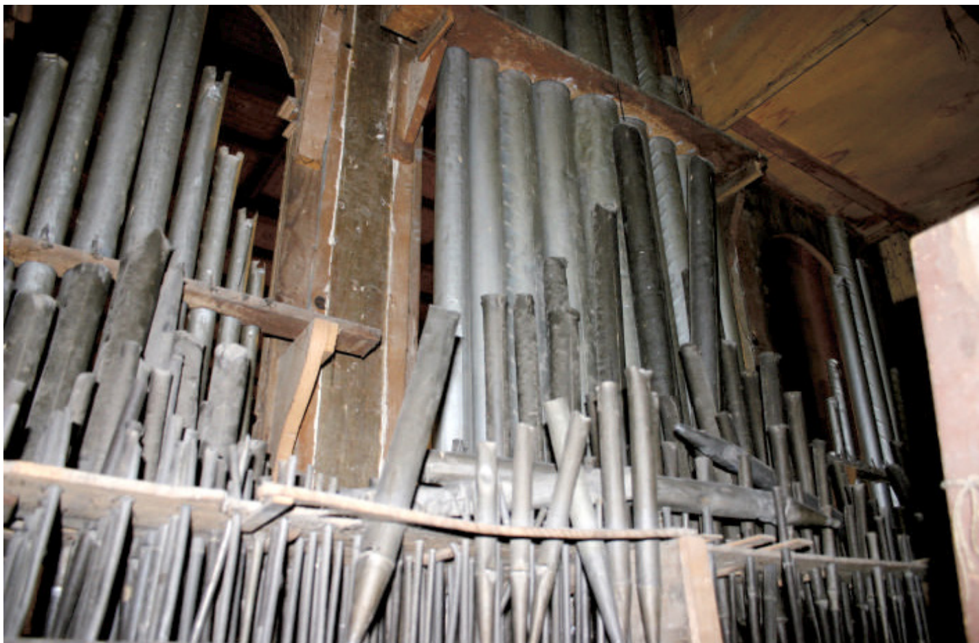
Canne interne prima del restauro.
