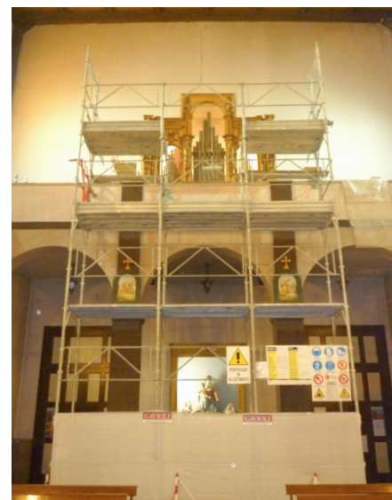
I ponteggi durante i lavori.
