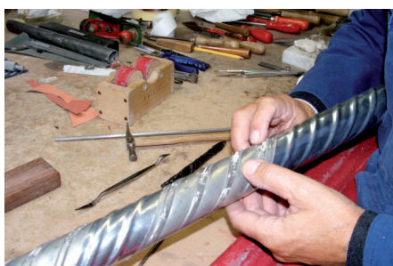
Restauro delle canne a tortiglione in facciata.
