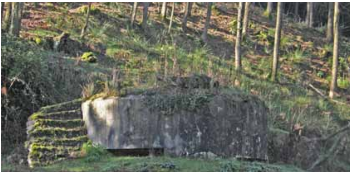
Fig. 65: Obra n. 24. Vista exterior del nido de ametralladora (Vid. fig. 42, letra F). Es claramente visible por no estar camuflado, debido a que es una obra inconclusa. Se aprecian también las alas laterales, escalonadas, realizadas en mampostería, destinadas a contener las tierras.
