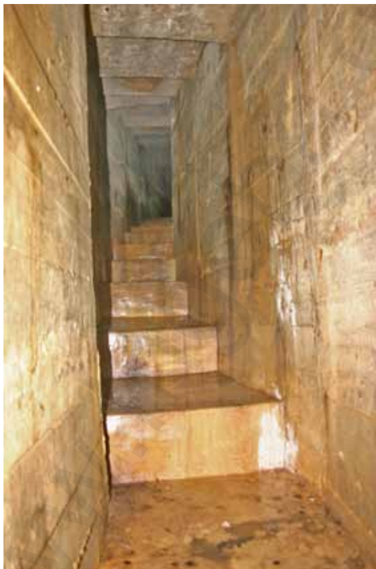
Fig. 7: Galería no abovedada de la obra n. 2.
