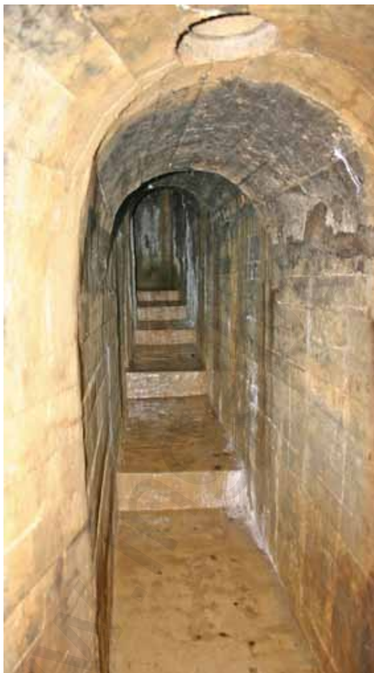
Fig. 6: Galería abovedada de la obra n. 5. Nótese los escalones y el orificio superior.
