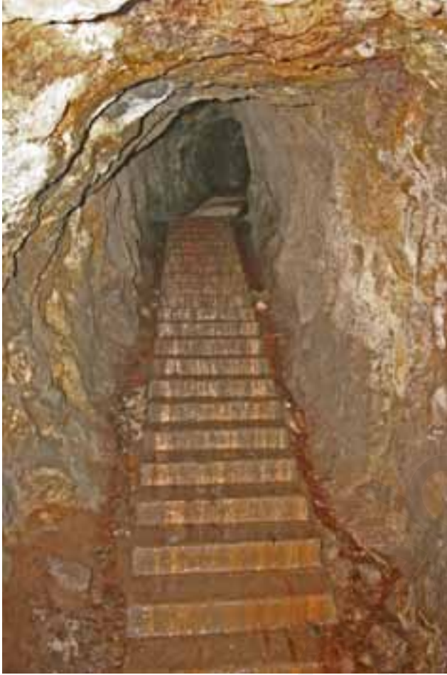
Fig. 80: Observatorio de Arkale. Tramo ascendente mediante escalera, sin que presente revestimiento de hormigón.
