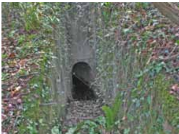
Fig. 54: Acceso a la obra n. 6.
