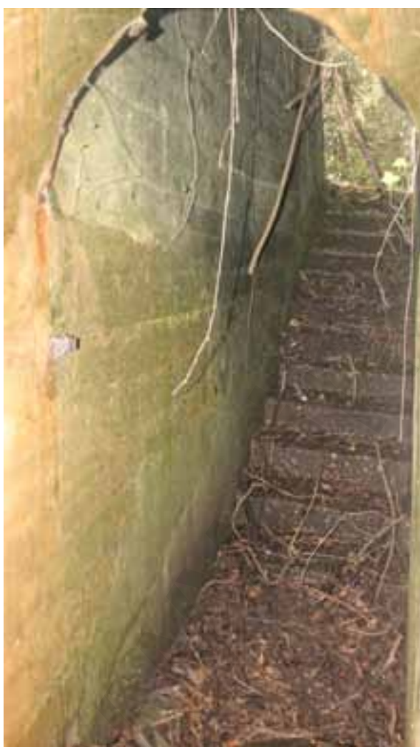
Fig. 52: Acceso a la obra n. 3, visto desde el interior. El descenso tiene lugar por medio de una docena de escalones.
