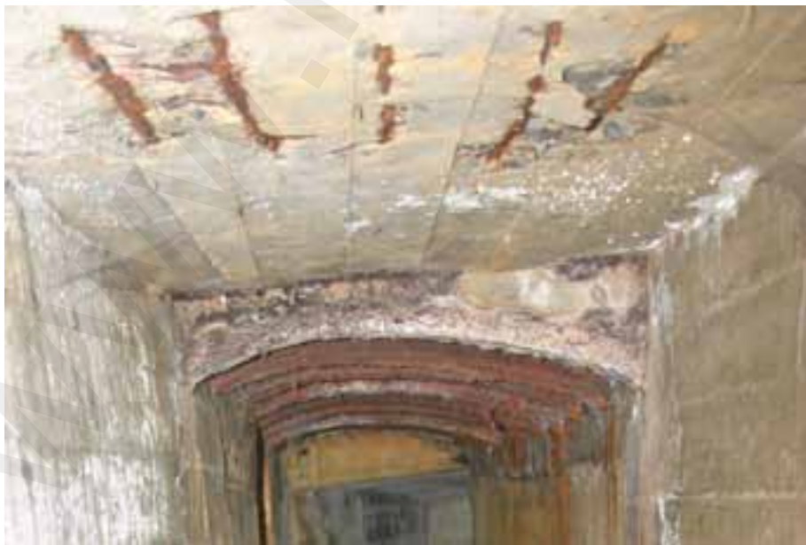
Fig. 43: Obra número 2. En primer plano, el techo adintelado de la galería y en segundo plano, un sector de bóveda muy rebajada reforzada por viguetas metálicas.
