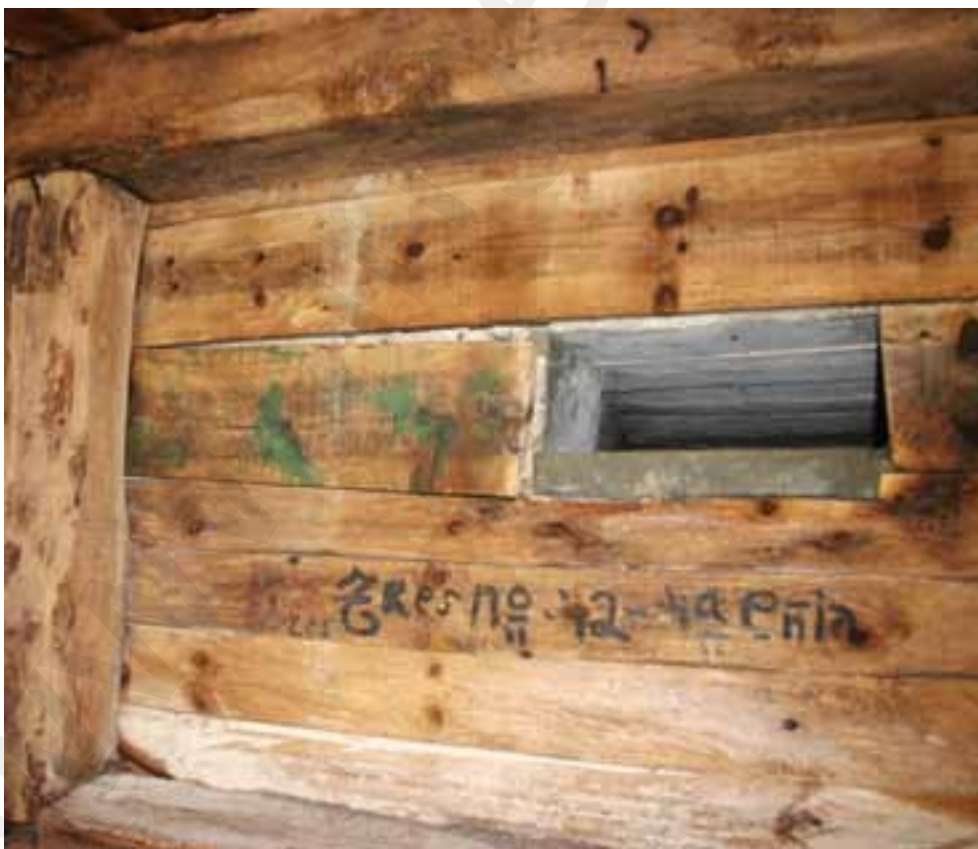
Fig. 14: Inscripción realizada con pintura roja y negra sobre el encofrado de un nido de la obra n. 3: Bon [Batallón] Tres [Trabajadores] nº 42 – 4ª Cñia [Compañía]. Constata la participación de los Batallones de Trabajadores constituidos por represaliados del bando republicano en la fortificación Vallespín.
