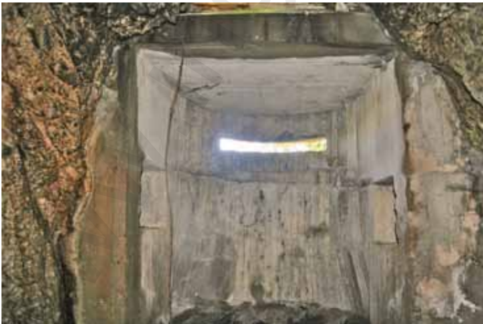
Fig. 81: Observatorio de Arkale. Emboquillado de la abertura de observación mediante un tambor de hormigón. Vista desde el interior.
