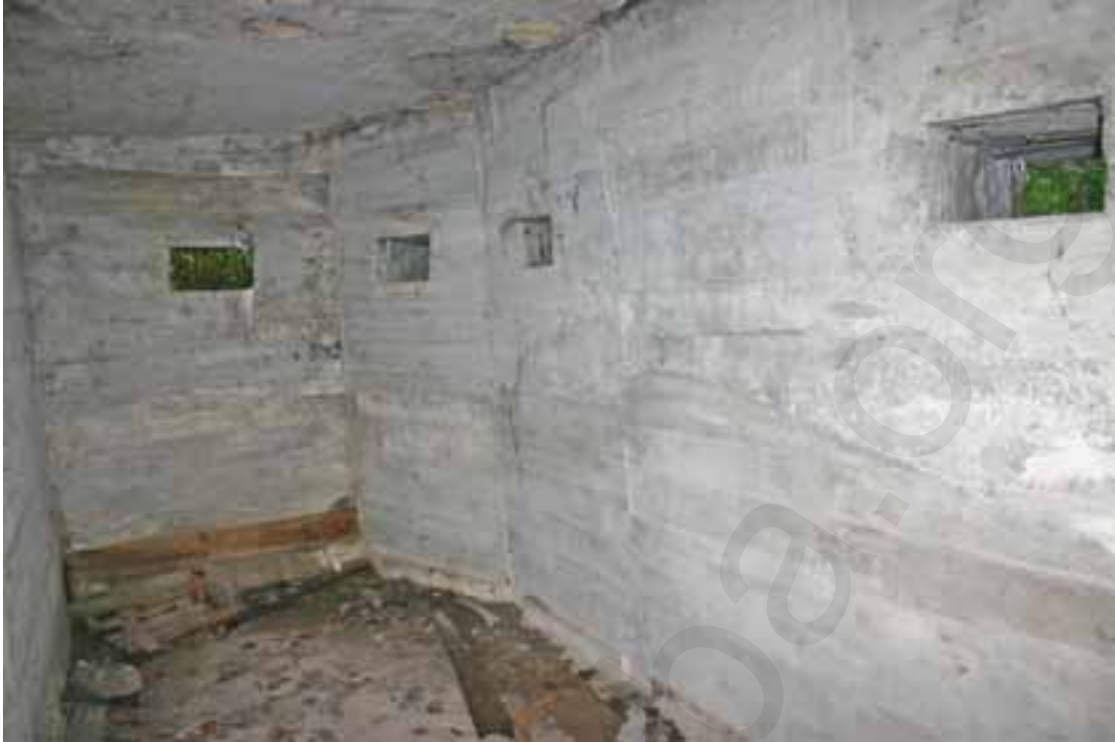
Fig. 71. Obra 25. Interior del refugio activo. Está desprovisto del encofrado y se aprecian en la fotografía cuatro de las cinco aspilleras que posee. Nótese que los refugios no poseen el resalte perimétrico que tienen los nidos.
