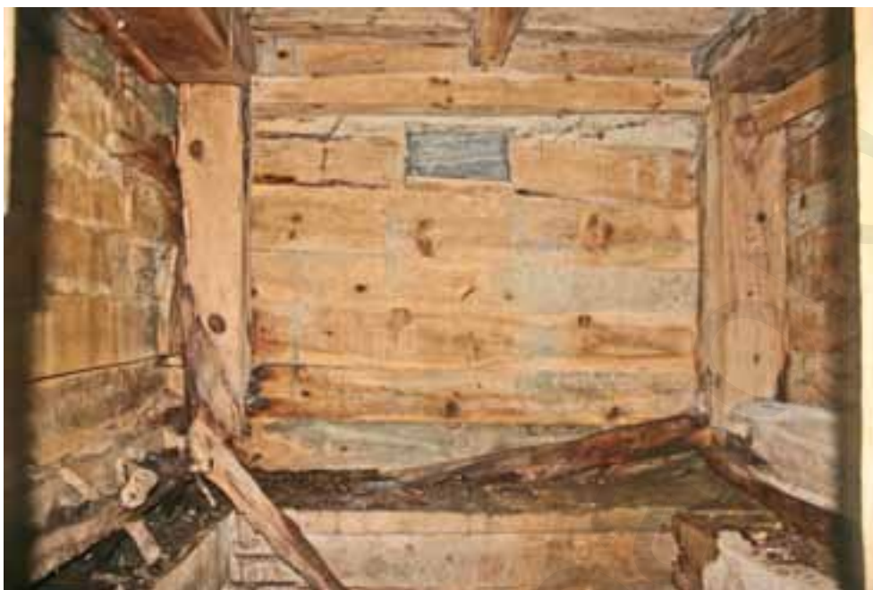
Fig. 5: Interior de un nido de ametralladora de la obra n. 3. Puede apreciarse que conserva el encofrado de madera, así como el resalte inferior de hormigón.
