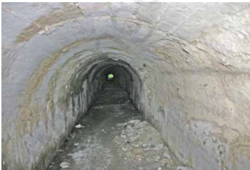
Fig. 35: Fot. Superior: Organización defensiva n. 1 (Gaintzurizketa) : Galería general. Cruce y. A la izda, la galería de acceso al puesto de mando (z-y), a la derecha, el puesto de mando y al frente la galería de acceso a la obra n. 4 (y-u).
