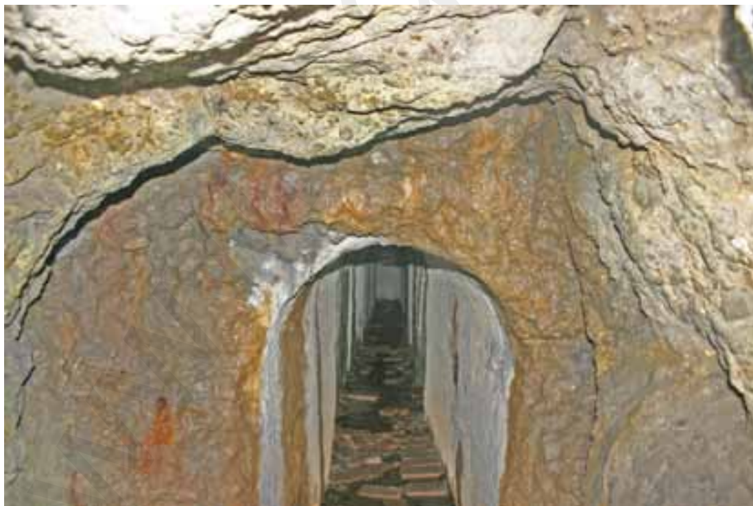
Fig. 79. Observatorio de Arkale. Tercer tramo de la bocamina A. La mitad del mismo está revestido de hormigón, formando bóveda y la otra mitad está excavado en la roca. En la fotografía se puede contemplar el paso entre uno y otro sectores.
