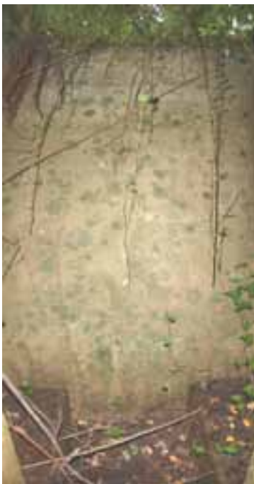
Fig. n. 4: Fotografía en contrapicado de un pozo de tirador de la obra número 2. A ambos lados pueden apreciarse las banquetas para facilitar el disparo.
