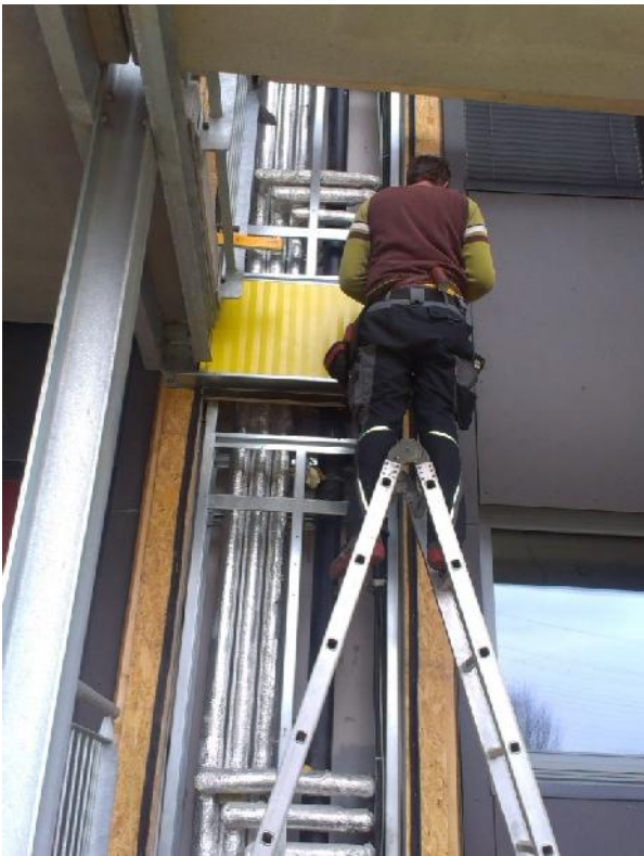
Abbildung 2: Vorgefertigter Haustechnikschacht in der Fassade
