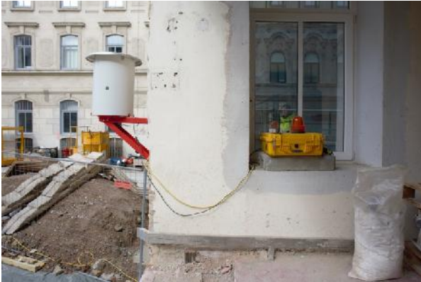
Abbildung 2: DiMoSy Installation. Tachymeter unter Schutzhülle, Alarmsirene sowie Funkmodul zu weiterer Tachymeter-Station
