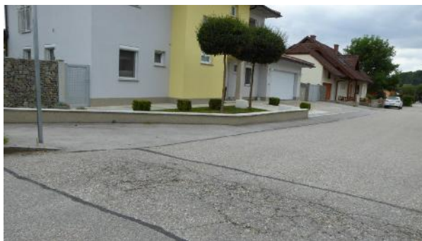
Abbildung 6: Nachträglich errichtete Schutzmauer als private Präventionsmaßnahme
