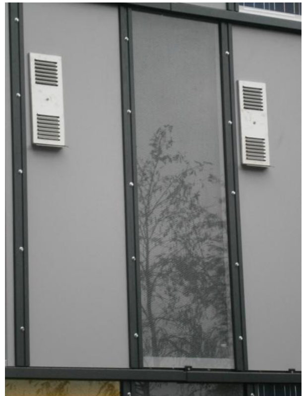
Abbildung 3: Lüftungselemente in der Fassade GIWOG
