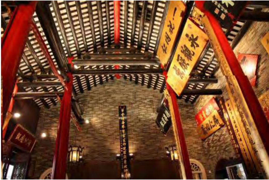
大堂內的中式桁架結構
