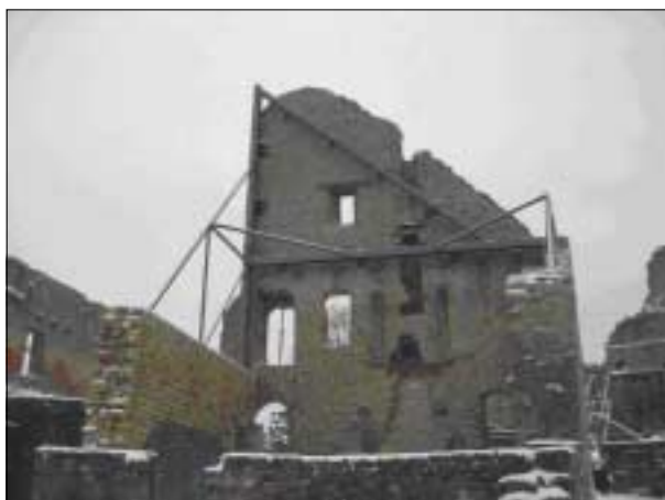
Vue d'ensemble de la structure métallique
