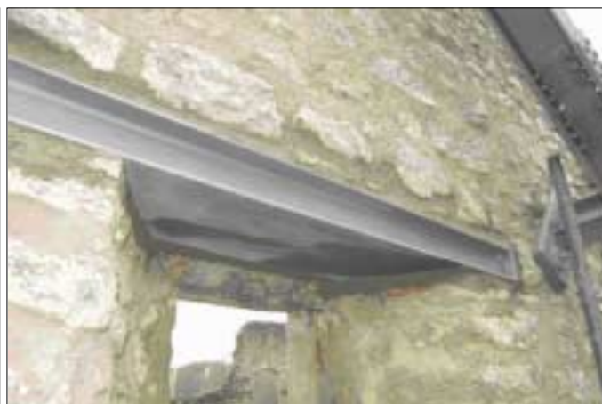
Vue d'un détail de consolidation
