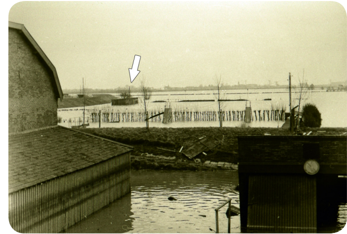
Terrein aan de Molendijk afgelast wegens wateroverlast. Het dak van de kantine is nog juist zichtbaar (zie pijl).
