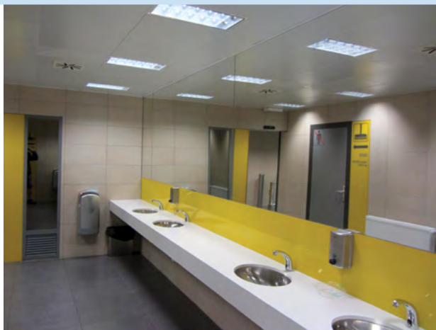
UMÝVÁRNA VE STANICI METRA ANDĚL (NA KNÍŽECÍ) PŘED A PO REKONSTRUKCI
