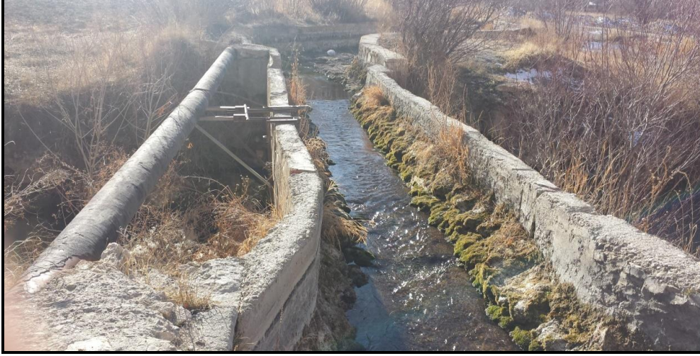
Foto 2. Hoşap Çayı Üzerinden Şamram Kanalındaki Suyun Geçişini Sağlayan Su Kemeri
