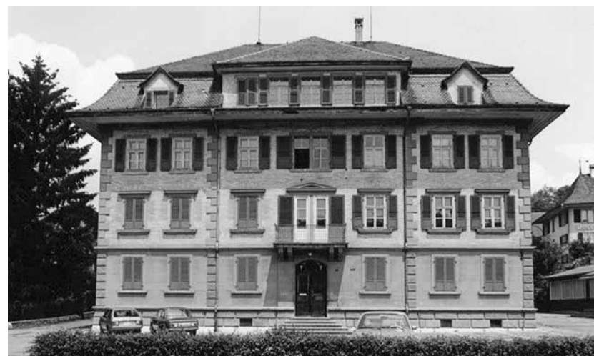
Primar- und Sekundarschulhaus an der Bahnhofstrasse (Baujahr 1878).
