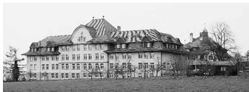
Seitenansicht Hauptgebäude Landwirtschaftliche Schule Schwand, Münsingen (Baujahr 1912–1914).
