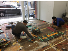
Wai Kong Lui en team die de vloer van P1 aan het verwijderen zijn, New York, 30 May 2017.
