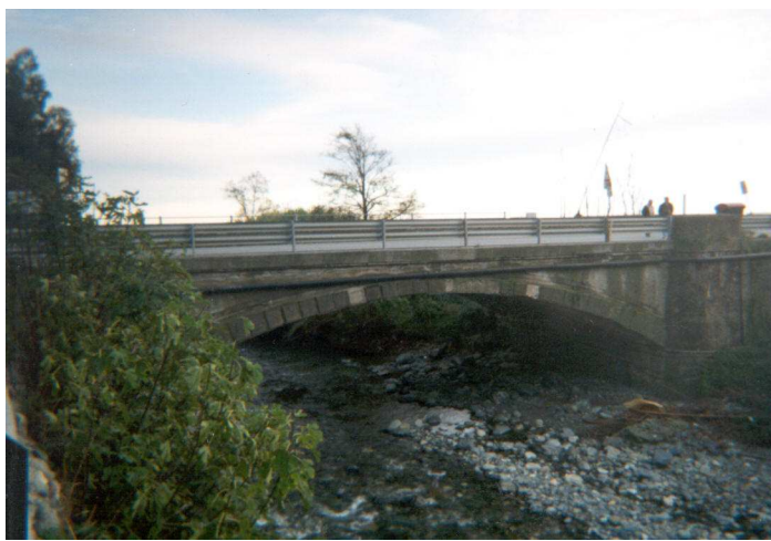
Ponte stradale SS Aurelia da monte verso valle.
