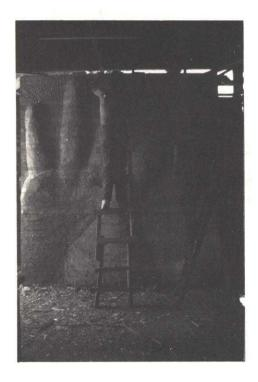
y platinas de fierro. Están abisagradas con sistema de quicios y montadas sobre rodamientos. Se le calculó a cada hoja un peso entre 350 y 400 kg.
