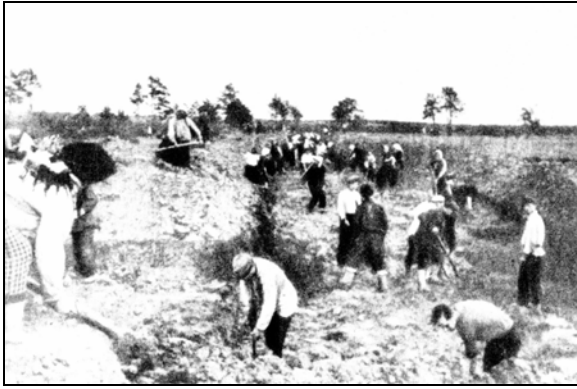
Магіляўчане на будаўніцтве абарончых збудаванняў.
