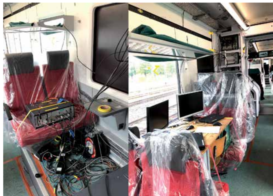
Verkabelungen für verschiedene Tests während der Testfahrten Verkabelungen für verschiedene Tests während der Testfahrten / Arbeitsplatz von PROSE - Bügelmessfahrten
