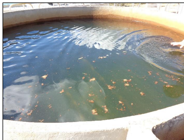
Foto 6. Presença de flocos nos filtros da ETA Pará
