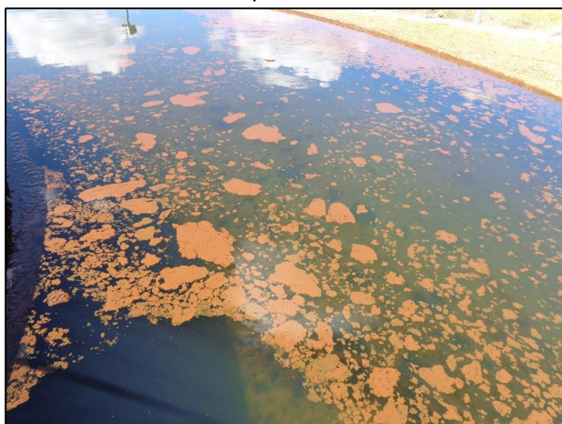
Foto 5. Presença de flocos suspensos nos decantadores da ETA Pará
