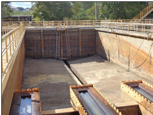
Foto 3. Melhorias sendo implantadas na ETA Itapecerica
