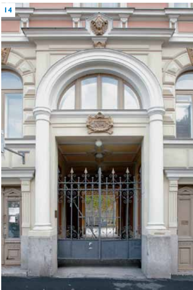
Metalliportti on alkuperäinen. Se on kunnostettu 1987-1991.
