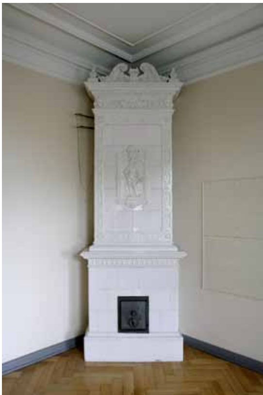
4. kerroksen huoneen 408 kaakeliuuni.
