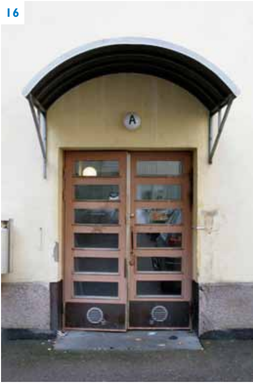
A-portaan sisäpihanpuoleinen sisäänkäynnin kohta siirrettiin 1987-1991 ja ovet ovat täältä ajalta.
