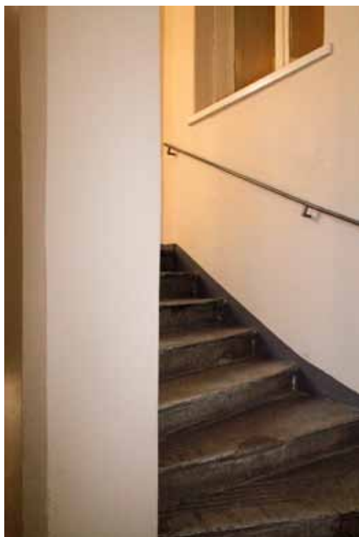
Pohjakerroksen ja 1. kerroksen välissä alkuperäinen E-porras on säilynyt.
