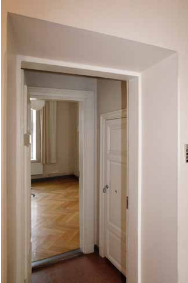
5. kerroksen toimistohuoneessa 518 on on jäljellä alkuperäisiä komerotiloja.
