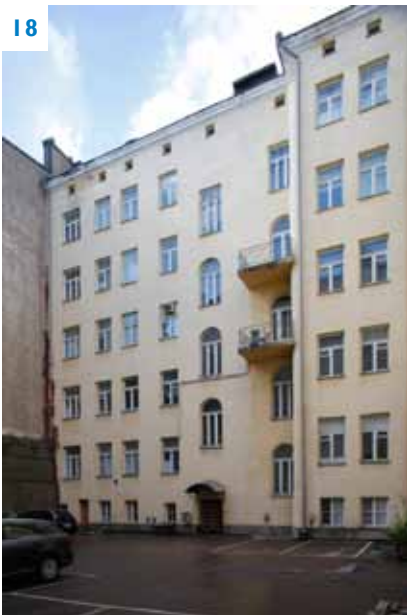
Rakennuksen länsisiiven sisäpihajulkisivu.
