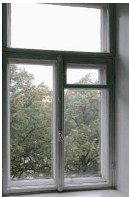
4. kerroksen perinnehuoneen 410 ikkuna.
