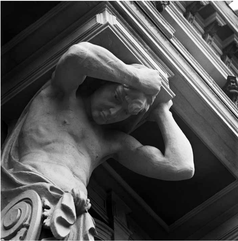
Korkeavuorenkadun puoleisen parvekkeen kannatinpylväs. Kuvaaja Pekka Kyytinen. HKM KA.
