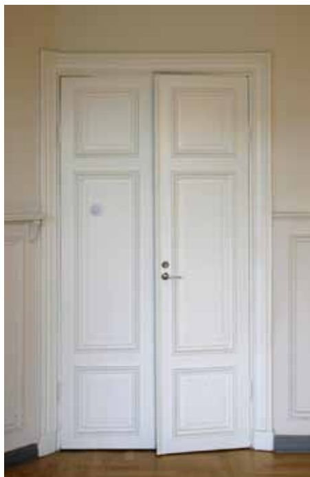
3. kerroksen toimistohuoneen 314 pariovi.
