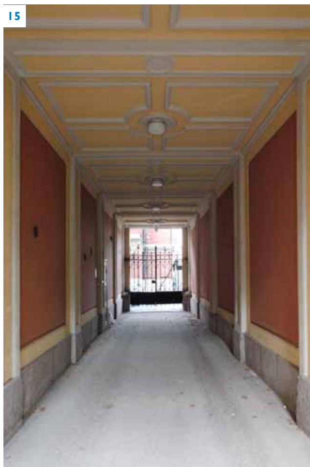
Näkymä sisäpihalta porttikäytävään kohti Punanotkonkatua.
