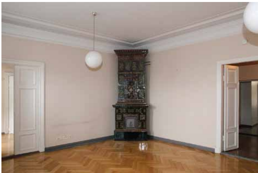
Nykytilavalokuva huoneesta 411. Huoneessa on säilynyt alkuperäinen parketti, kaakeliuuni, pariovet ja kattolistat, mutta koristeelliset kattomaalaukset ja seinätapetit on menetetty.
