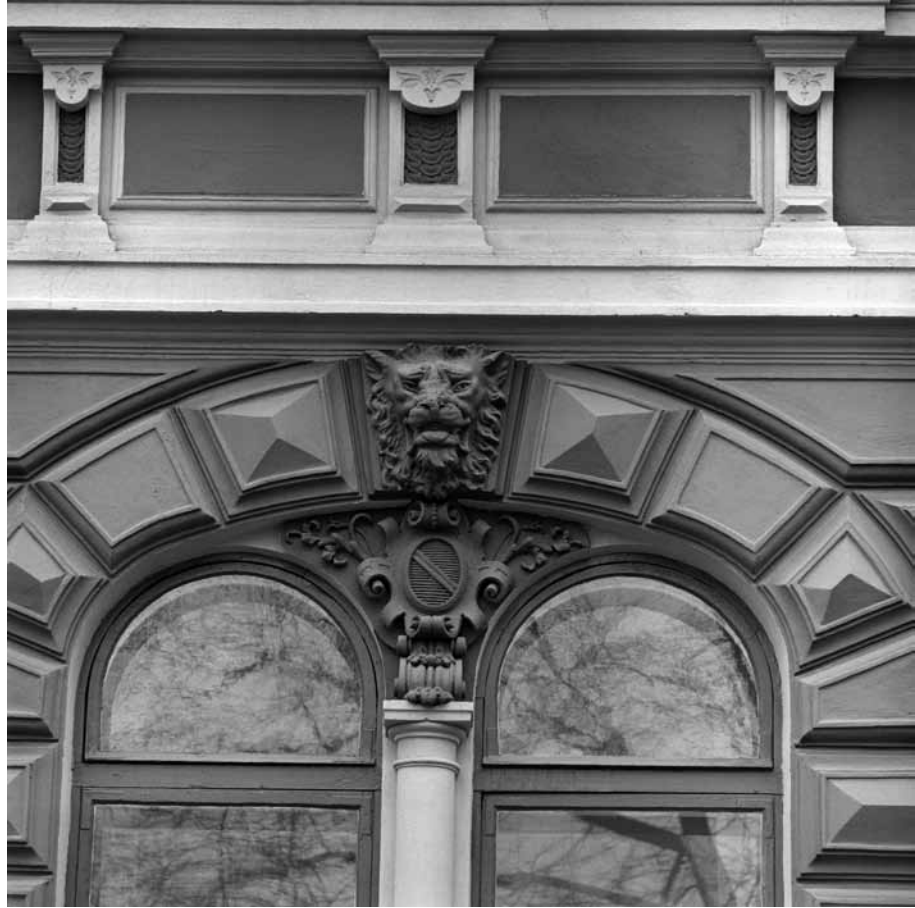
Punanotkonkadun puoleisen julkisivun detaljikoristelua. Kuvaaja Pekka Kyyti- nen. HKM KA.
