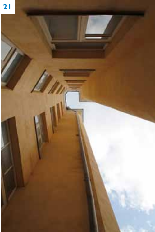
Näkymä rakennuksen vanhan osan kulmasta sisäpihan puolelta.
