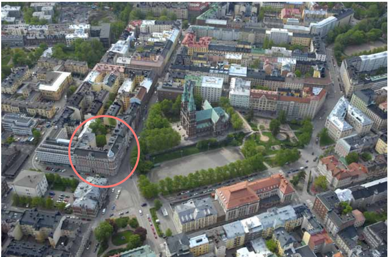
Viistokuva ilmasta vuodelta 2011. © Kaupunkimittausosasto, Helsinki.
