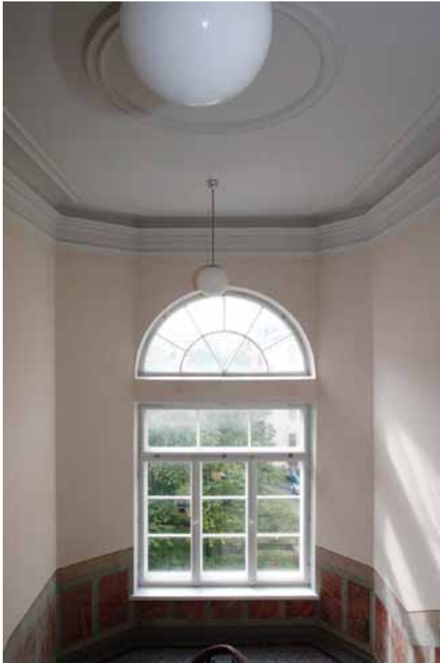
B-portaan ikkuna sisäpihalle.
