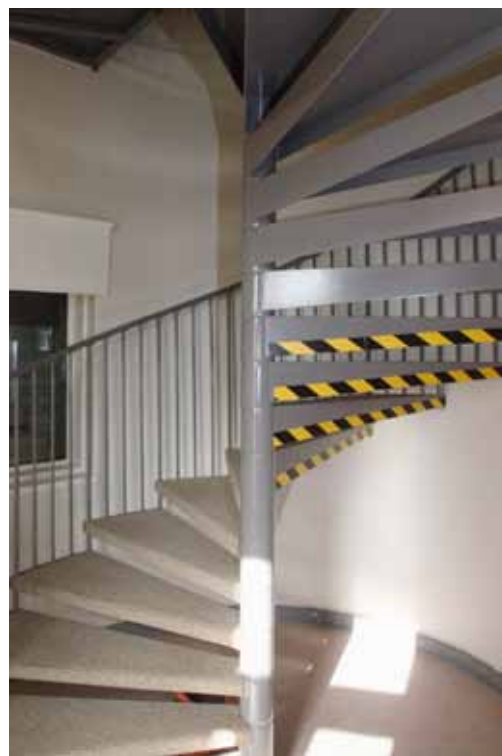
5. kerroksesta ullakolle johtaa 1987-1991 asennettu teräksinen kierreporras.
