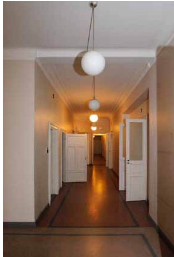
Kolmannen kerroksen Korkeavuorenkadun puoleinen käytävänäkymä. Katossa on pallovalaisimia. Lattiat ovat linoleumia. Suuri osa sisäovista on vanhoja.
