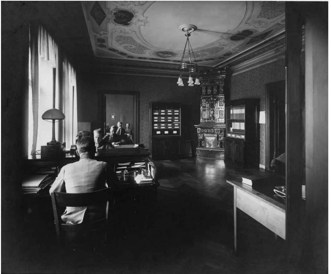
Valokuva neljännen kerroksen huoneesta 411. Kuva on todennäköisesti ajalta 1921-1931, jolloin rakennus oli puolustusministeriön ja yleisesikunnan käytössä. Vasemmalla on ikkunoita Korkeavuorenkadulle. Huoneen kaksi parioviparia on tallella, mutta nykyisin ne on maalattu valkoisiksi. Huoneen katon on maalattu koristeellisesti ja katon keskellä on ruusuke ja riippuvälaisin. Huoneen nurkassa on koristeellinen kakluuni, joka on edelleen paikallaan. Myös kalanruotoparketti on säilynyt. Sotamuseo.
