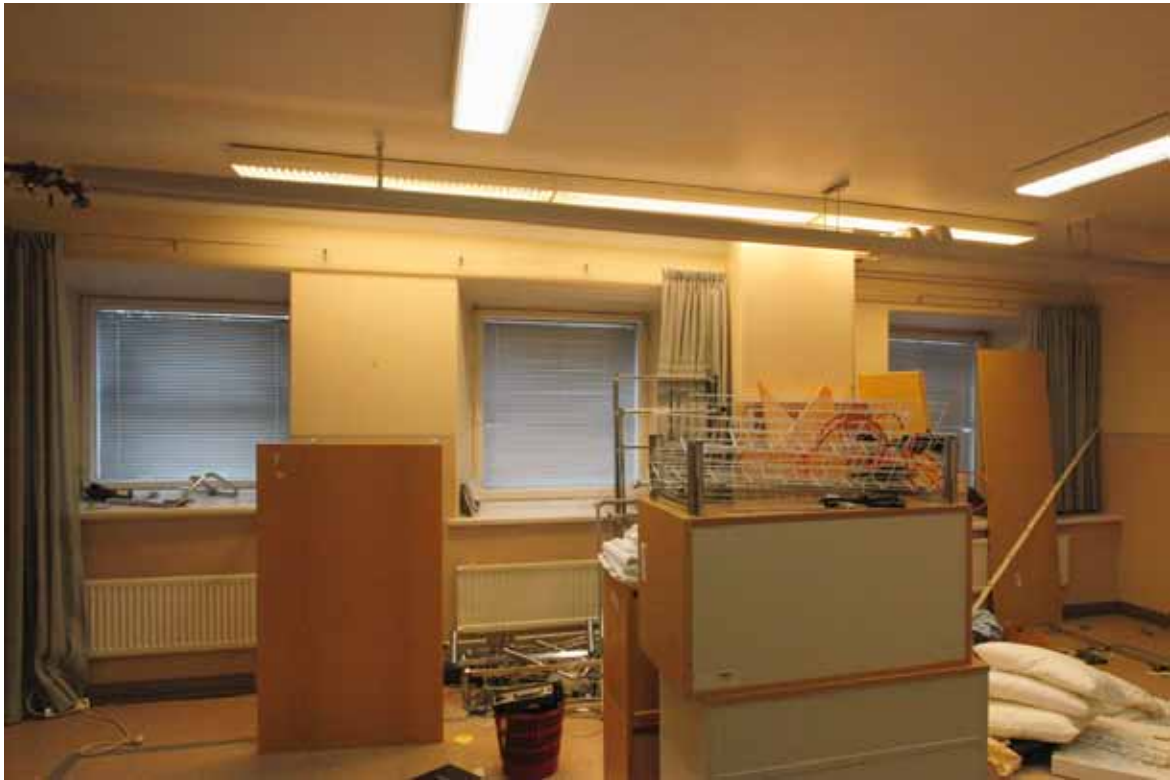
Pohjakerroksessa on alunperin sijainnut liiketiloja ja käsityöläisverstaita. Lattiaa on korotettu 1987-1991. Kerroksen sisäilmaongelmien takia se on käyttökiellossa.
