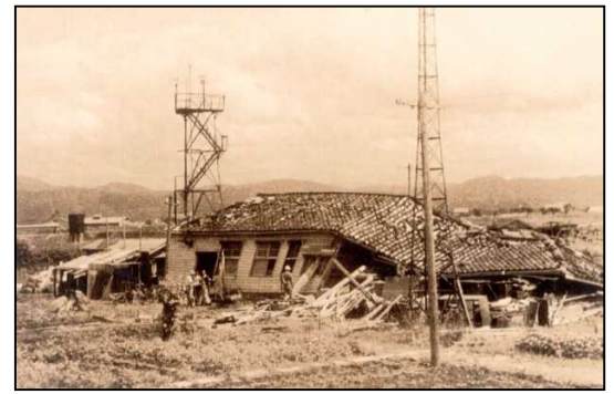
旧福井地方気象台の庁舎全壊写真
