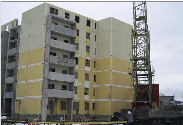
Строящийся дом в г. Екатеринбург
