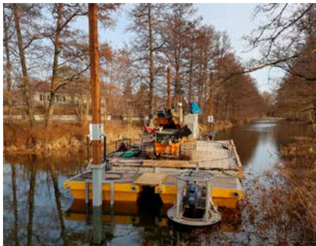
Projektet att bygga bort vandringshinder i Trosaån ska framja vattnets ekosystem.
