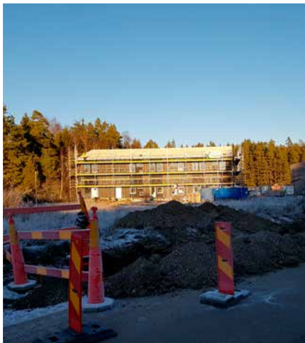
I anslutning till Bråta Allé byggde Dibbers ny förskola 2019.
